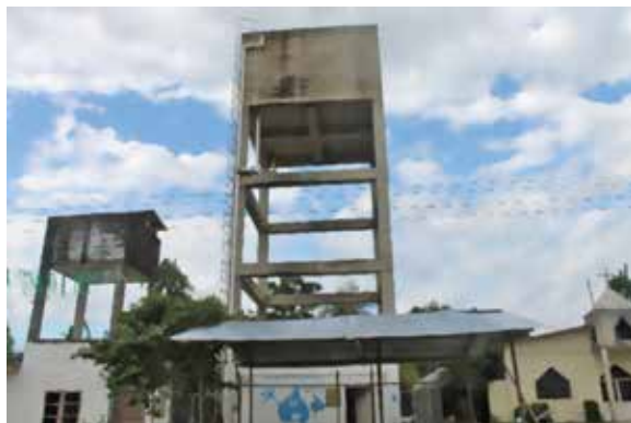
Figura 14. Acueducto de la comunidad de San Sebastián de los Lagos. Fotografía tomada por Upegui, M., en mayo de 2016.
