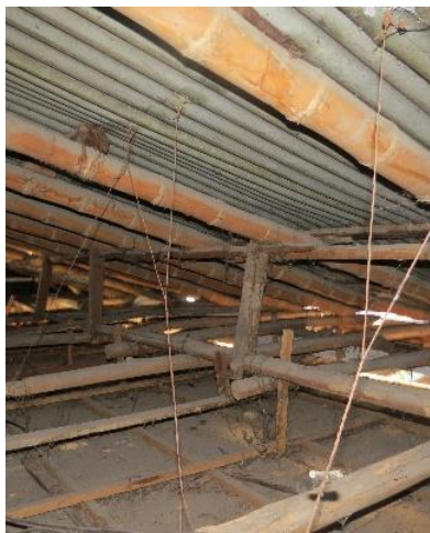
Ilustración 20. Correas de guadua apoyadas en estructura original Fuente. Propia.
