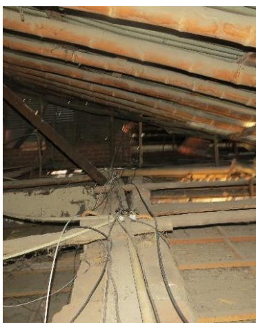
Ilustración 22. Redes eléctricas sobre estructura de madera de cubierta. Fuente. Propia
