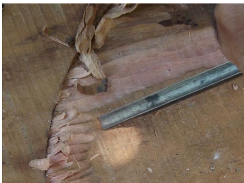
Ilustración 41. Ensayó con gubia en la cercha de madera de cubierta. Fuente propia
