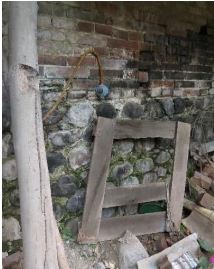
Ilustración 17. Cimentación en concreto ciclópeo. Fuente Propia
