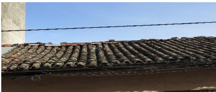
Ilustración 18. Cubierta frontal en teja de barro. Fuente Propia
