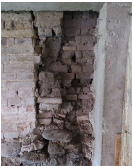
Ilustración 16. Mampostería En Adobe Y Cimentación En Ciclópeo Parte Del Sótano. Fuente Propia
