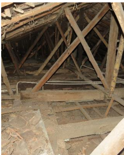
Ilustración 19. Apuntalamiento provisional con guadua sobre cercha tipo rey. Fuente. Propia.
