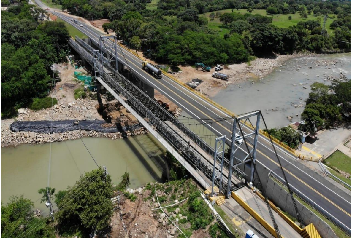
Figura 38 Vista Aérea Puentes INVIAS 1 y Peatonal
