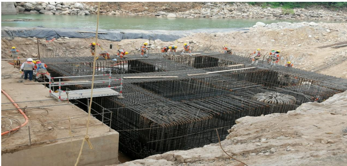
Figura 24 Armado Zapata Eje 3 Puente sobre Río Charte 2da Etapa
