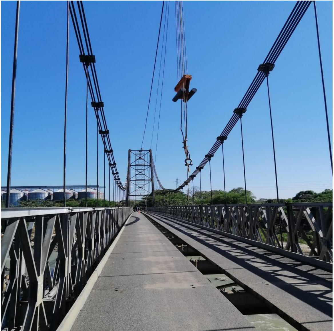
Figura 10 Puente Colgante INVIAS 2 y Teleférico
