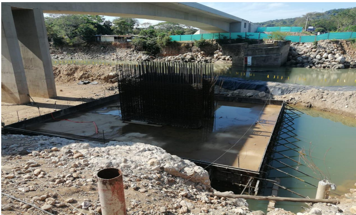
Figura 26 Fundida en Concreto de Zapata Eje 3 Puente sobre Río Charte 2da Etapa
