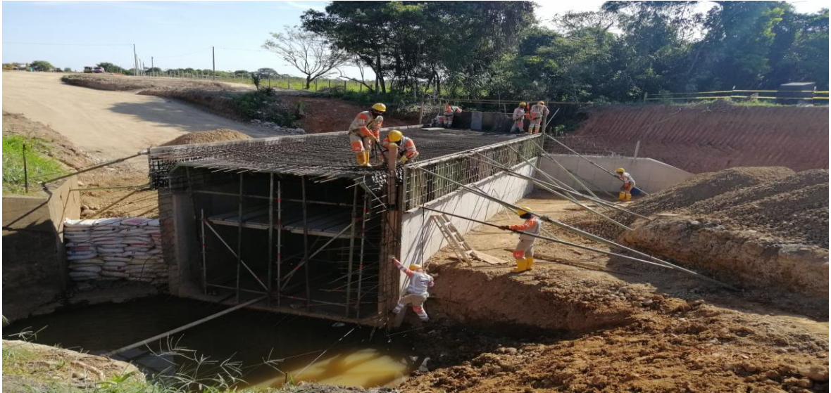
Figura 28 Armado y Fundida de Box Culvert
