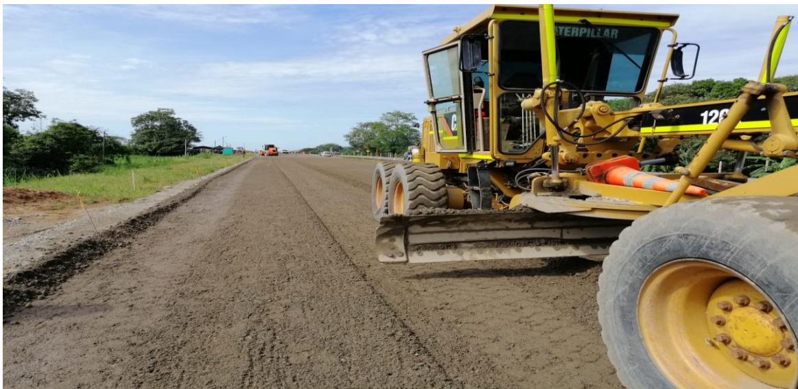
Figura 21 Extendida y compactación de Material con Motoniveladora y vibrocompactadores
