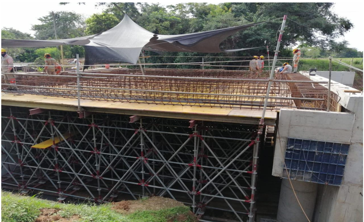
Figura 20 Armado de Placa Ponton La Ceiba
