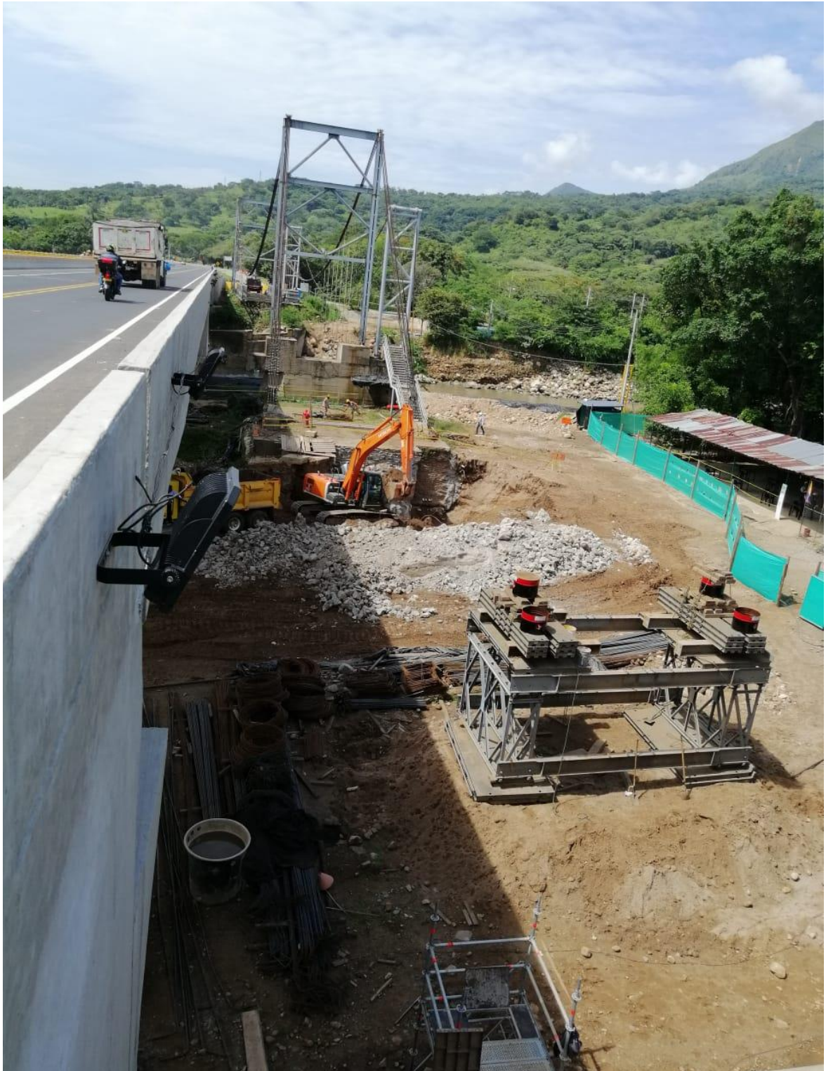
Figura 36 Desarme de Puente Modular INVIAS 1 y Peatonal N°1
