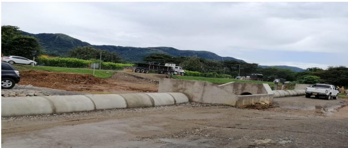
Figura 25 Alcantarillado con Canal Intermedio
