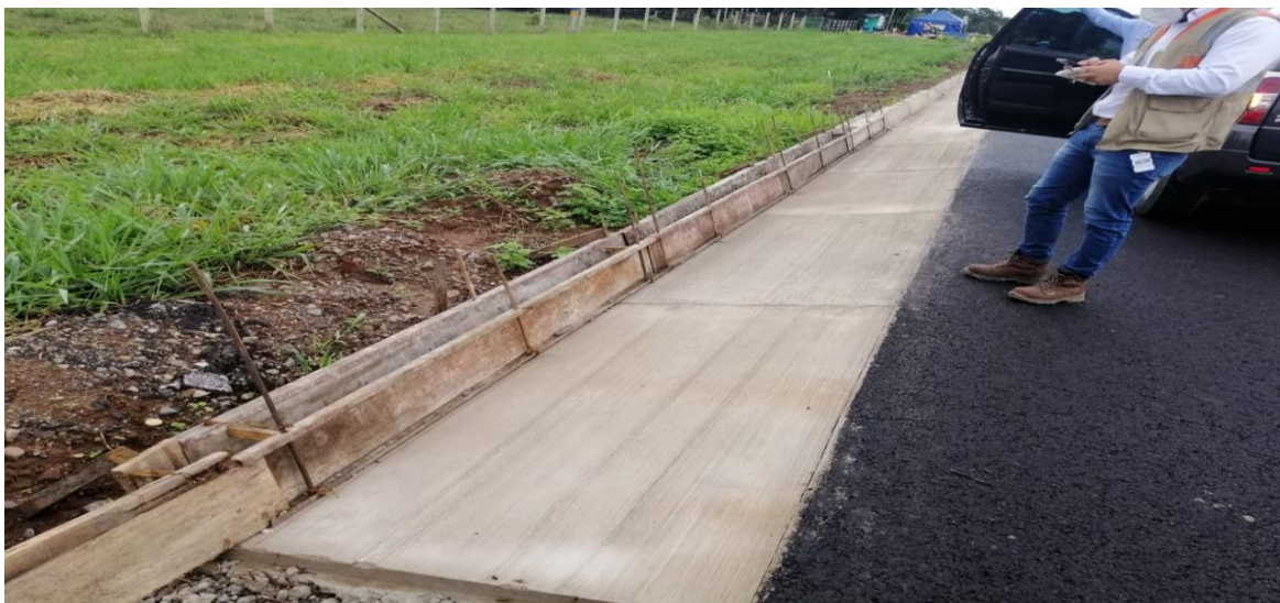
Figura 22 Construcción Cunetas de Drenaje
