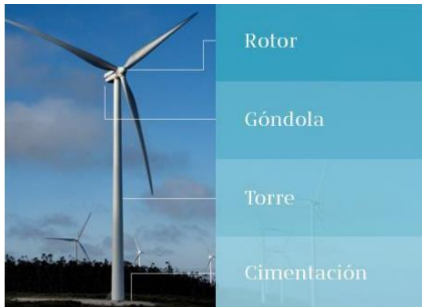
Figura 12. Partes de un aerogenerador tripala.
