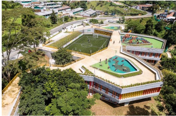
Figura 36. UVA San Antonio de Prado. (Arquitectura, 2015)
