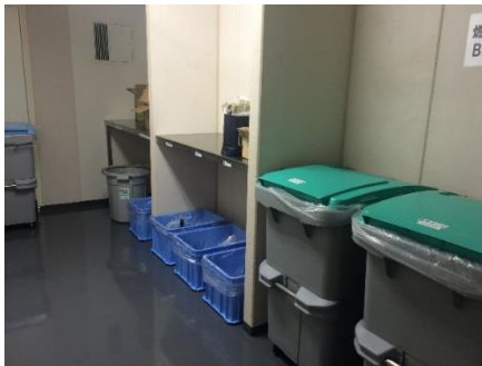
Figura 72. Cuartos de aseo. (Ecocontenedores, 2015)
