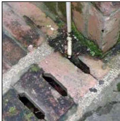
Figura 96. Tubería aire acondicionado.
