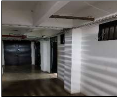
Figura 25. Fuente: autores, (mayo de 2018). Placa entrepiso primer nivel sótano, edificio Alcaldía de Yopal.
