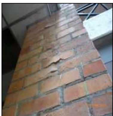
Figura 63. Desintegración de material.
