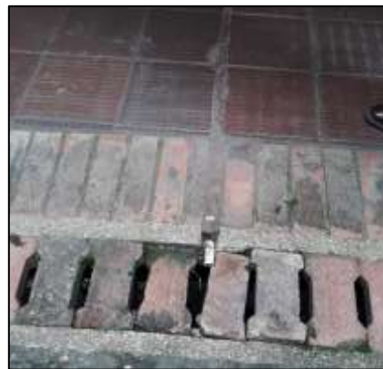
Figura 97. Tubería aire acondicionado.
