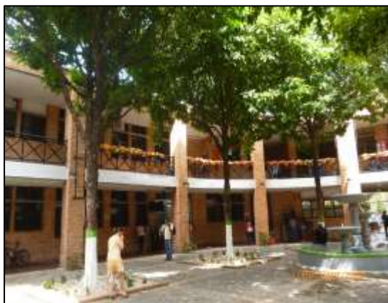
Figura 12 Columnas internas área Tesorería.,
