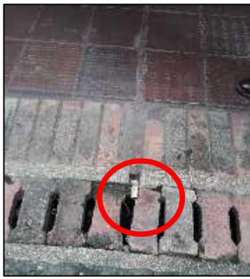
Figura 94. Desagüe de tubería.
