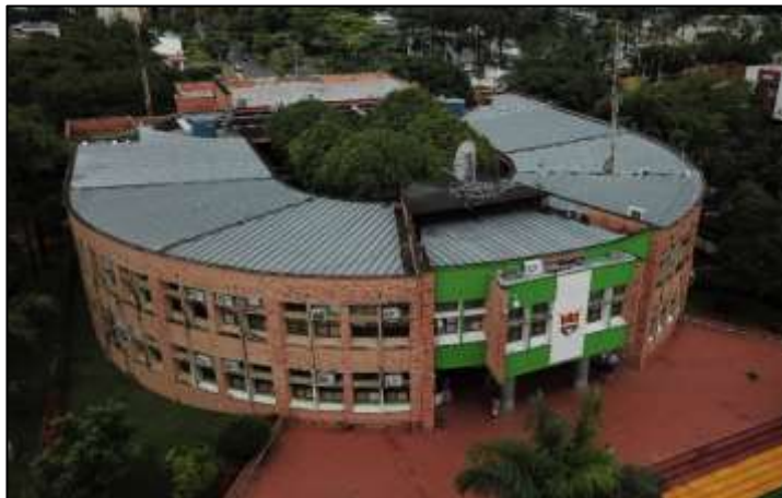
Figura 5. fuente: autores, (2018), fachada en ladrillo a la vista, Alcaldía de Yopal, julio 13 2018.
