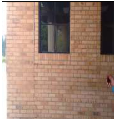
Figura 41. Grieta columna 2.
