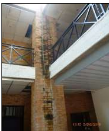
Figura 73. Humedad elemento 8.
