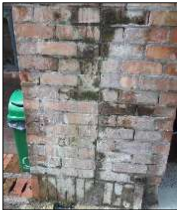
Figura 79. Eflorescencias elemento 8.
