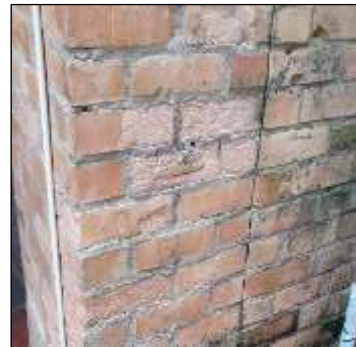
Figura 34. Desintegración del elemento.
