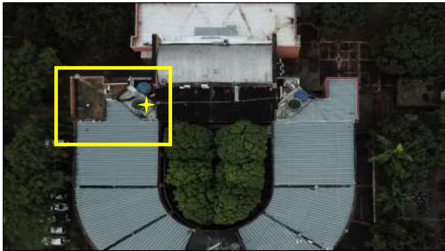
Figura 84. Fuente: autores, (12 de Julio 2018), Área afectada por acumulación de agua Alcaldía Yopal.
