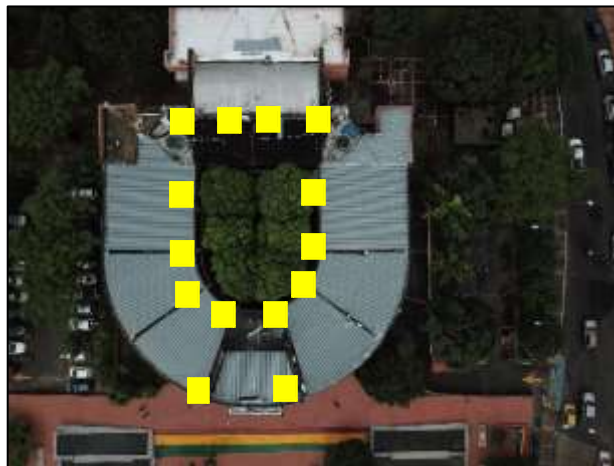
Figura 48. Fuente: autores, (julio de 2018). Ubicación de las columnas a las cuales se les analizó el ladrillo de revestimiento- vista aérea, alcaldía municipal Yopal.
