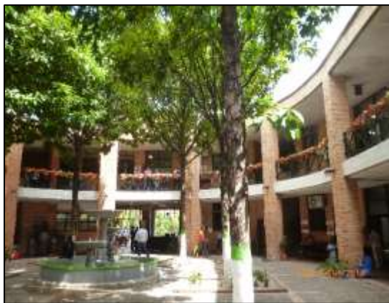
Figura 14. Revestimiento de columnas internas.
