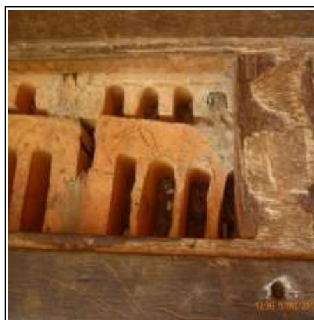
Figura 7 Tipo de ladrillo perforado usado en muros.
