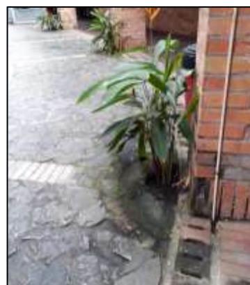
Figura 86. Humedad por capilaridad. Figura 87. Plantas.
