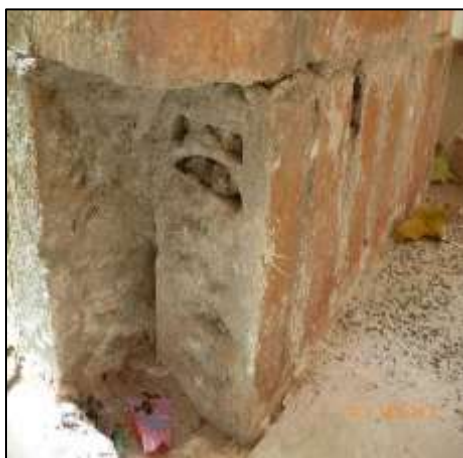
Figura 6 Tipo de ladrillo perforado usado en columnas.
