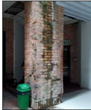
Figura 78. Elemento 8 eflorescencias.
