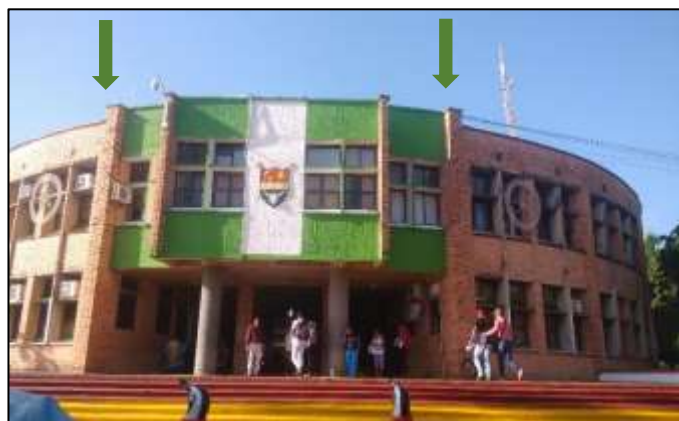
Figura 16. Fuente: autores, (enero 2018) Columnas externas, Alcaldía de Yopal.
