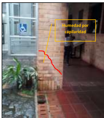
Figura 86. Humedad por capilaridad. Figura 87. Plantas.
