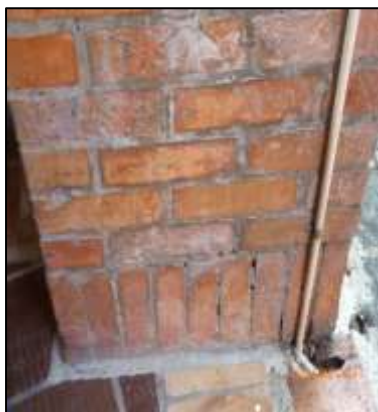
Figura 60. Eflorescencia tipo 1.
