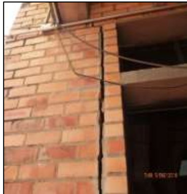
Figura 42. Grieta columna 2.
