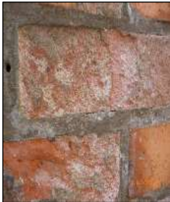
Figura 61. Eflorescencia tipo 1 y 2.
