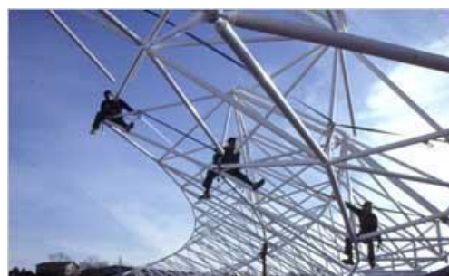
Ilustración 20. Puesta en obra de Estructuras Espaciales
