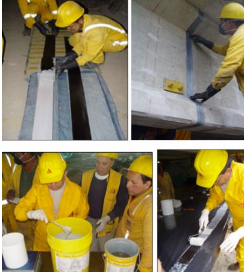
Figura 36. Procedimiento instalación tejidos de fibra de carbono. Fuente: (Mosquera, 2015)
