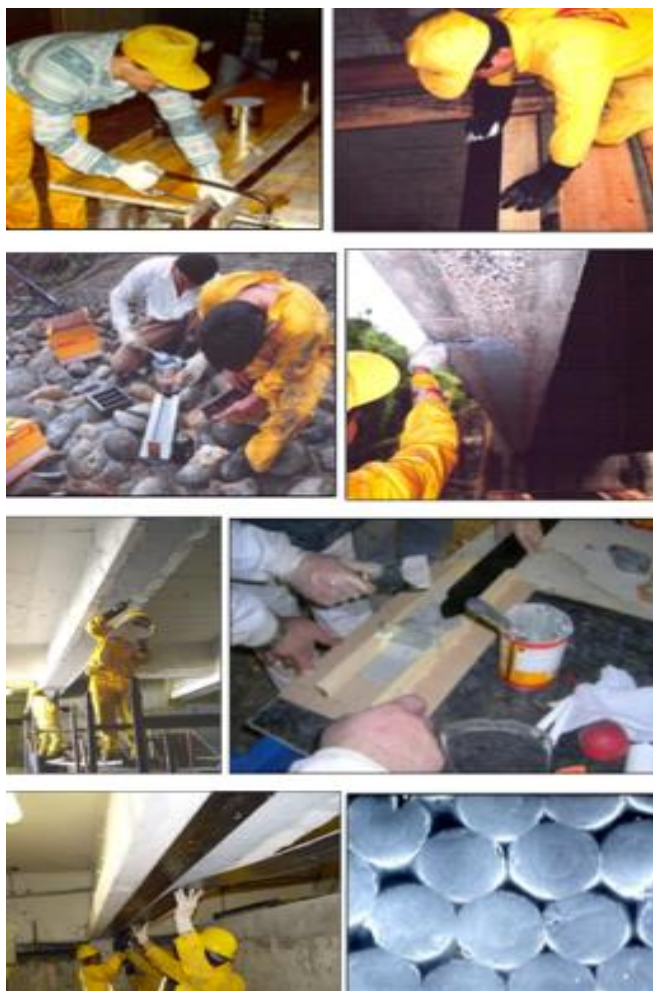
Figura 35. Procedimiento instalación platinas de fibra de carbono. Fuente: (Mosquera, 2015).
