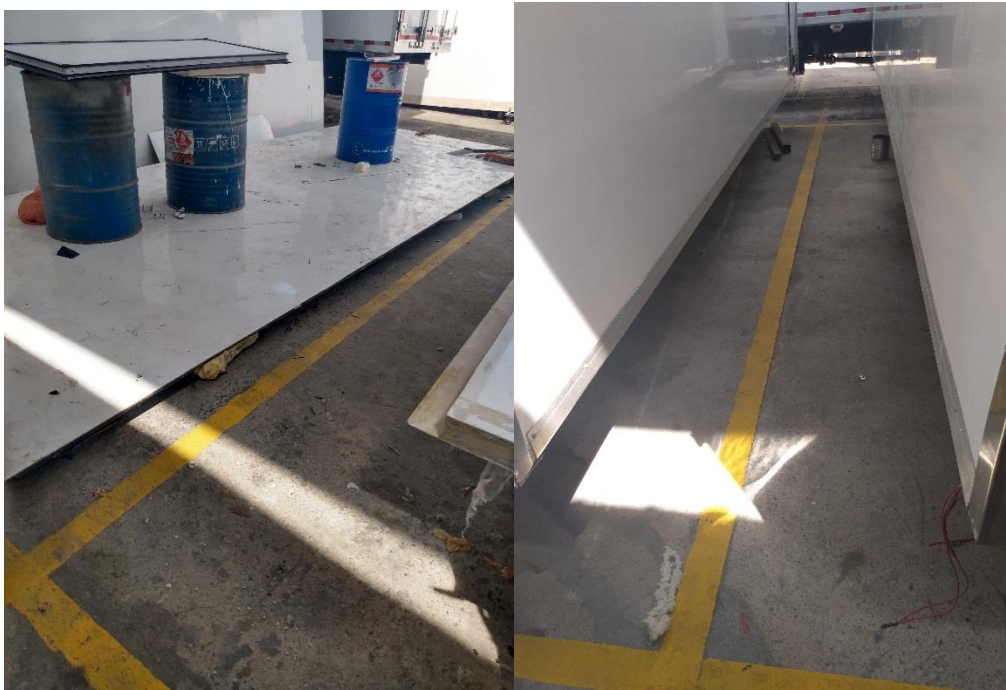
Figura 18. Área de laminado demarcada.
