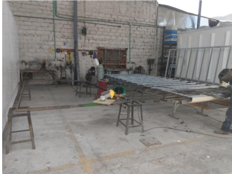
Figura 17. Área de laminado antes de la demarcación y adecuación.
