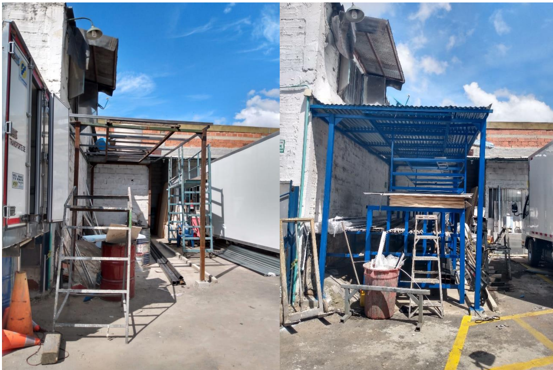
Figura 9. Adecuación de la antigua área de residuos sólidos.
