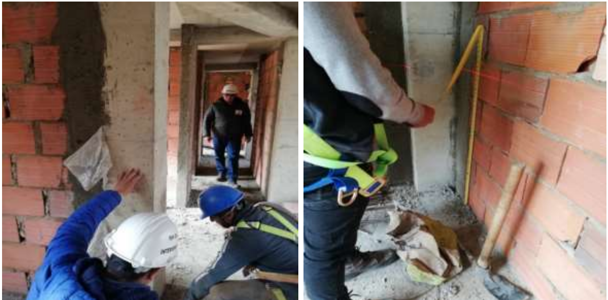
ILUSTRACIÓN 13 VERIFICACIÓN ALINEAMIENTO DE LOS MUROS Y COLUMNAS EMPLEANDO MÁQUINA LASER.
