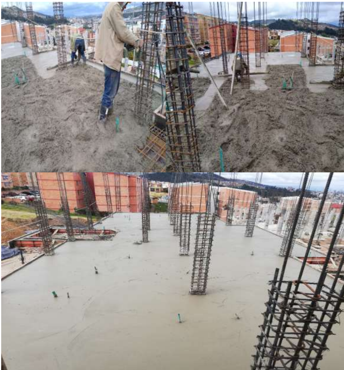
ILUSTRACIÓN 8 ACOMPAÑAMIENTO AL PROCESO DE FUNDIDA DE LOSA DE ENTREPISO
