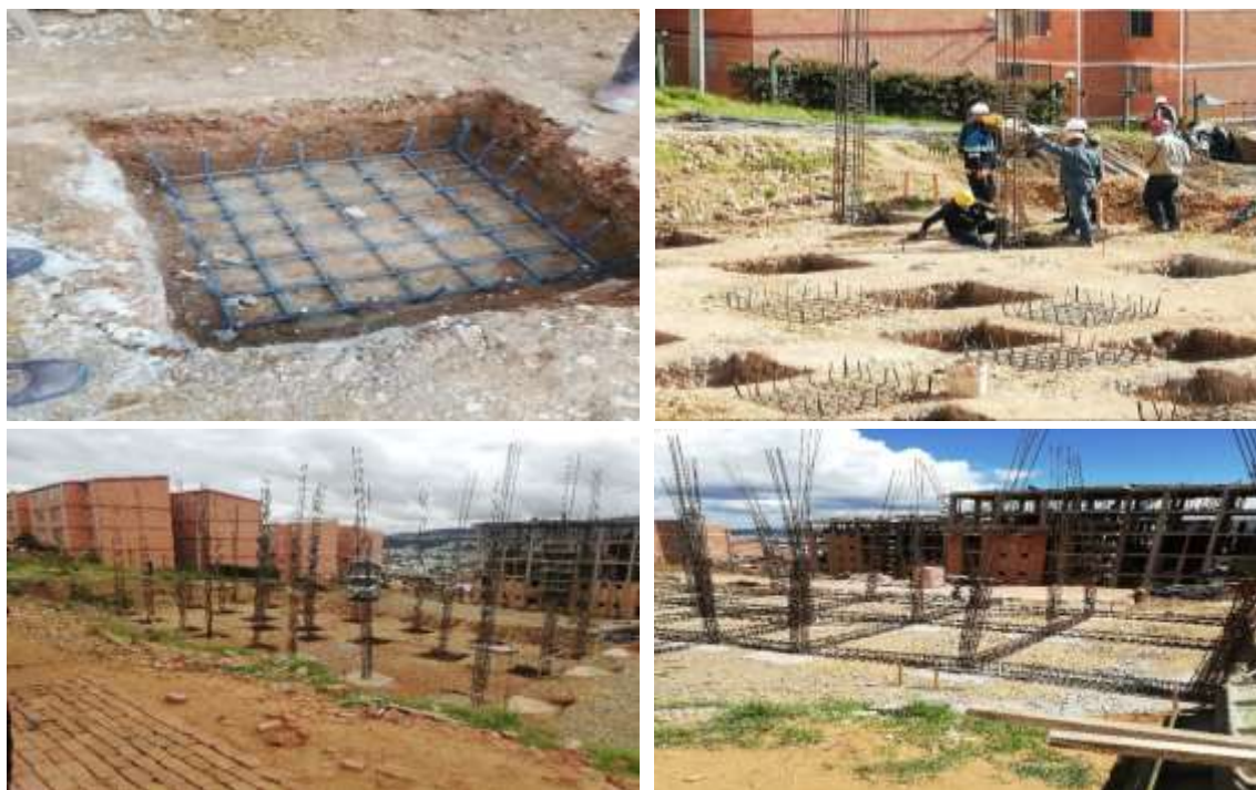
ILUSTRACIÓN 31 ARMADO DE HIERROS DE ZAPATA Y COLUMNAS
