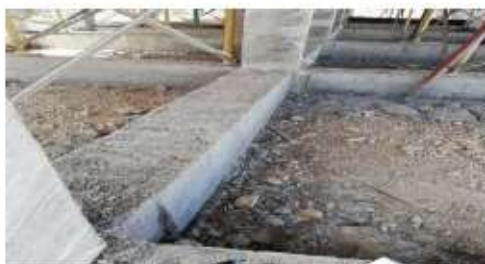
Ilustración 1 Vigas de cimentación BITB
