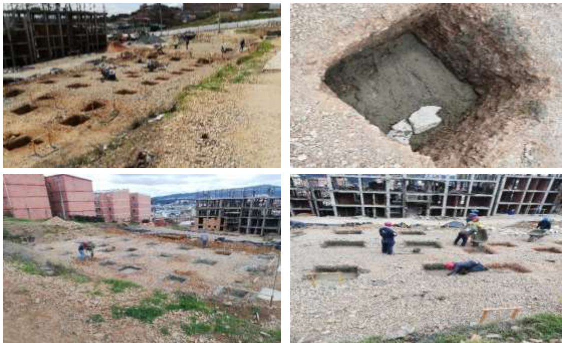
ILUSTRACIÓN 30 EXCAVACIÓN CIMENTACIONES, CONCRETO DE MEJORAMIENTO
