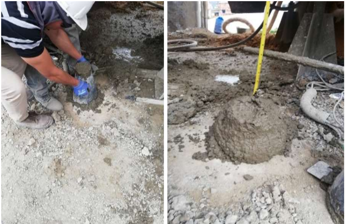
ILUSTRACIÓN 7 ASENTAMIENTO DE CONCRETO USADO EN LOSA ENTREPISO
