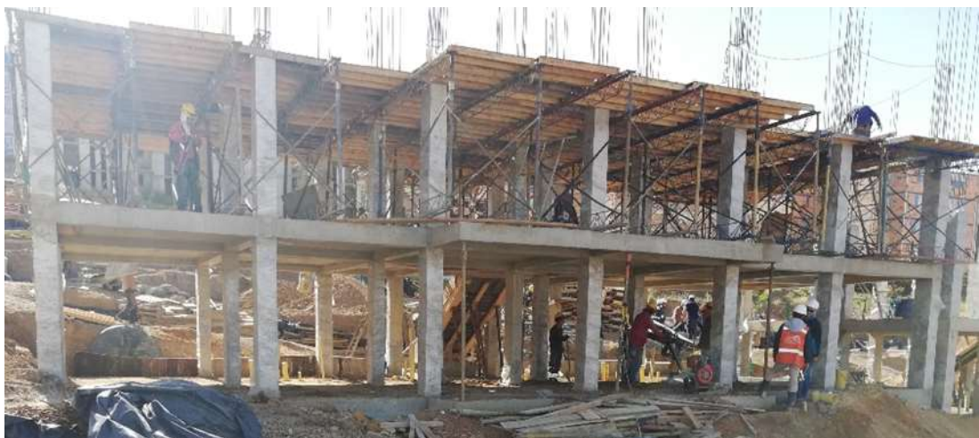
ILUSTRACIÓN 5 SEGUIMIENTO A LA EJECUCIÓN CONSTRUCTIVA PLACA DE CONTRAPISO B4TB
