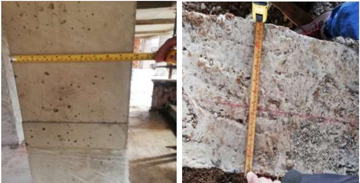
ILUSTRACIÓN 14 VERIFICACIÓN DE DIMENSIONES COLUMNAS Y VIGAS DE CIMENTACIÓN
