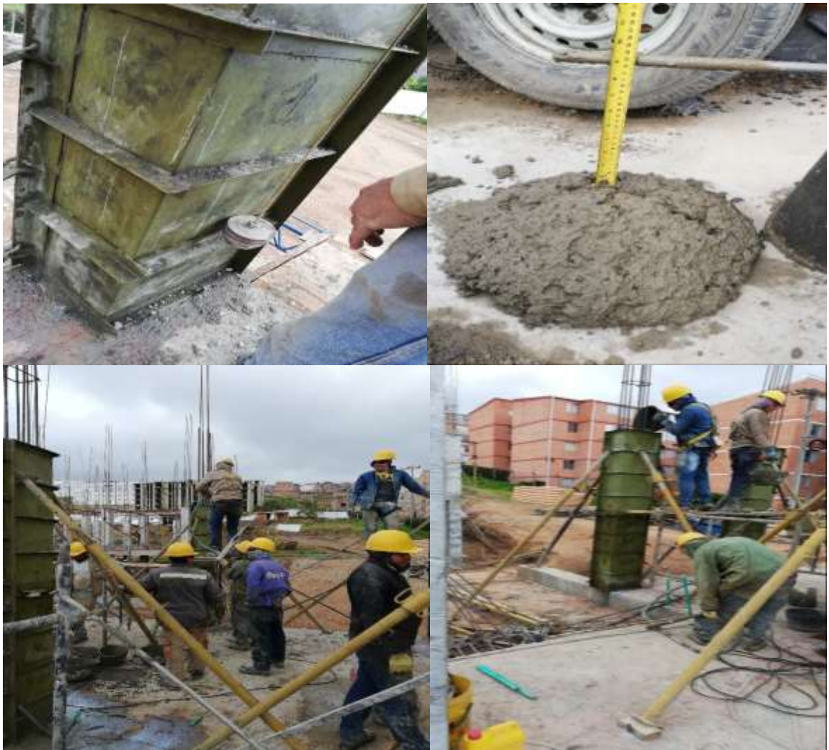
ILUSTRACIÓN 9 VERIFICACIÓN NIVEL DE FORMALETAS Y ACOMPAÑAMIENTO A FUNDIDA DE COLUMNAS
