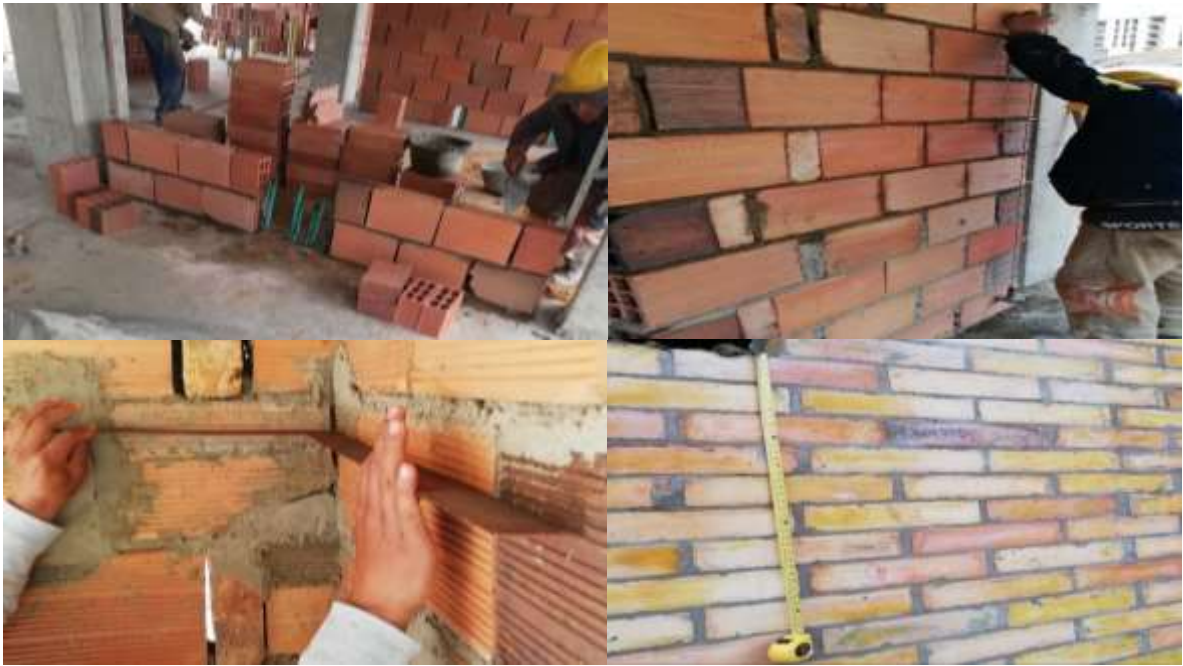
ILUSTRACIÓN 11 VERIFICACIÓN, SEGUIMIENTO A LA EJECUCIÓN CONSTRUCTIVA DE MUROS DE INTERIOR Y EXTERIOR
