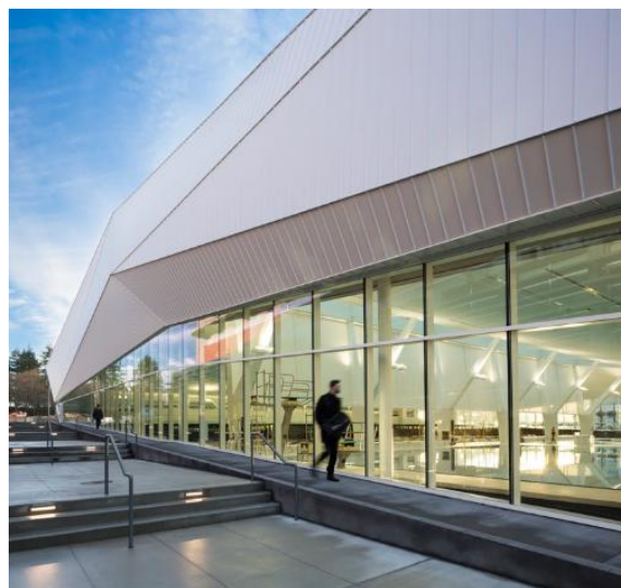
Figura 48. Detalle de fachada en vidrio
