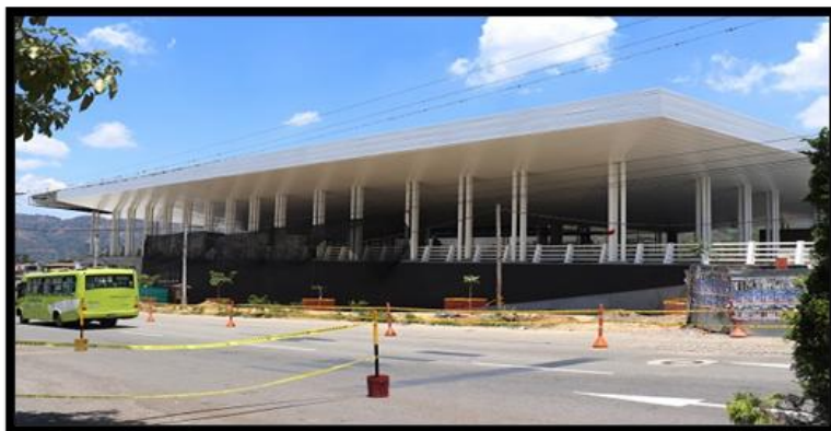
Figura 96. Estación metrolínea “La Temprana”
