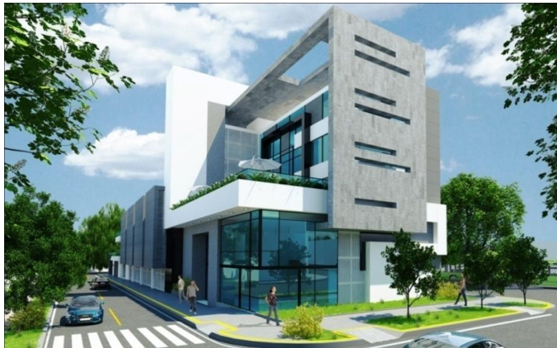
Figura 23. Fachada lateral- oriental.
