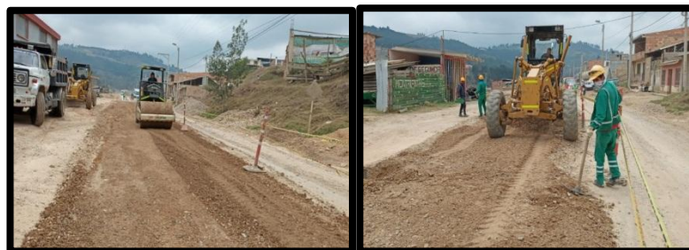
Ilustración 11. Extendida y compactación de subbase granular.
