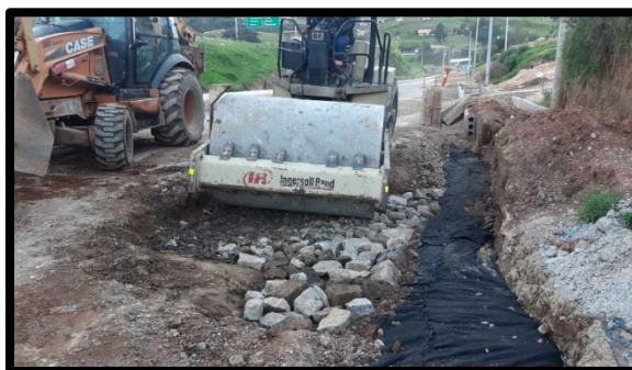
Ilustración 12. Mejoramiento con Pedraplen.
