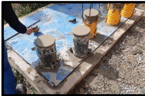
Ilustración 10. Toma de muestras de concreto 3500 psi muro de sumidero Sc2
