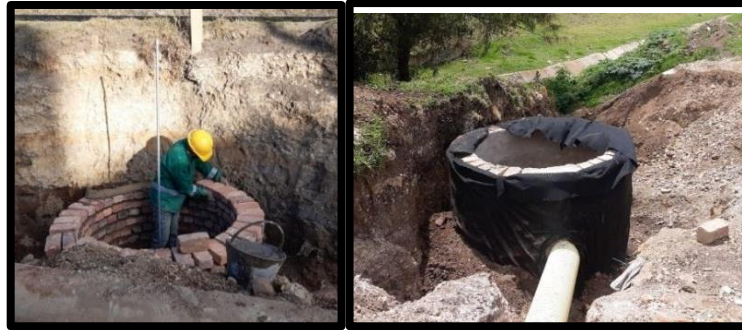
Ilustración 8. Terminación de la construcción de pozos de inspección
