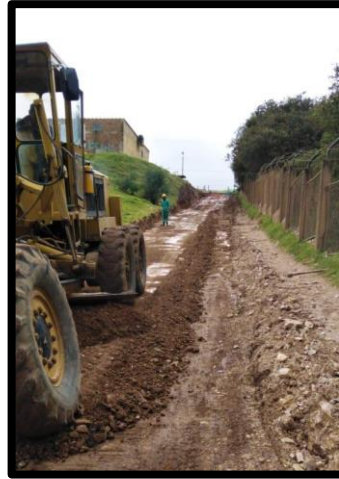
Ilustración 18. Extendida de subbase granular tramo 2.
