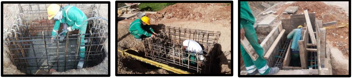
Ilustración 9. Verificación de Construcción sumideros.
