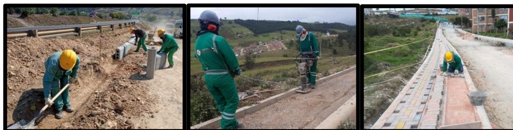
Ilustración 21. Construcción Andén
