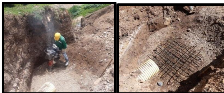
Ilustración 5. Fase de construcción placa de piso pozos de inspección
