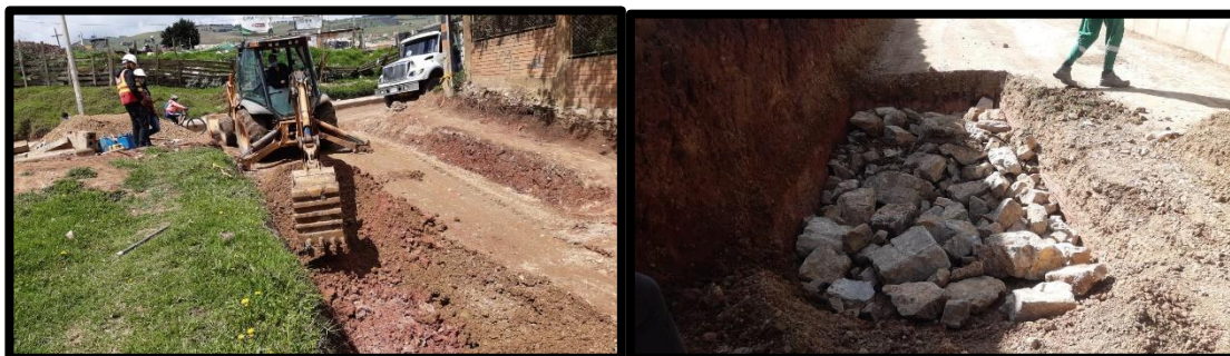
Ilustración 17. Mejoramiento subrasante tramo 2.
