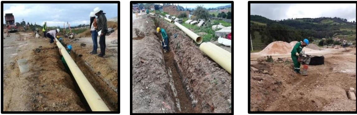
Ilustración 4. Instalación de red de alcantarillado pluvial.
