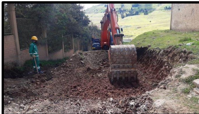
Ilustración 16. Excavación a nivel de subrasante tramo 2.
