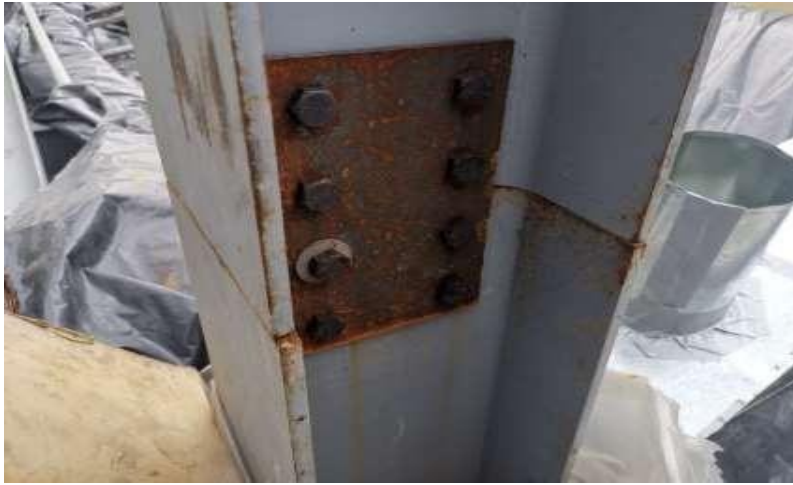
Figura 5. Empalme de columnas
