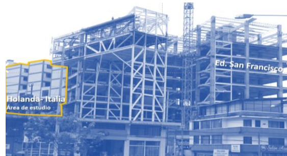
Ilustración 3, Registro Fotográfico Edificio San Francisco. Fuente: Entre Obras SAS, 2016, Nuestra experiencia, Edificio Sicilia CESMAG, https://entreobras.com/portfolio/edificio-sicilia-cesmag
