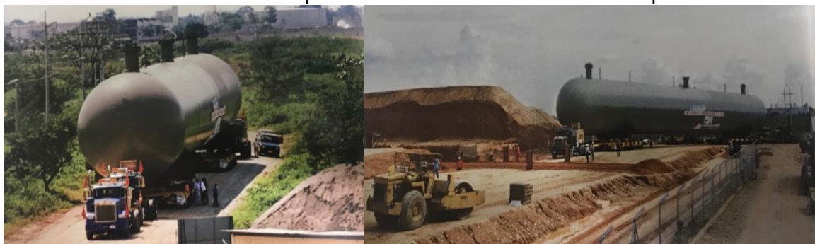
Ilustración 3: Transporte terrestre e instalación de tanques
