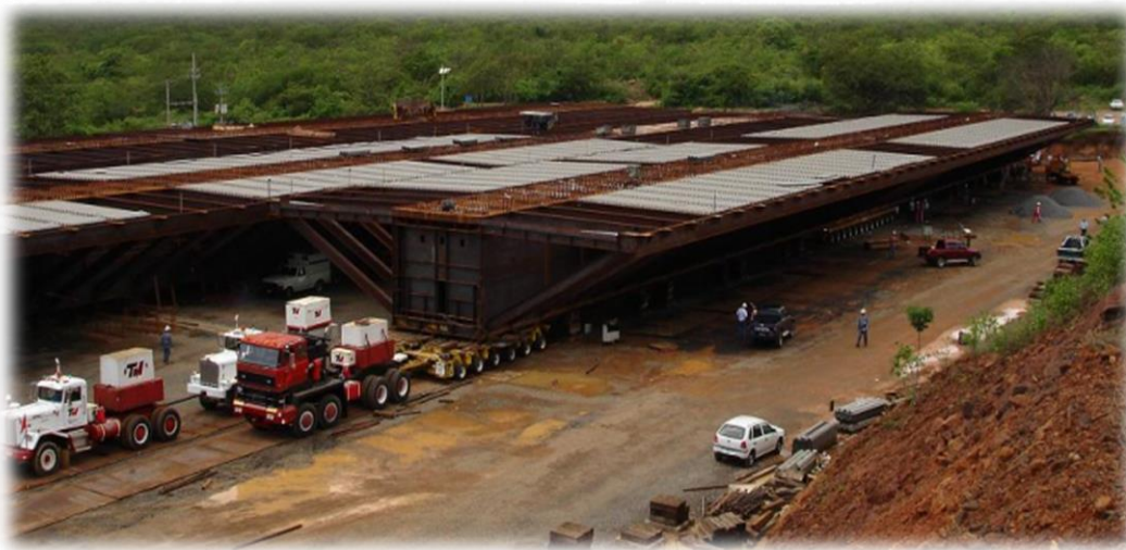
Ilustración 14: Transporte extrapesado y extradimensionado Puente Río Orinoco
