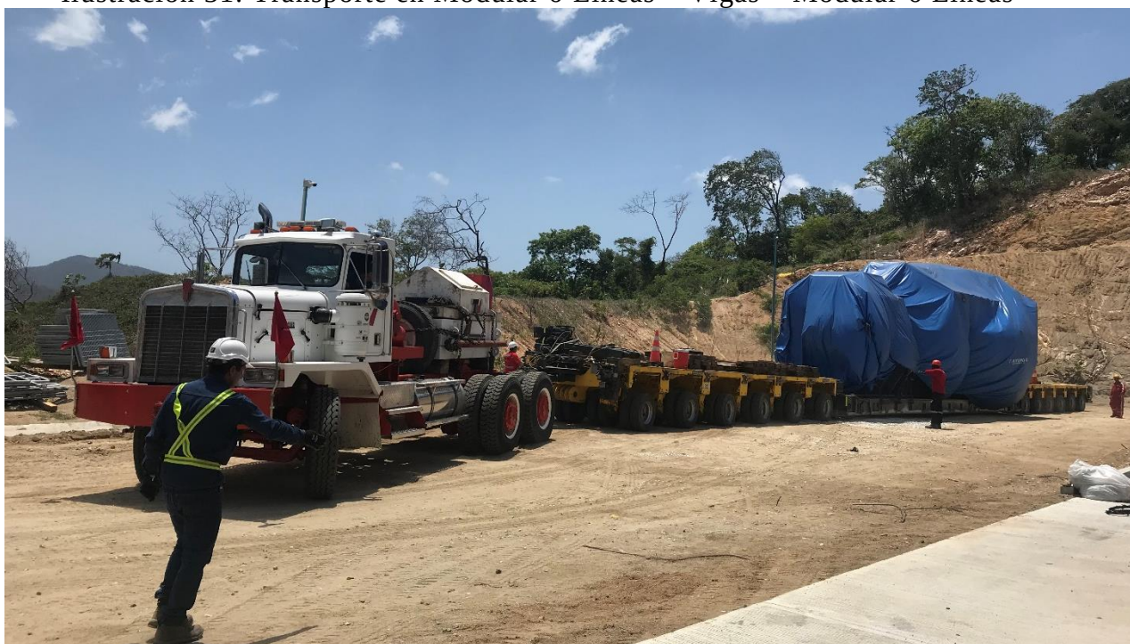
Ilustración 31: Transporte en Modular 6 Líneas – Vigas – Modular 6 Líneas
