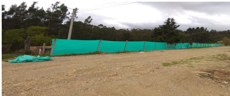
Ilustración 14 Supervisión y Verificación de Cerramiento
