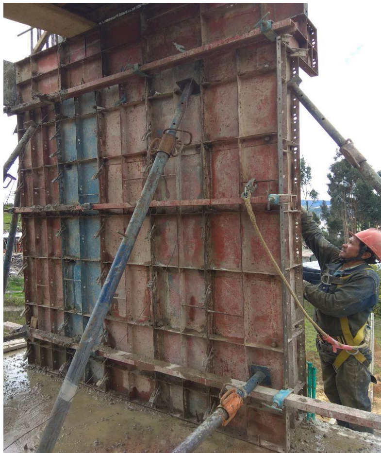
Ilustración 23 Plomado de Muros Nivel 5 - Bloque 3.
