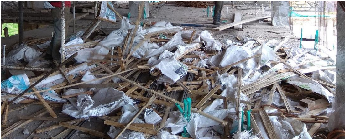
Ilustración 15 Recolección de escombros
