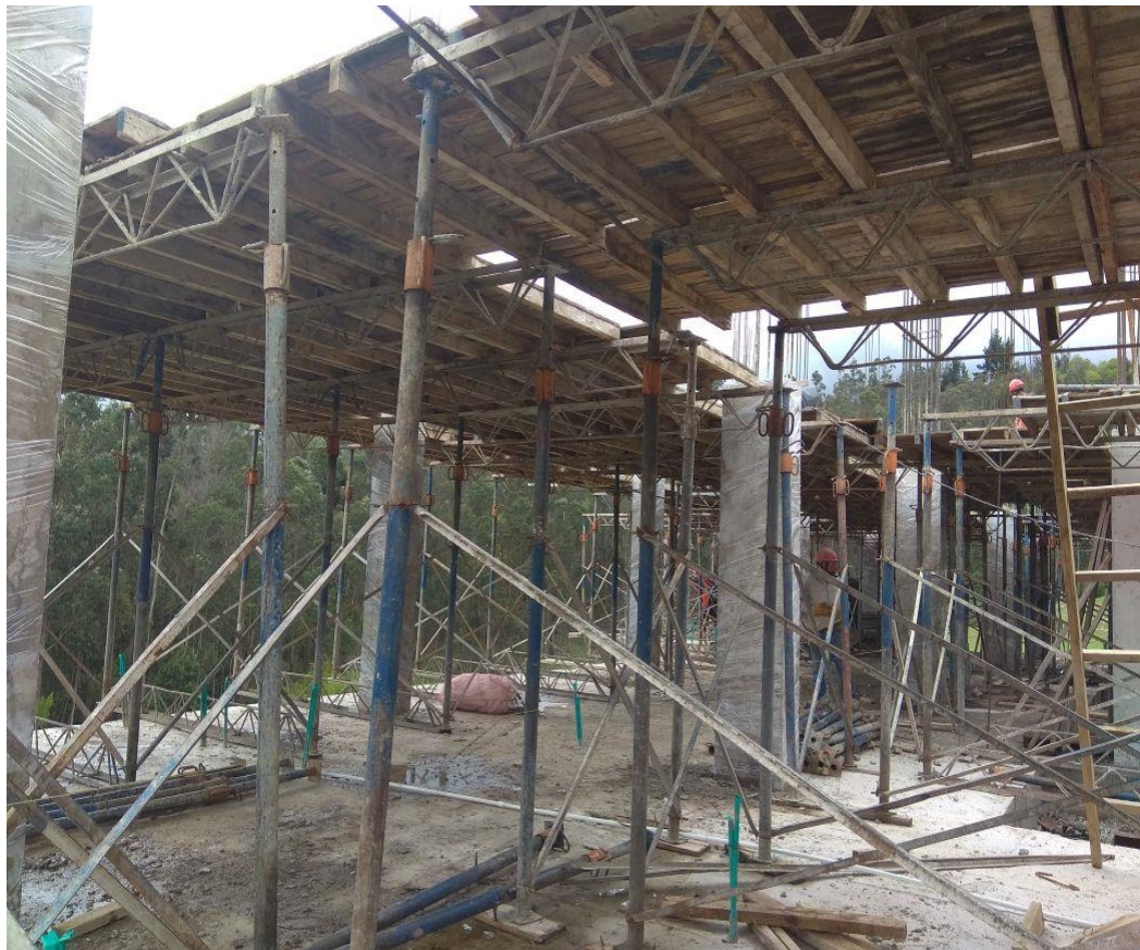
Ilustración 27 Instalación de Parales, Cerchas y Camillas nivel 5 – bloque 3
