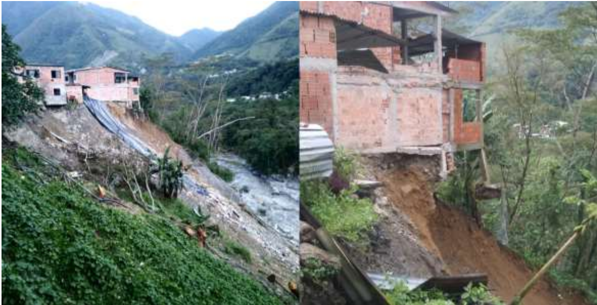
Figura 1. Inestabilidad del talud en el margen izquierdo del río Negro (año 2019) [6].
