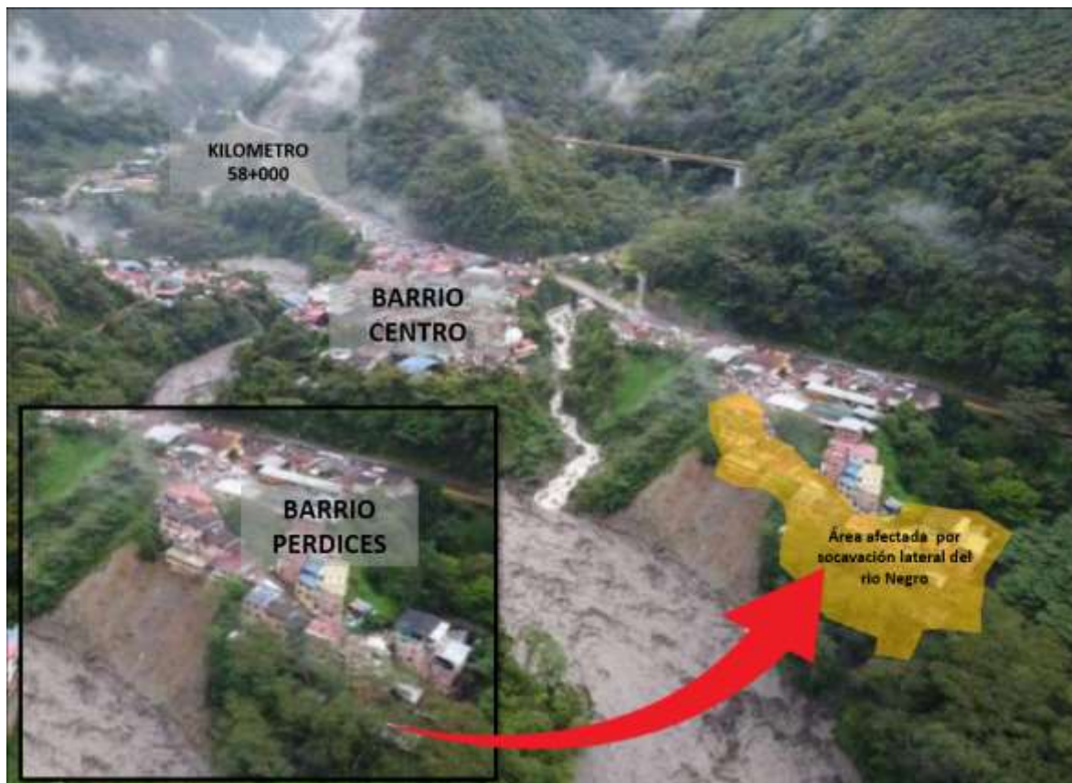
Figura 117. Área afectada por socavación lateral del río Negro, agosto 19 de 2021.
