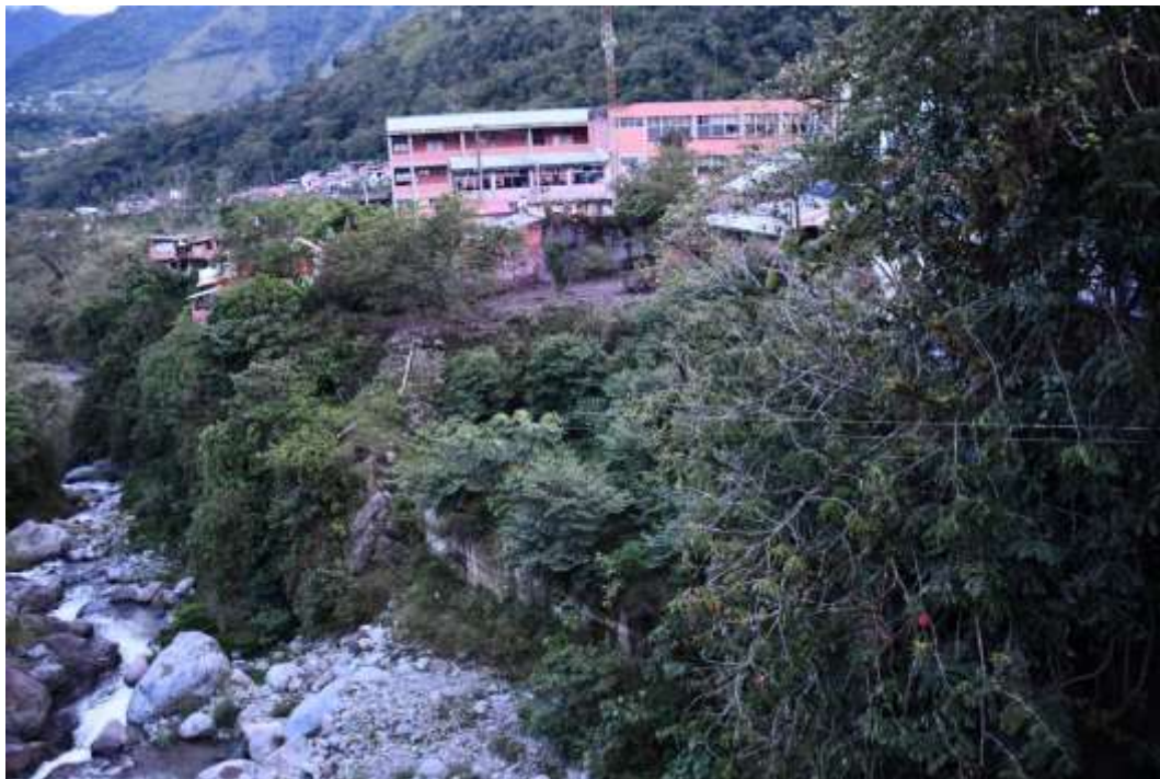
Figura 48. Muro de contención en el año 2021. Fuente: Propia
