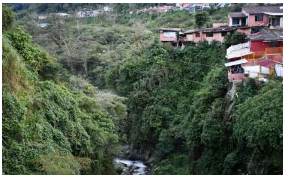
Figura 53. Viviendas sobre el margen derecho de la quebrada Perdices. Fuente: Propia.
