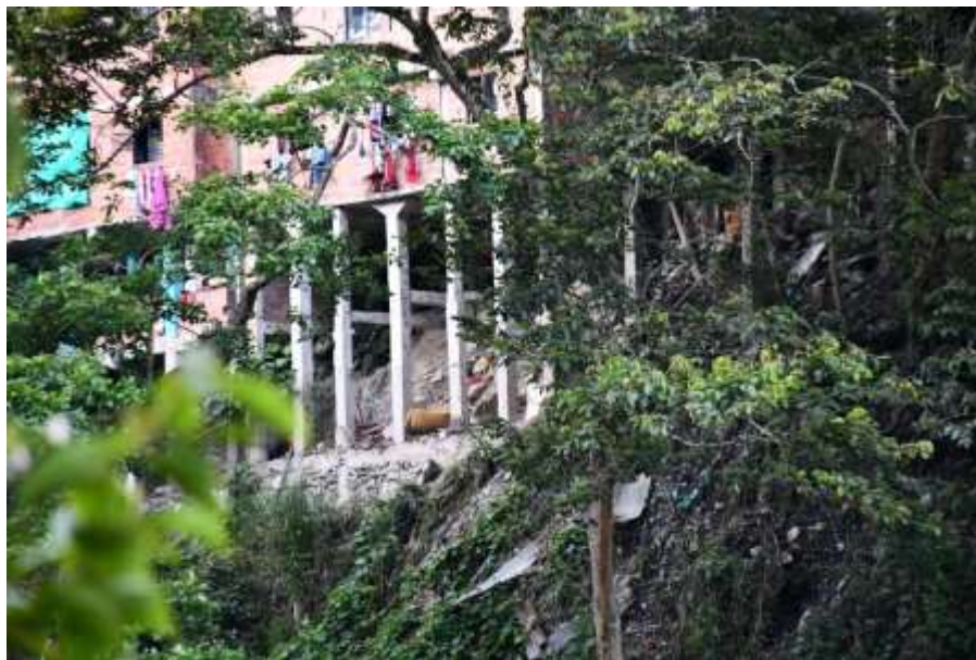
Figura 85. Estructuras y manejo de aguas de las viviendas de la parte baja de Barrio Nuevo. Fuente: Propia
