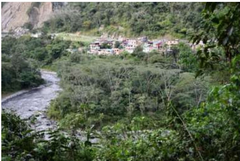
Figura 70. Talud de la parte medea de Barrio Nuevo. Fuente: Propia
