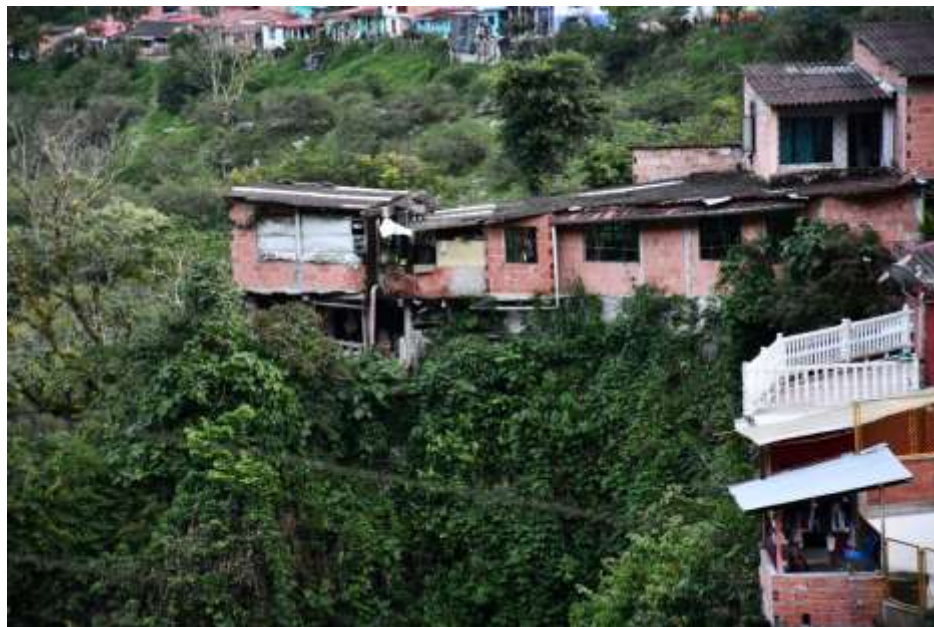
Figura 52. Viviendas sobre el margen derecho de la quebrada Perdices. Fuente: Propia.
