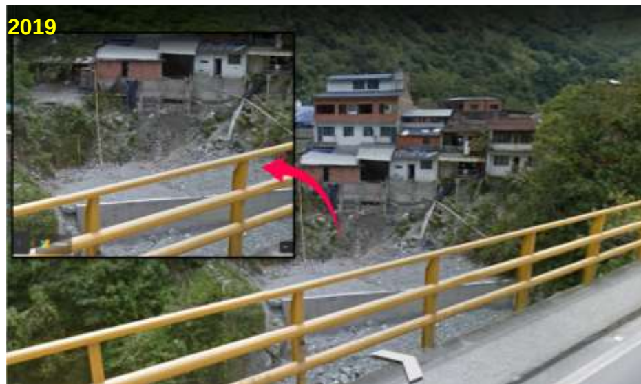
Figura 44. Construcción de la obra de estabilización del talud del barrio Centro en el año 2019 [6].
