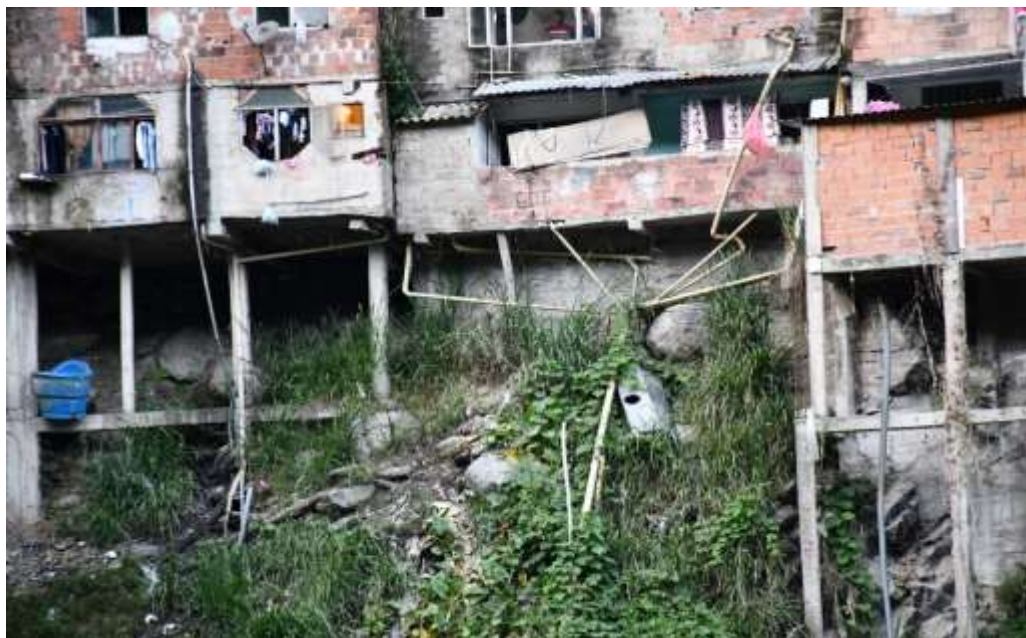
Figura 80. Manejo de aguas lluvias y pluviales de lass viviendas de la parte baja de Barrio Nuevo. Fuente: Propia
