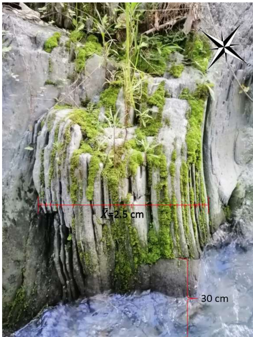
Figura 14. Fracturas verticales y horizontales en la quebrada Perdices. Fuente: Propia.
