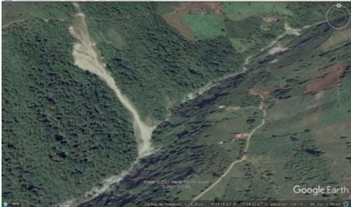
Figura 41. Panorámica tomada del servidor Google Earth© que muestra un deslizamiento en la margen derecha de la cuenca alta de la quebrada Perdices, aguas arriba del casco urbano. Se observa que en este valle en forma de "V" favorece deslizamientos que generan avalanchas o flujos de escombros en esta cuenca.
