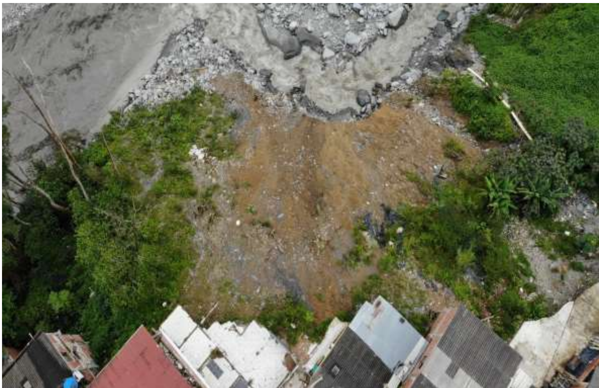
Figura 106. Vista en planta de la inestabilidad del Talud del barrio perdices [6].
