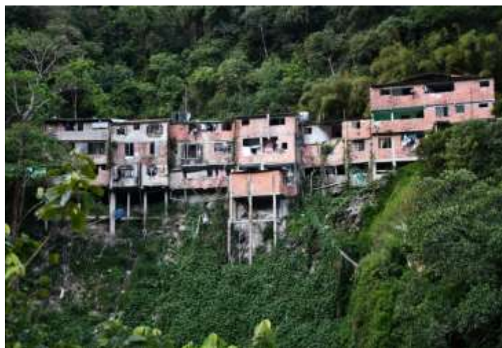
Figura 78. Manejo de aguas lluvias y pluviales de las viviendas de la parte baja de Barrio Nuevo. Fuente: Propia.
