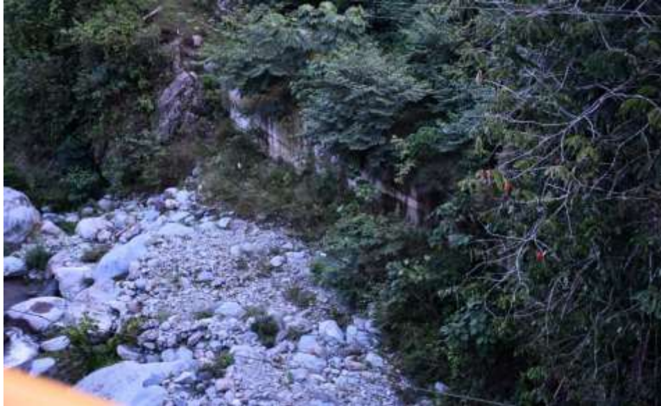
Figura 47. Muro de contención en el año 2021. Fuente: Propia
