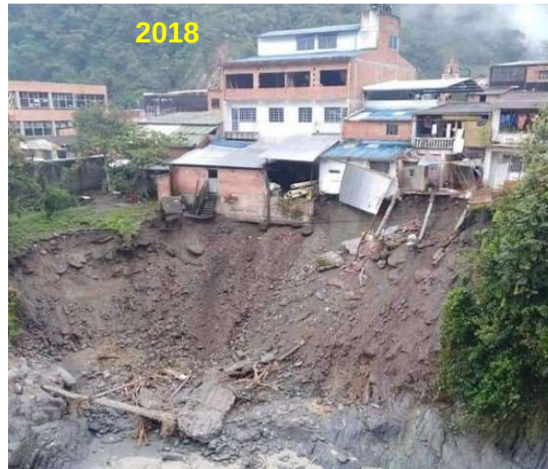
Figura 43. Inestabilidad del talud del barrio Centro en el año 2018 [6].
