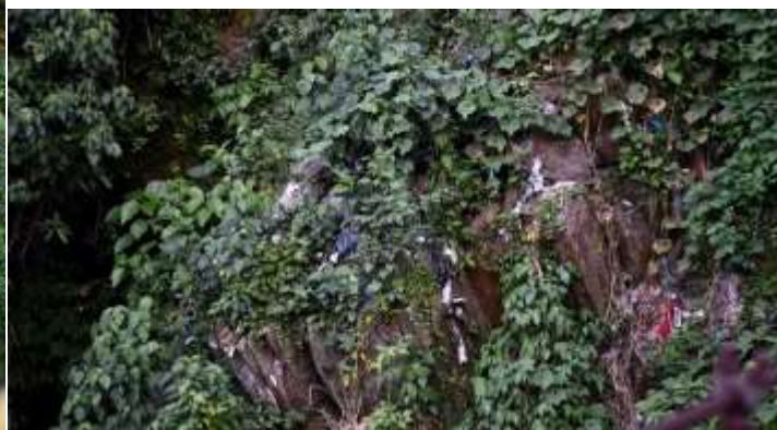
Figura 88. Macizo de rocas Filitas fracturado. Fuente: Propia
