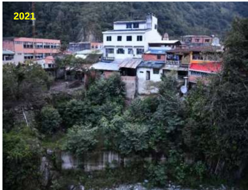
Figura 45. Obra de estabilización del talud del barrio Centro en el año 2021. Fuente: Propia
