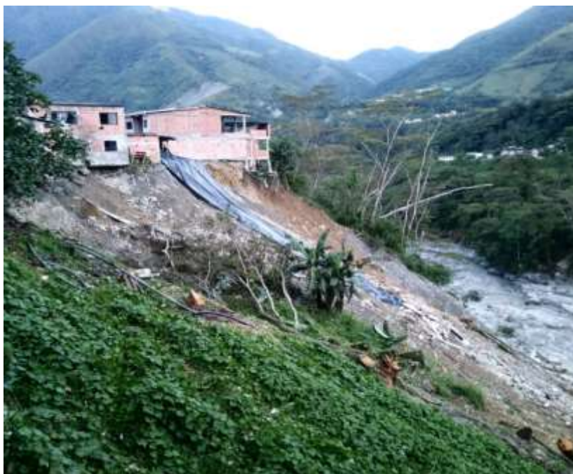
Figura 107 Inestabilidad del talud del barrio Perdices [6]
