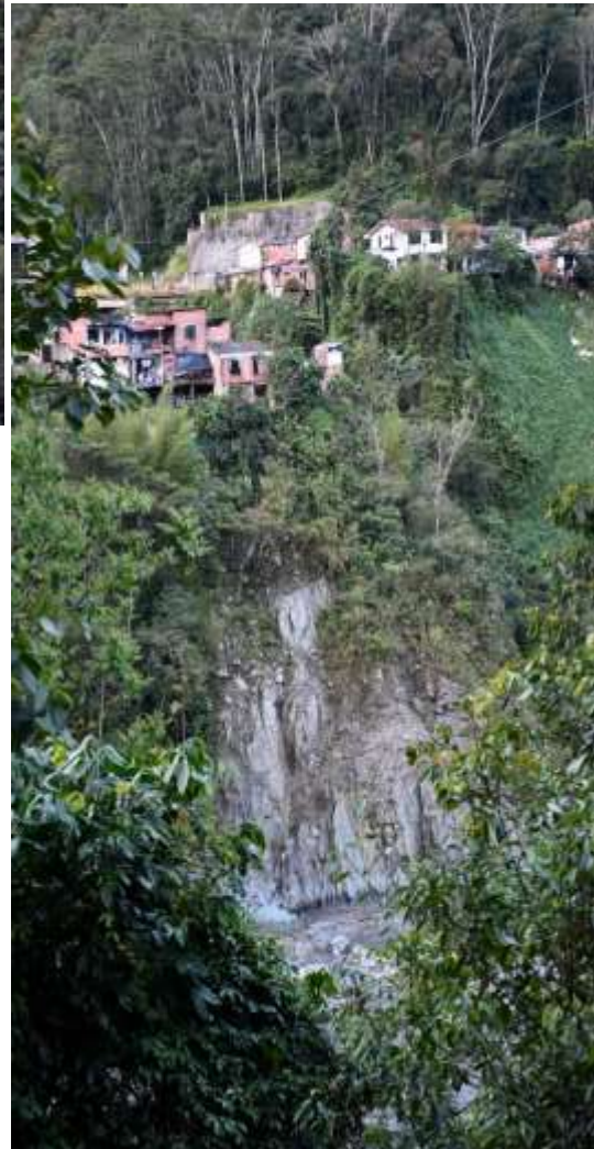
Figura 95. Macizo rocoso fracturado del barrio Centro. Fuente: Propia
