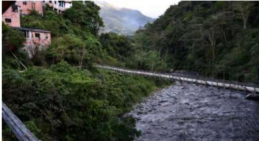
Figura 89. Talud del barrio Centro. Fuente: Propia.
