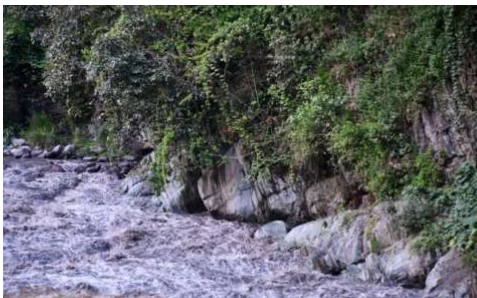
Figura 86. Macizo rocoso fracturado del talud de la parte baja de Barrio Nuevo. Fuente: Propia
