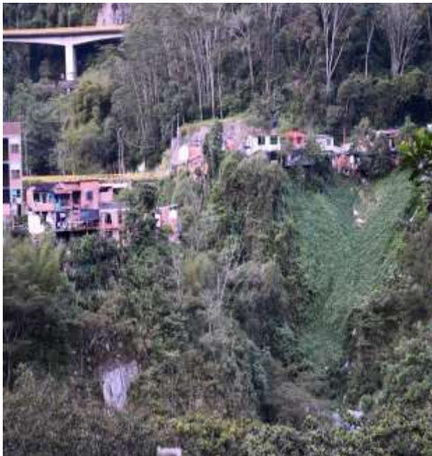
Figura 97. Talud del barrio Centro. Fuente: Propia
