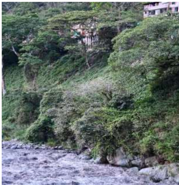
Figura 73. Macizo rocoso del talud de la parte baja de Barrio nuevo. Fuente: Propia
