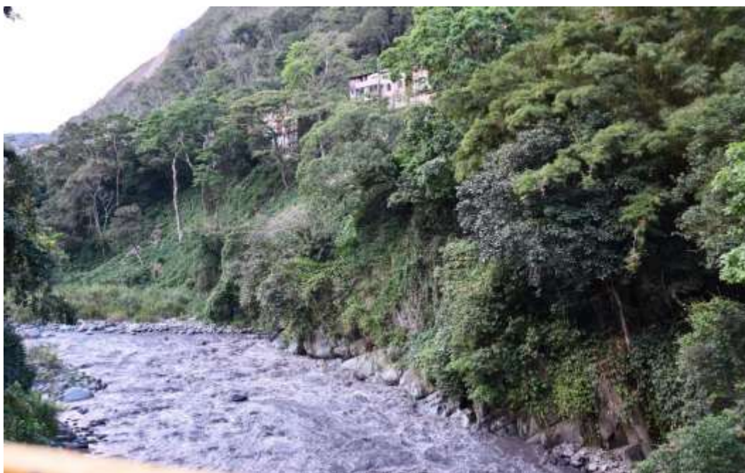
Figura 84. Talud de la parte baja de Barrio Nuevo. Fuente: Propia
