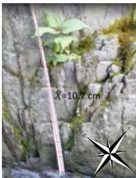
Figura 16. Fractura horizontal del macizo rocoso de la quebrada Perdices. Fuente: Propia.
