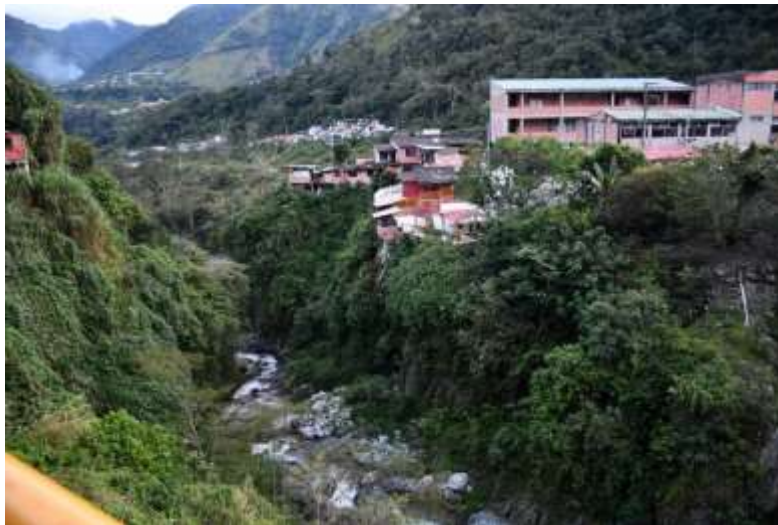
Figura 50. Margen derecho de la quebrada Perdices. Fuente Propia.
