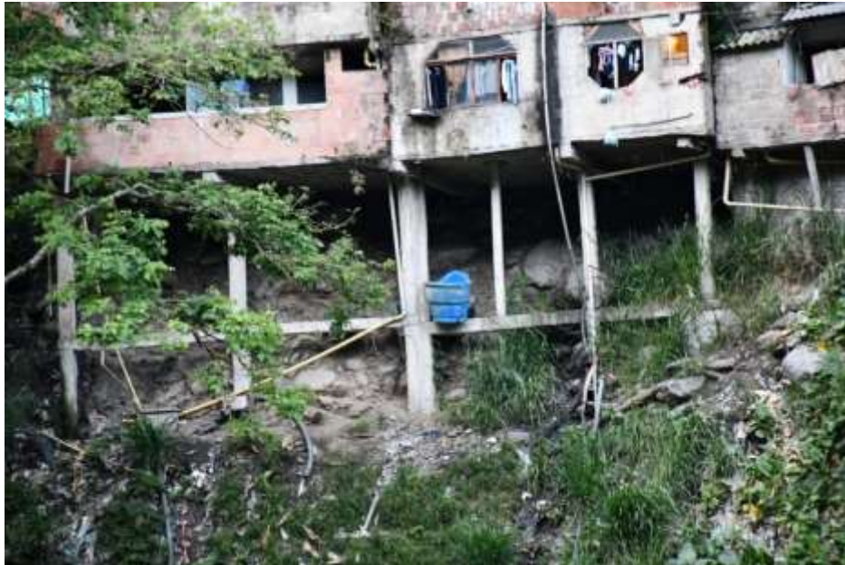
Figura 79. Manejo de aguas lluvias y pluviales de lass viviendas de la parte baja de Barrio Nuevo. Fuente: Propia
