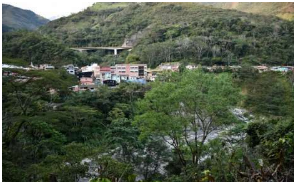
Figura 94 Talud del barrio Centro. Fuente: Propia
