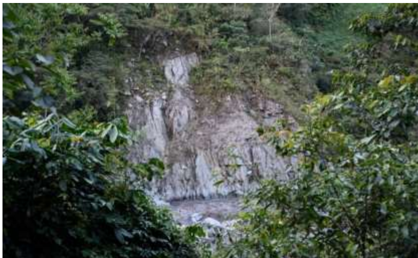
Figura 101. Macizo rocoso del barrio Perdices. Fuente: Propia.
