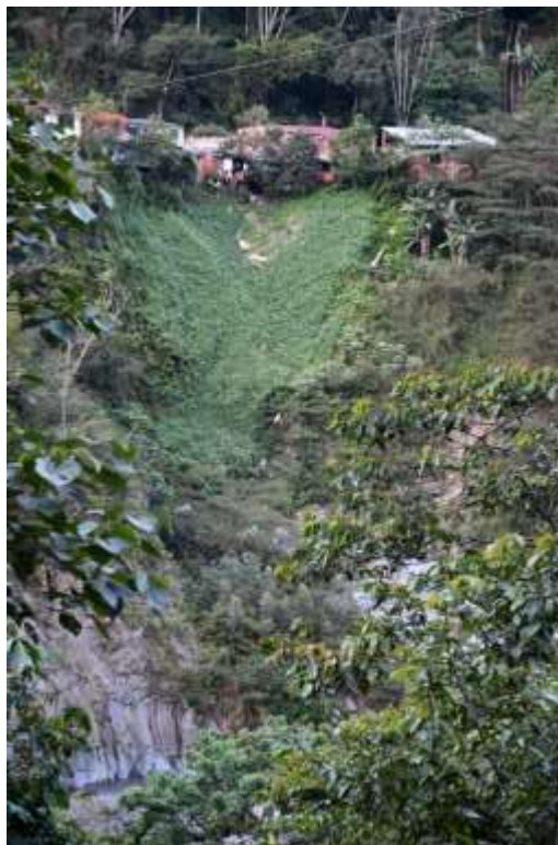
Figura 100. Talud del barrio Perdices. Fuente: Propia.
