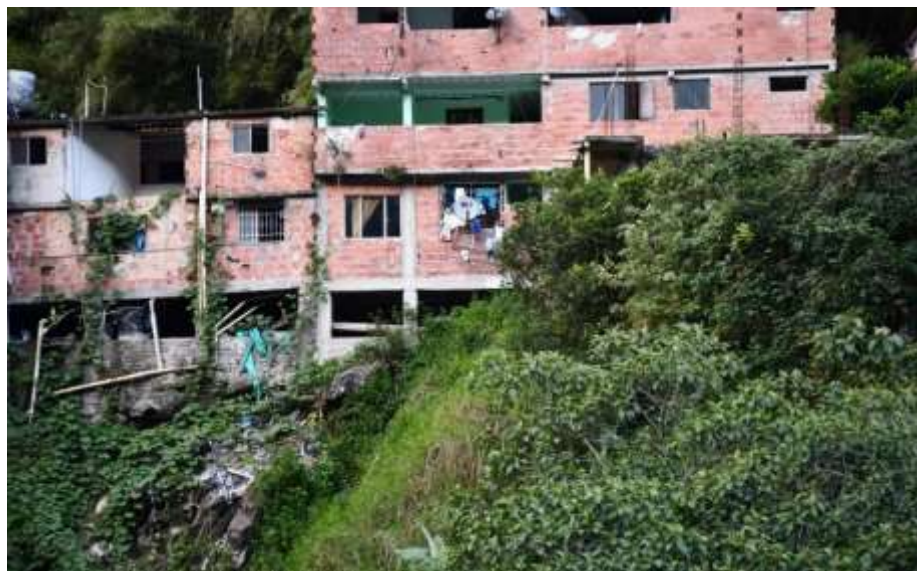
Figura 82. Manejo de aguas lluvias y pluviales de las viviendas de la parte baja de Barrio Nuevo.
