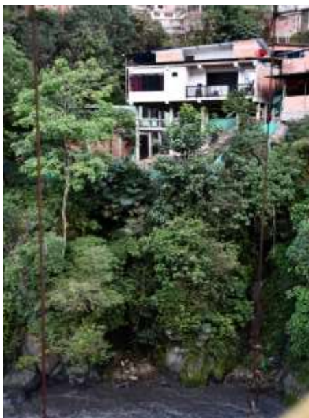
Figura 87. Talud del barrio centro. Fuente: Propia.
