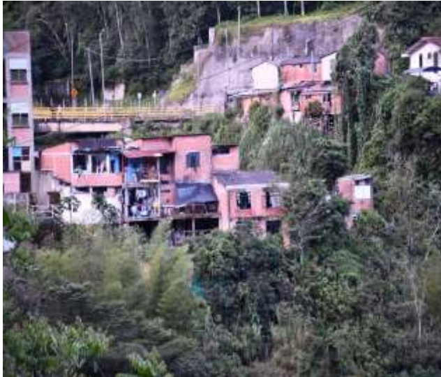
Figura 96. Puente de la quebrada Perdices por donde pasa la vía Bogotá – Villavicencio. Fuente: Propia
