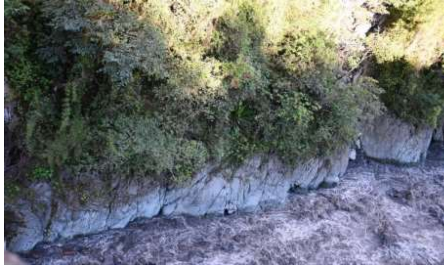
Figura 66. Macizo rocoso fracturado.
