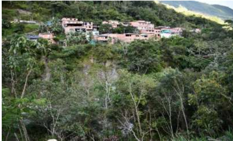
Figura 68. Talud de la parte alta de Barrio Nuevo. Fuente: Propia
