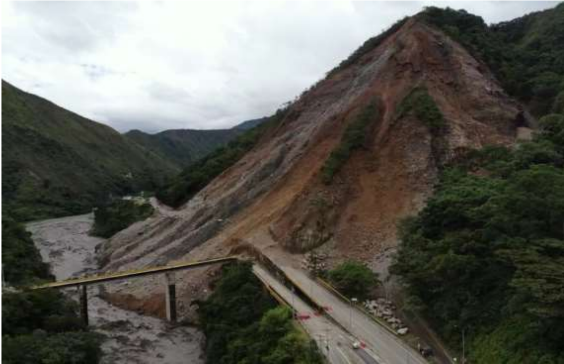
Figura 60. Talud del Kilometro 58 de la vía Bogota – Villavicencio en el año 2019. [6]
