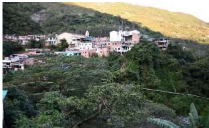
Figura 90. Margen izquierda del río Negro del barrio Centro. Fuente: Propia
