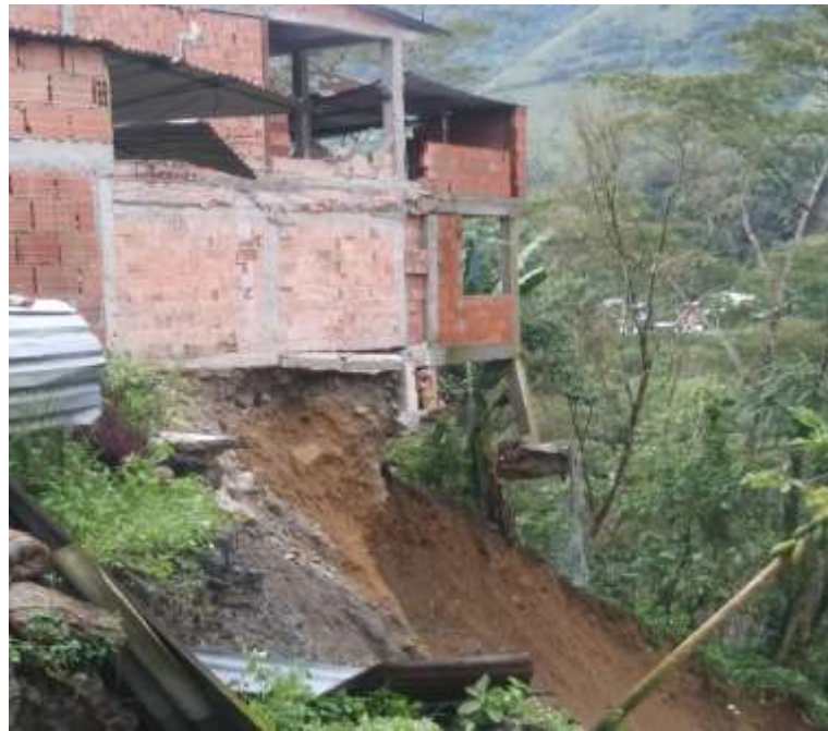
Figura 108. Viviendas en zona de alto riesgo. [6]
