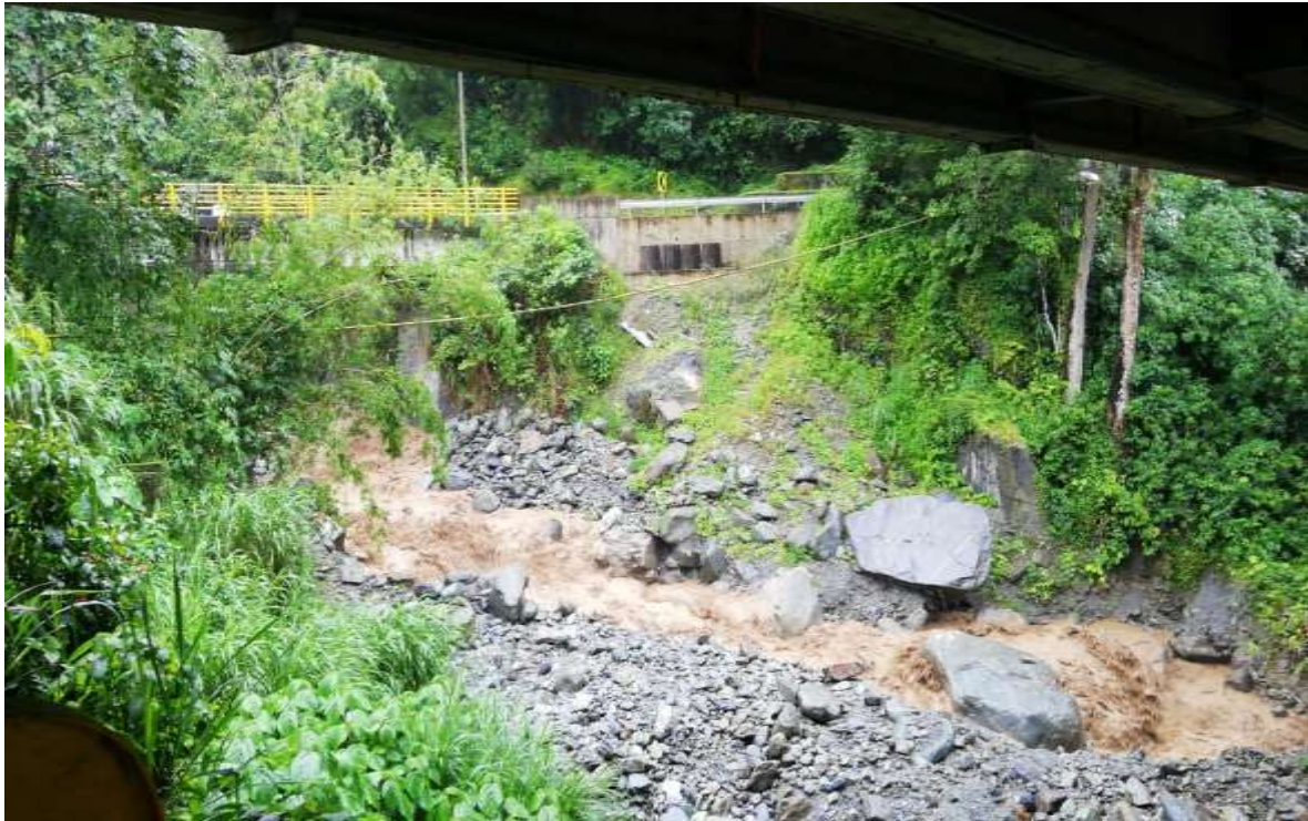
Figura 58. El puente del retorno a la plaza de mercado que se encuentra paralelo al puente de la vía Bogotá – Villavicencio, ubicado en la quebrada Perdices.
