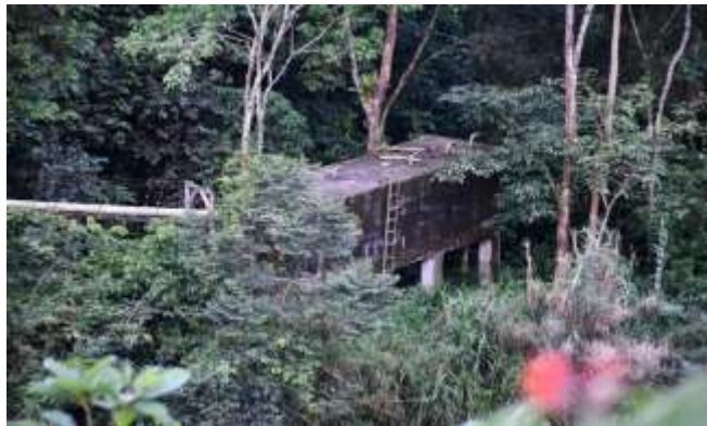
Figura 92. Tanque de almacenamiento de agua del casco urbano. Fuente: Propia
