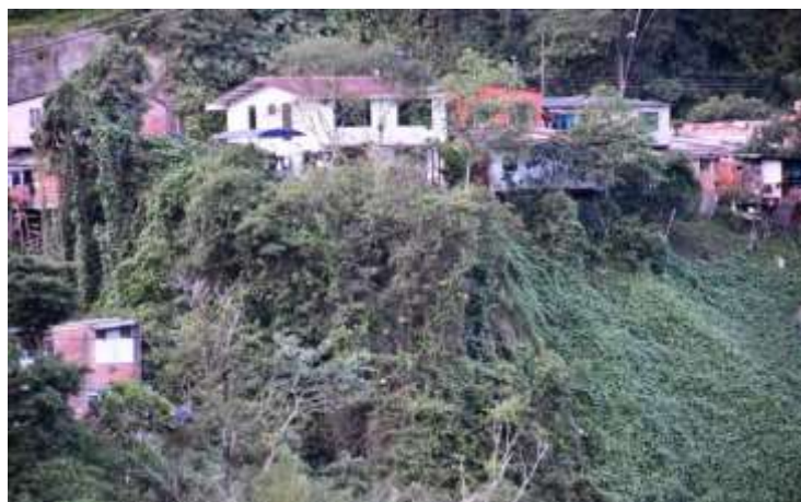
Figura 55. Viviendas del barrio Perdices sobre el margen izquierdo de la quebrada Perdices. Fuente: Propia
