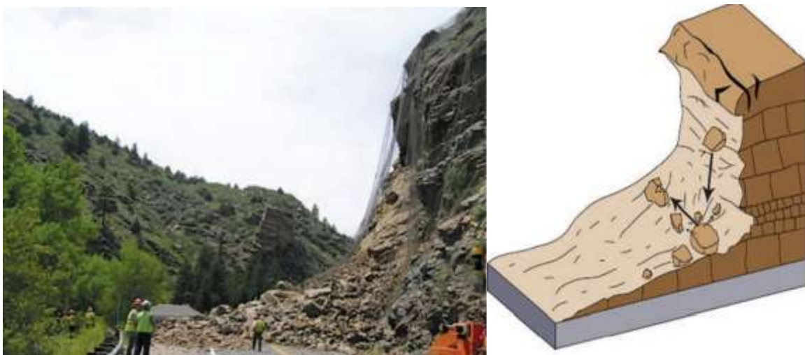
Figura 114. Desprendimiento de roca [26].
