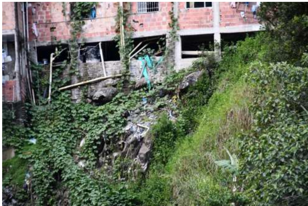
Figura 83. Manejo de aguas lluvias y pluviales de lass viviendas de la parte baja de Barrio Nuevo. Fuente: Propia
