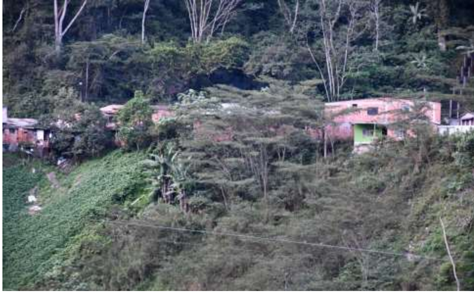
Figura 103. Talud del barrio perdices Fuente: Propia.
