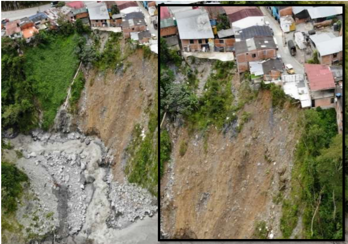
Figura 105. Inestabilidad del talud del barrio Perdices en el año 2018 [6].
