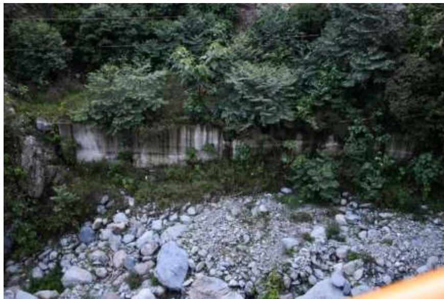
Figura 46. Muro de contención en el año 2021. Fuente: Propia
