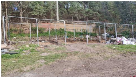
Figura 14 Construcción del Centro de acopio de residuos convencionales
