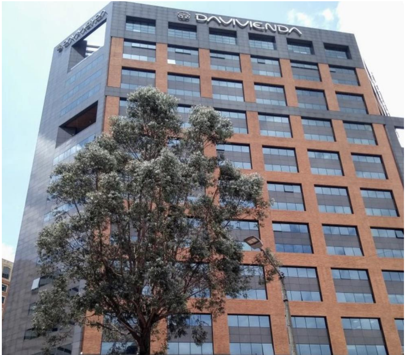
Figura 2: Imagen gráfica del edificio donde se encuentra las oficinas de Belisario S.A.S.
