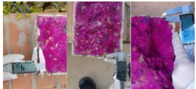
Fig. 26. Mediciones de carbonatación mínimas. Fuente: Autores.
