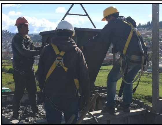
Vaciado del concreto en el elemento deseado.
