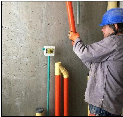
Instalación de red hidrosanitaria.
