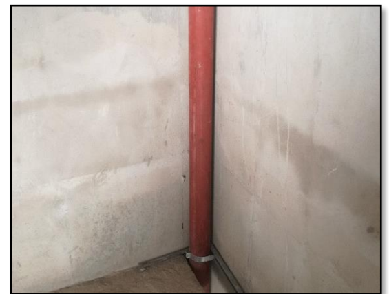
Intalación red contra incendios.
