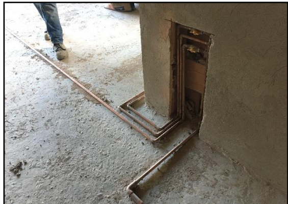
Instalación de red de gas.
