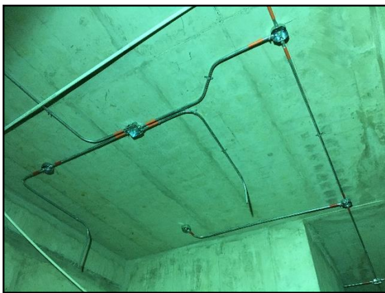
Intalación red eléctrica.
