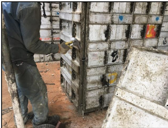
Cimbrado de muros con formaletas metálicas, teniendo especial cuidado en el plomado de los muros, aseguramiento de las formaletas, anclajes y revisión de niveles.
