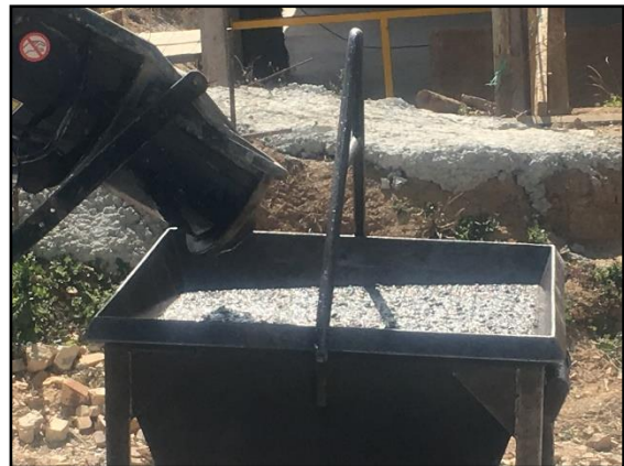
Vaciado del concreto en un elemento de metal llamado en obra care vaca, el cual funcionaba como un embudo, éste luego de ser llenado con concreto se elevaba por medio de la grúa hasta el piso deseado.
