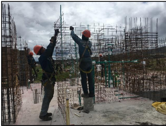
Instalación de pases eléctricos y caja de derivación.
