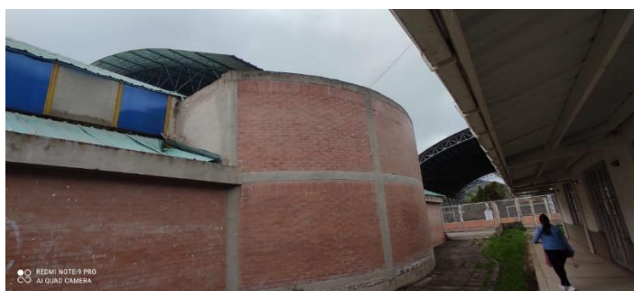
Ilustración 33: Fachada posterior antes de la intervención 1
