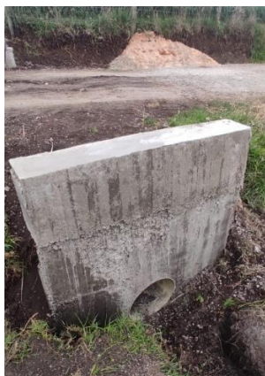
Ilustración 60: Construcción de Alcantarillas
