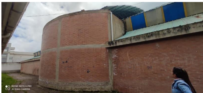
Ilustración 34: Fachada posterior antes de la intervención 2
