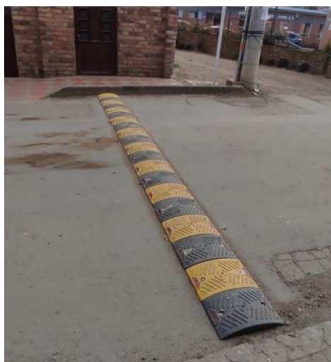
Ilustración 45: Instalación reductor de velocidad
