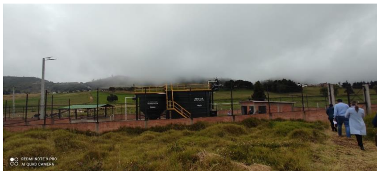
Ilustración 57: Tren de tratamiento de aguas residuales
