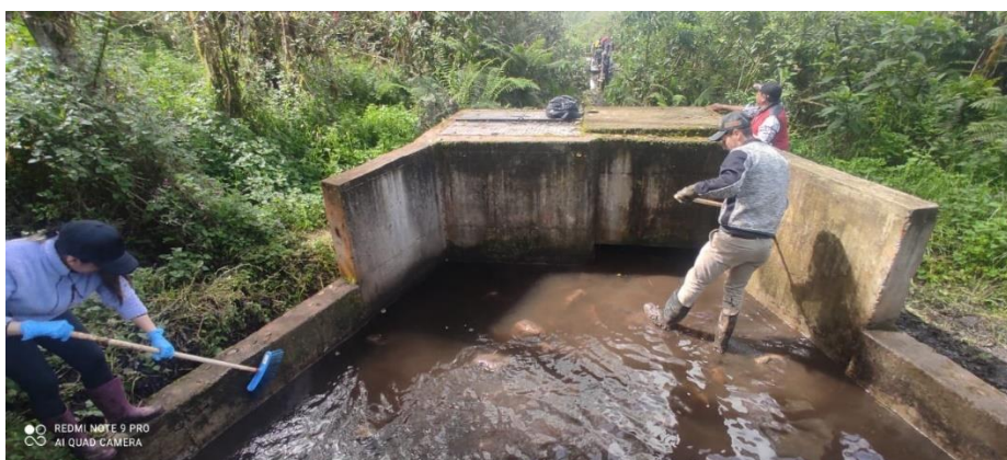
Ilustración 50: Limpieza Bocatoma
