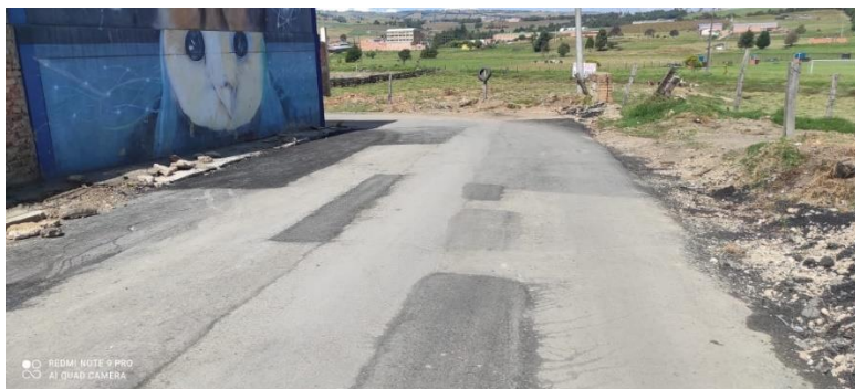
Ilustración 48: Reparcheo realizado en uno de los puntos críticos
