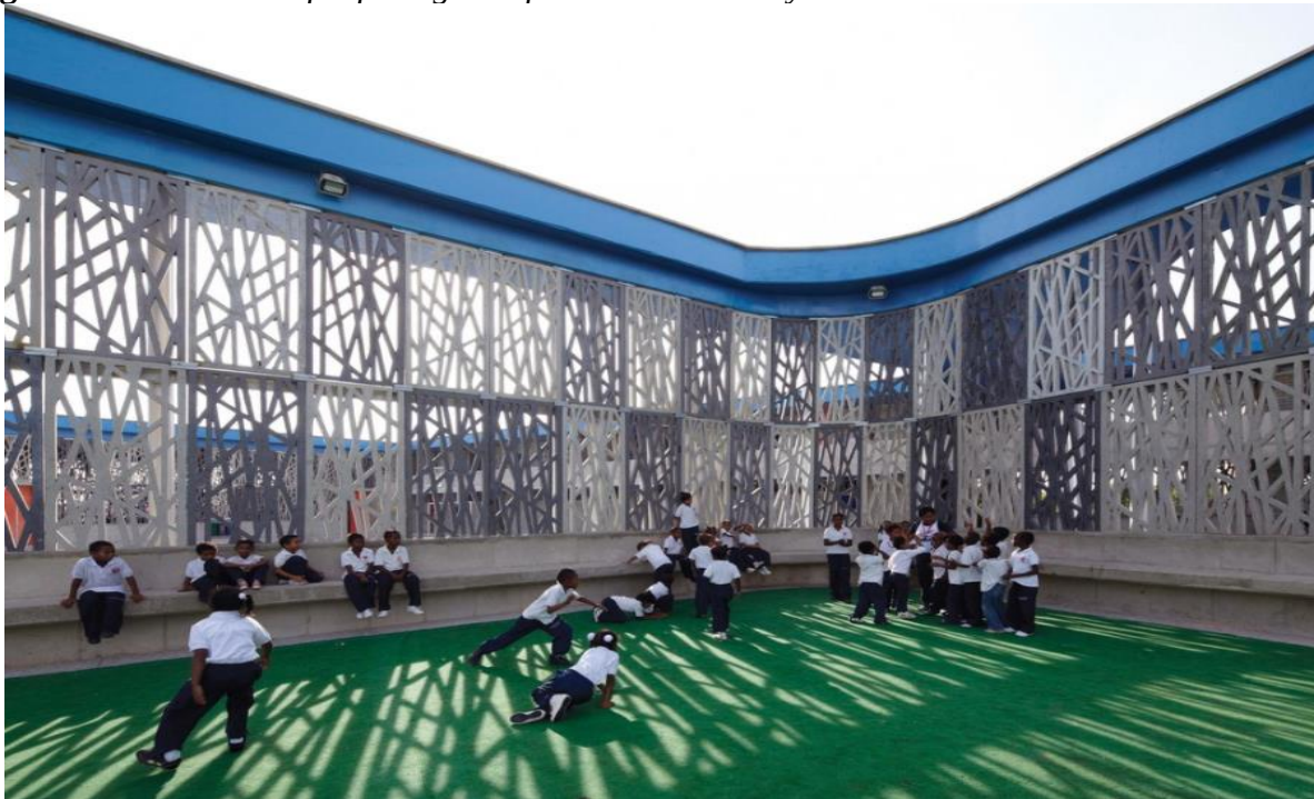
Figura 13. Membrana que protege las fachadas de los rayos UV directos del sol.
