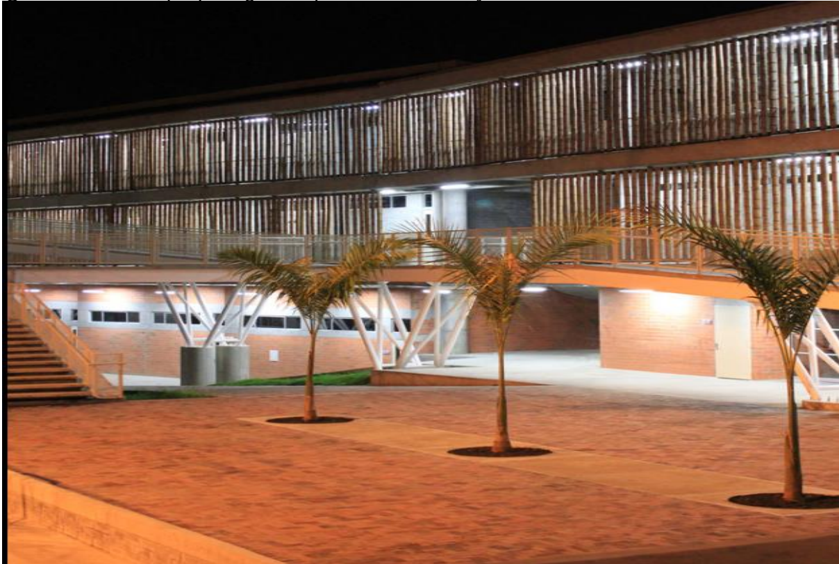
Figura 7. Celosías que protegen las fachadas de los rayos UV del sol.
