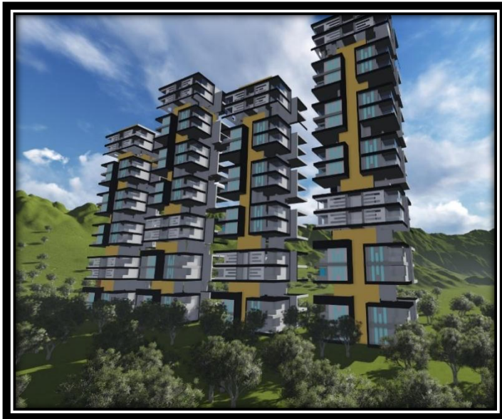
Fachada principal derecha
