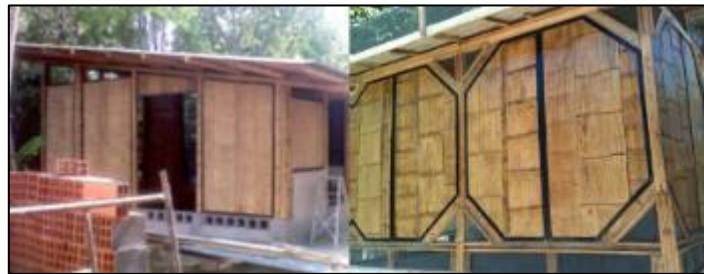
Fig. 36: Sistema industrializado en guadua.
