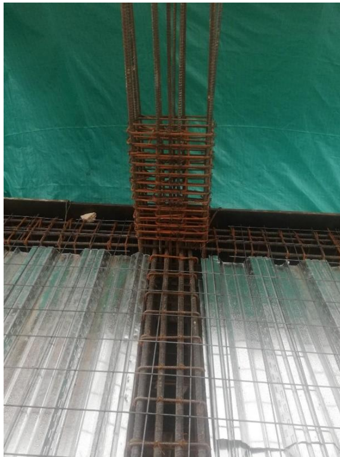
IMAGEN 6. VERIFICACIÓN DE PLANOS EN ARMADO DE VIGAS Y COLUMNAS.
