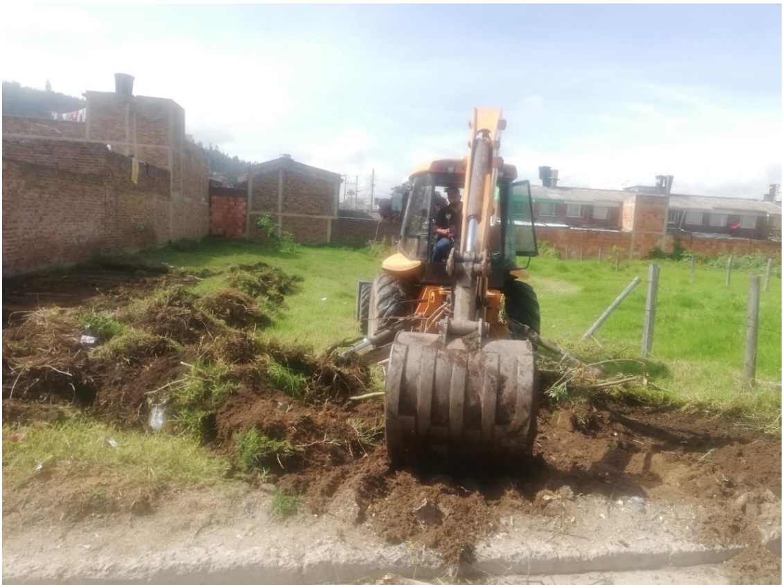
IMAGEN 17.DESCAPOTE DE TERRENO
