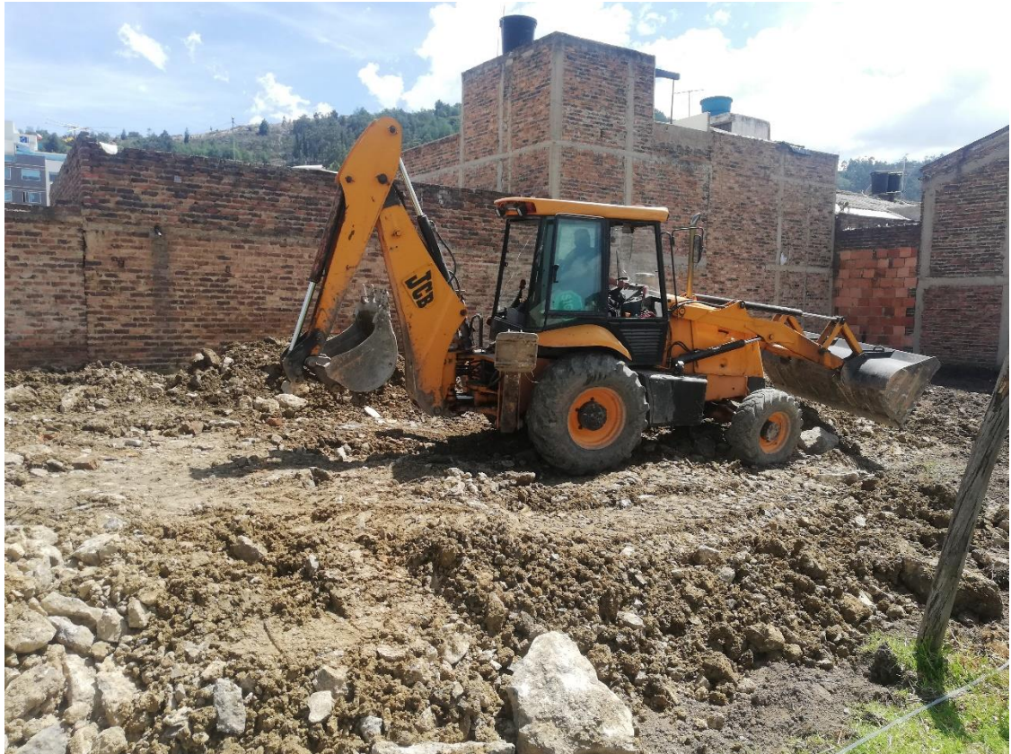
IMAGEN 19 . DISTRIBUCION DEL MATERIAL EN EL TERRENO
