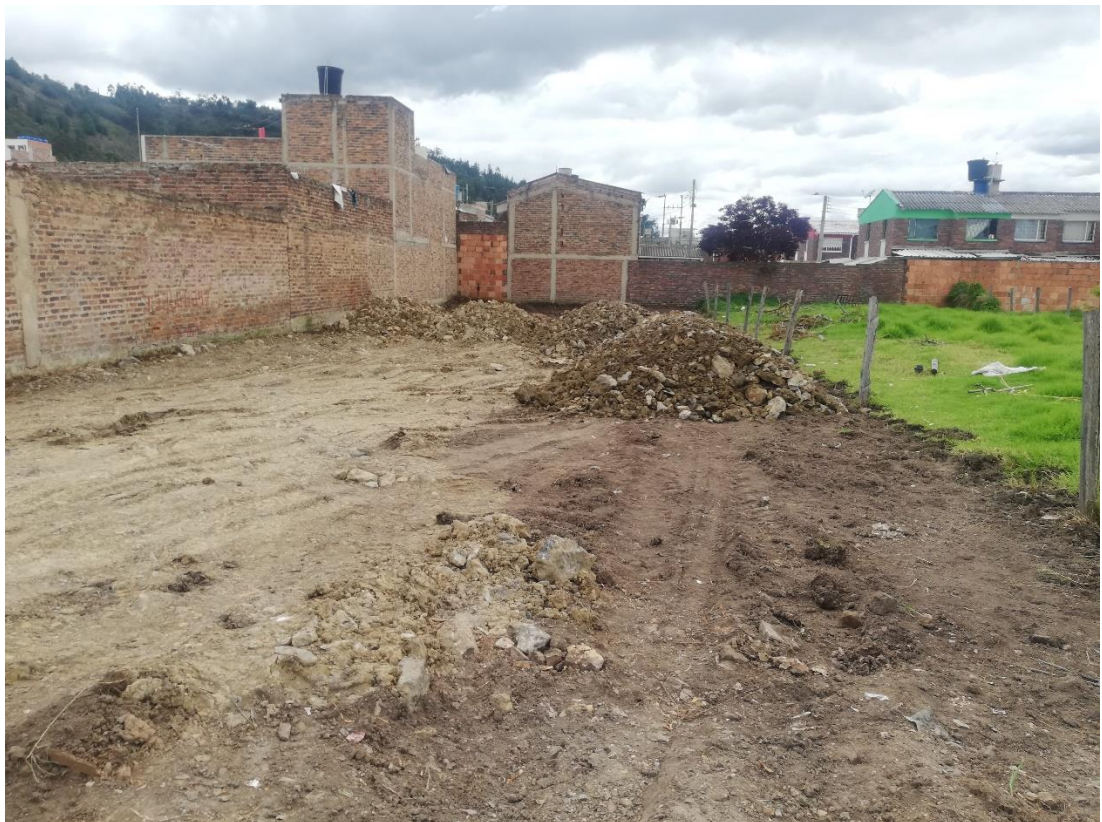
IMAGEN 18.MEJORAMIENTO Y NIVELACIÓN DE TERRENO
