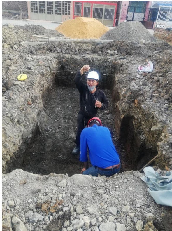
IMAGEN 22. MEDIDAS Y NIVELES DE ZAPATAS.
