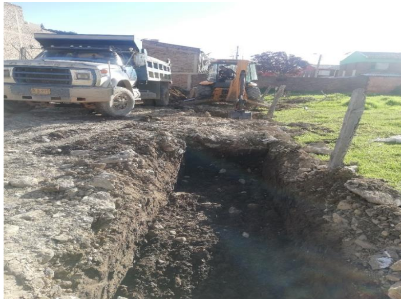
IMAGEN 21. EXCAVACION DE ZAPATAS
