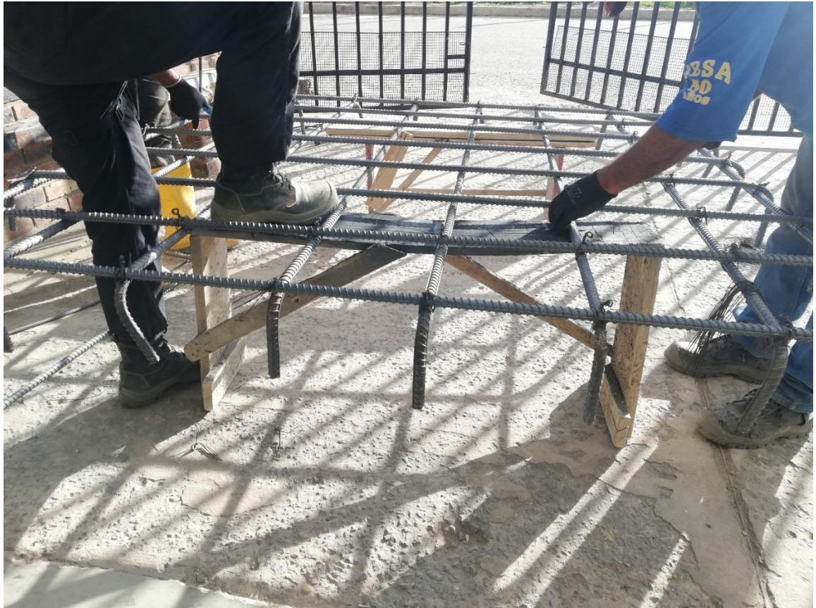
IMAGEN 24. ARMADO DE PARRILLAS.
