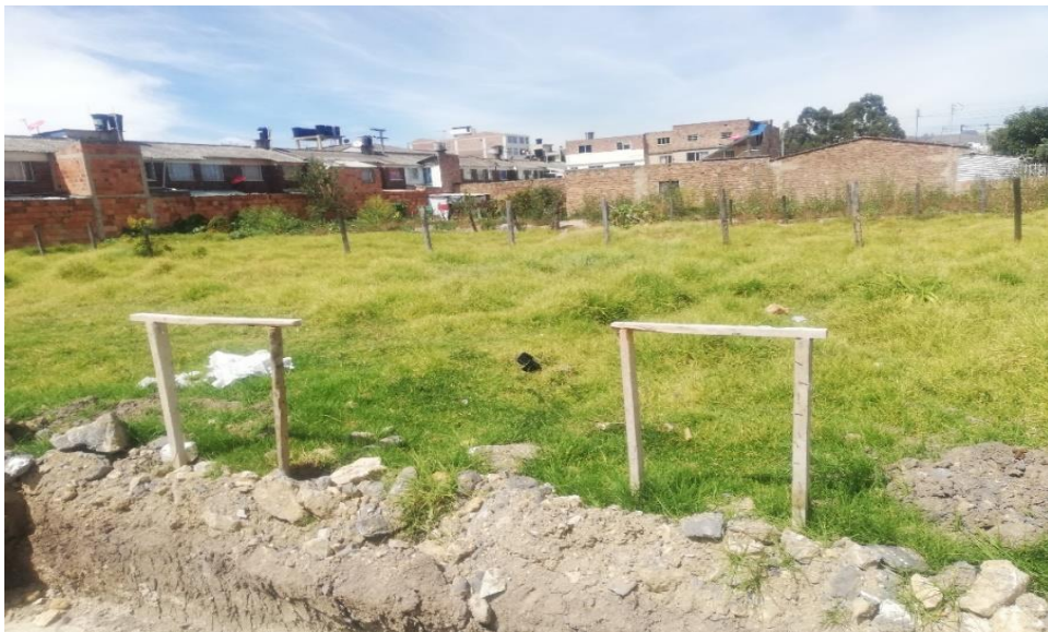
IMAGEN 20. TRAZADO DE EJES Y REPLANTEO
