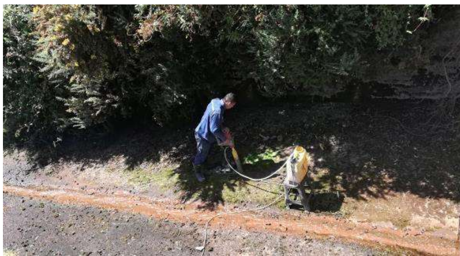
Fotos # 10 a 16 Extracción de núcleos vertedero de excesos y canal de descarga.
