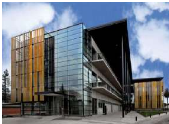
Figura 63. Planta Graneros – Nestlé – G. Hevia arquitecto – Panel screen Hunter Douglas Fuente: http://www.hunterdouglas.cl
