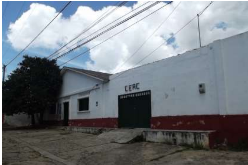
Figura 85. Estado edificación actual en el lote seleccionado. Fuente: tomada por la autora
