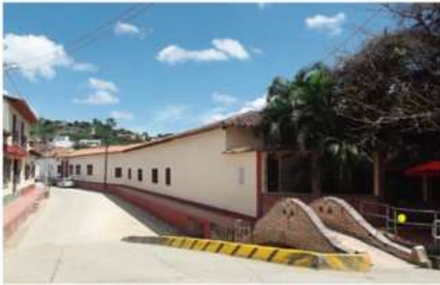
Vía regional circunvalar
