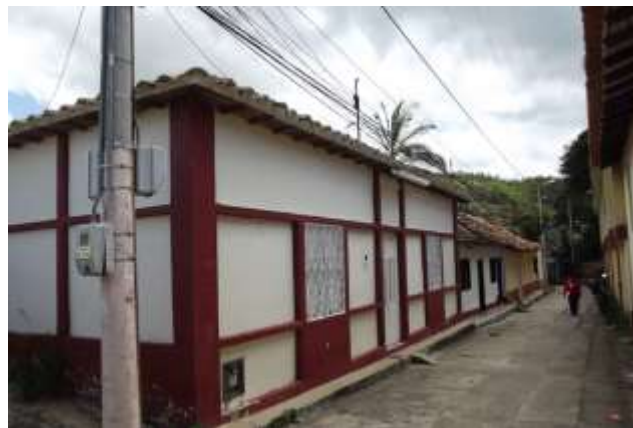
Figura 22. Predio lateral derecho, vivienda. Fuente: Tomada por la autora
