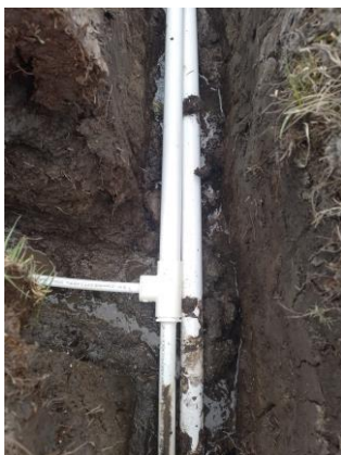
Ilustración 13. Visita técnica vereda Toquilla, sector corral de piedra.
