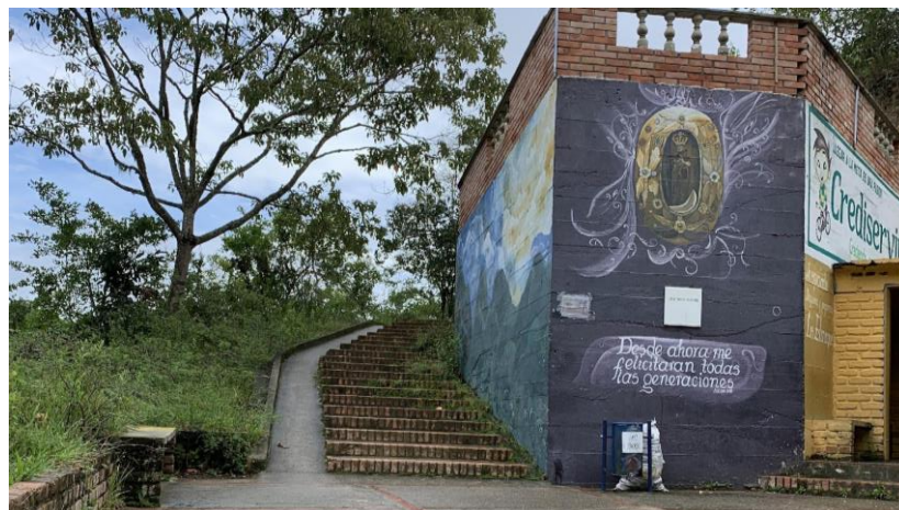
Figura 35. Escaleras existentes para acceso al Santuario
