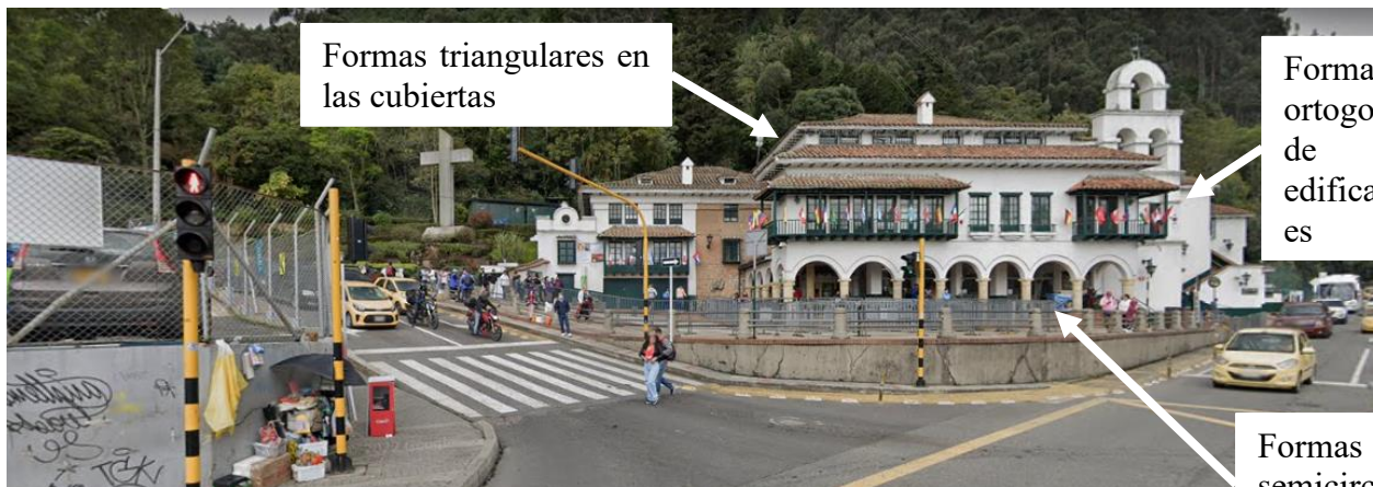
Figura 49. Venta de tiquetes y plazoleta de acceso del Cerro De Monserrate, Bogotá.
