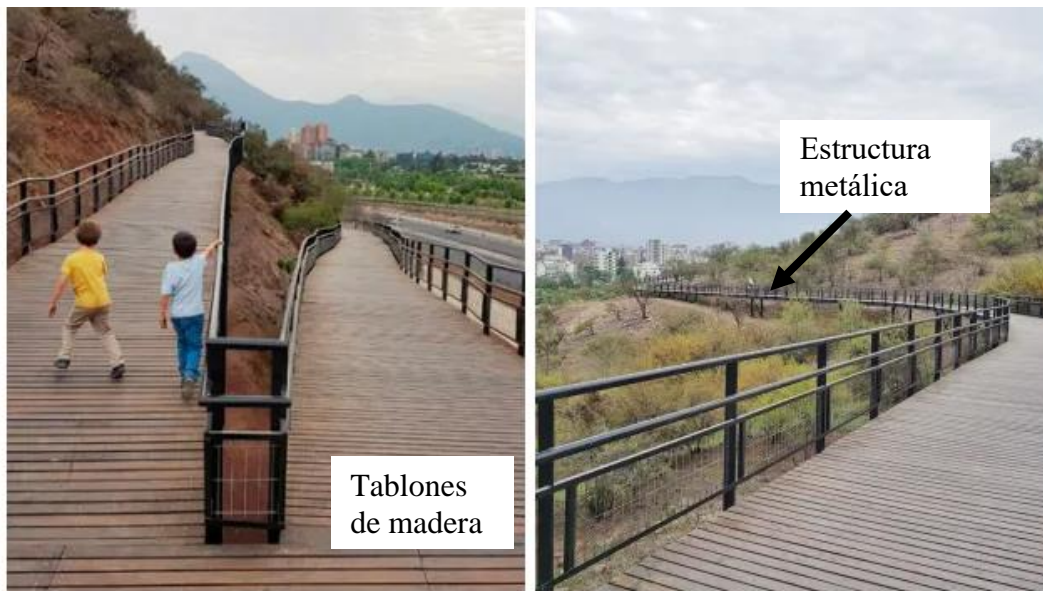
Figura 55. Pasarelas Parque Metropolitano o Cerro San Cristóbal
