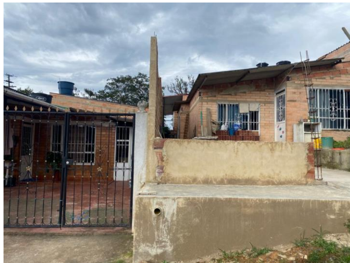
Figura 26 Vista inspección ocular construcción muro medianero vivienda Fuente: Autor,2023
