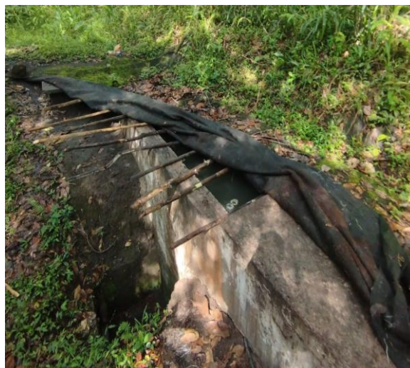
Figura 22 Visita inspección desarenador Tablón Fuente: Autor,2023
