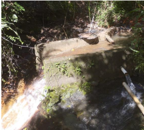
Figura 21 Visita inspección bocatoma Tablón Fuente: Autor,2023
