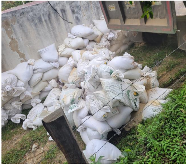
Figura 10 Supervisión suministro de arena para lechos filtrantes Fuente: Autor,2023
