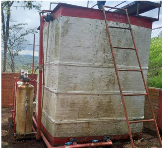
Figura 23 Visita inspección PTAP Tablón Fuente: Autor,2023
