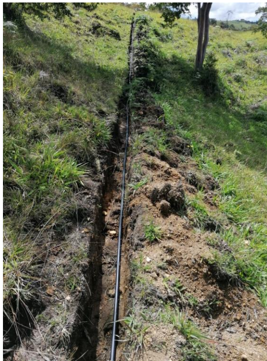
Figura 8 Instalación de Tubería Vereda Garibay Fuente: Autor,2023
