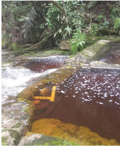
Figura 15 Visita inspección bocatoma acueducto vereda centro y parte de carare Fuente: Autor,2023
