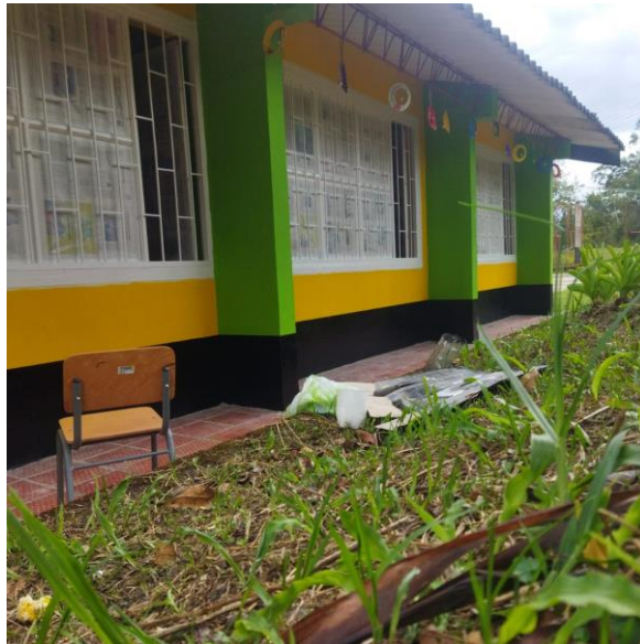
Figura 12 Visita Supervisión pintura de fachada I.E Haydee Camacho Saavedra Fuente: Autor,2023
