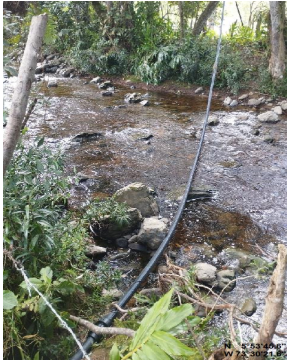
Figura 7 Ubicación sitio para construcción paso elevado Fuente: Autor,2023
