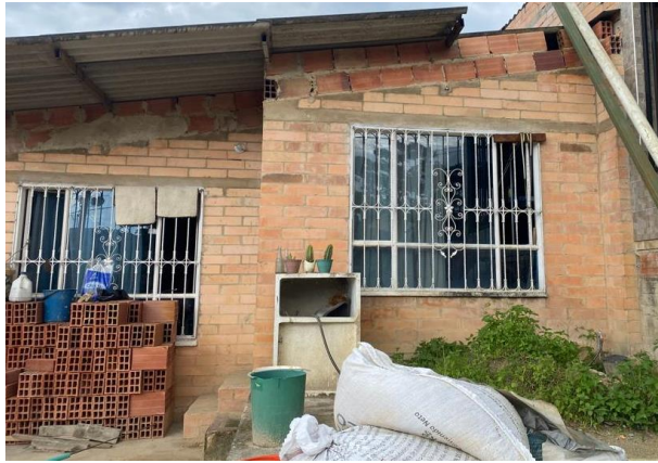
Figura 24 Vista inspección ocular modificación a cubierta vivienda Fuente: Autor,2023
