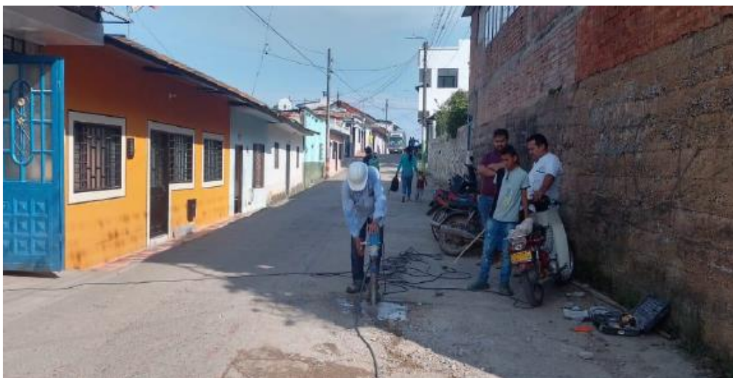
Gráfica 37: Punto Extracción de Núcleo 5. Calle 5 No. 5 - 04
