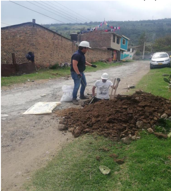
Ilustración 5. Realización de los apiques.
