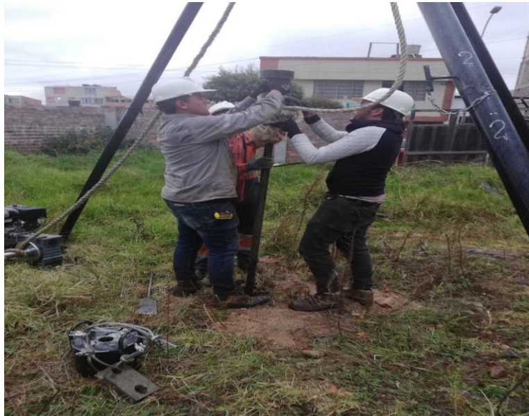
Ilustración 10. Exploración en campo, desmonte del equipo de perforación.
