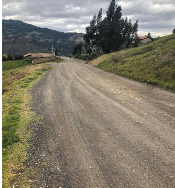
Ilustración 4. Tramo de la vía a ejecutar el estudio.
