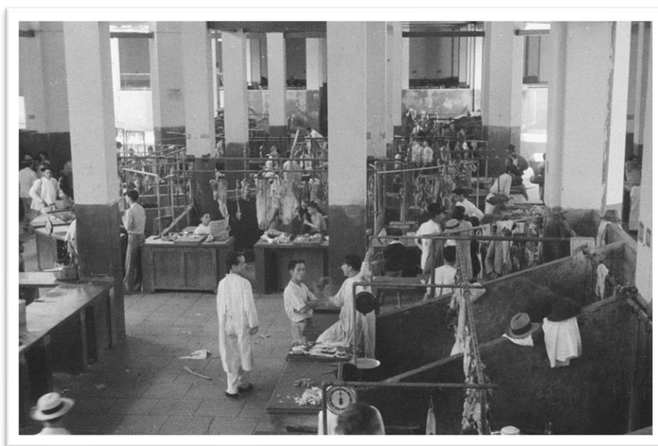
Figura 10. Pasarela central, Pabellón de Carnes, Plaza de Mercado San Mateo, 1934 / 1937.
