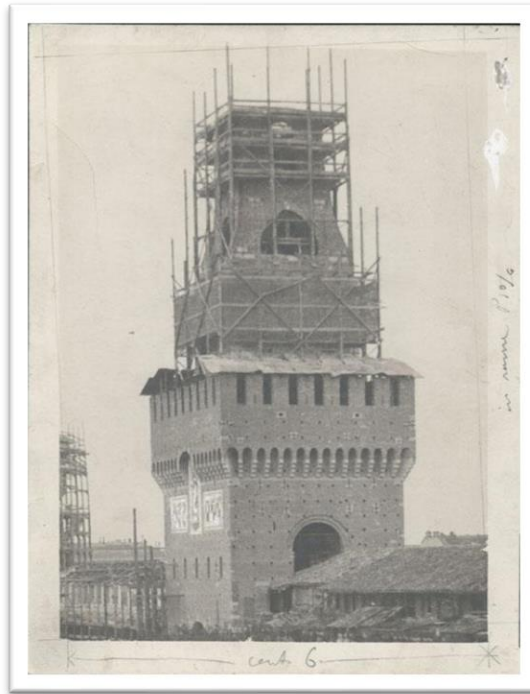
Figura 107. Torre Filarete del castillo Sforza en obras, 1904.
