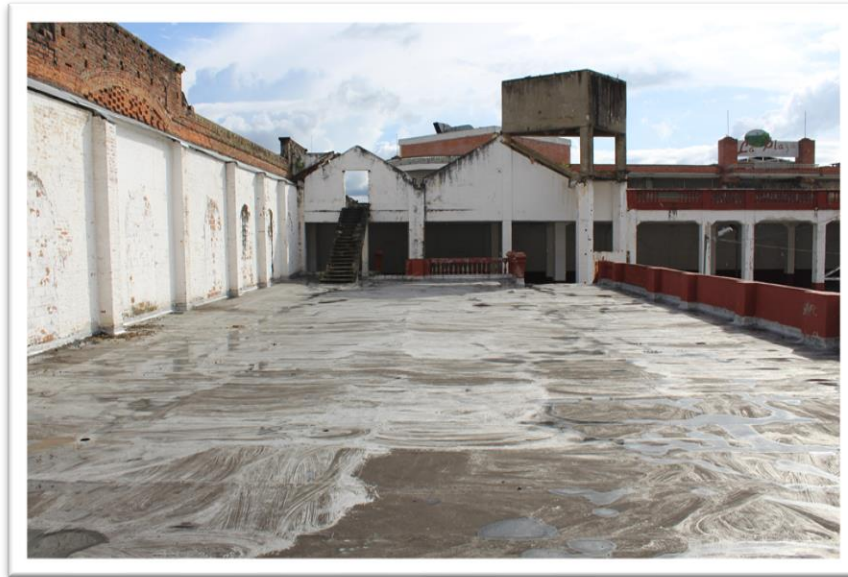
Figura 17. Segundo piso, pasarela sur oriental de la Plaza y tanque cisterna.
