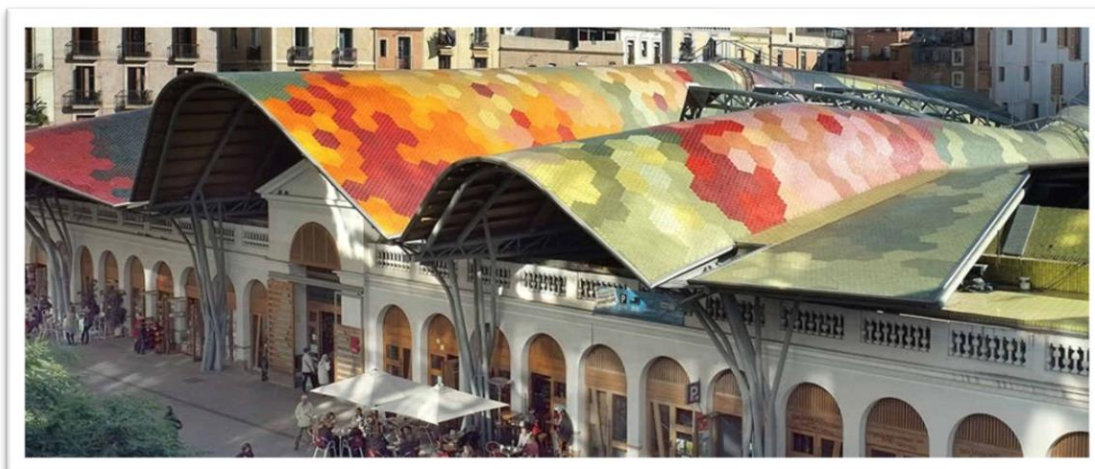
Figura 129. Reforma de la plaza de mercado Santa Caterina, en obras.
