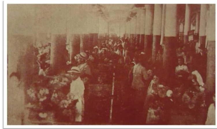
Figura 12. Galería de hortalizas y flores, construida en concreto armado.
