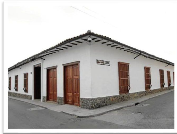
Figura 122. Fachada principal y lateral de la Casa del Libro Total ya restaurada.
