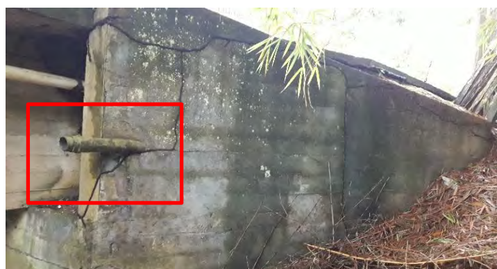
Imagen No. 154641. Junta fria, organismos vegetales, perforación para tubería de PVC de 4" abierta
