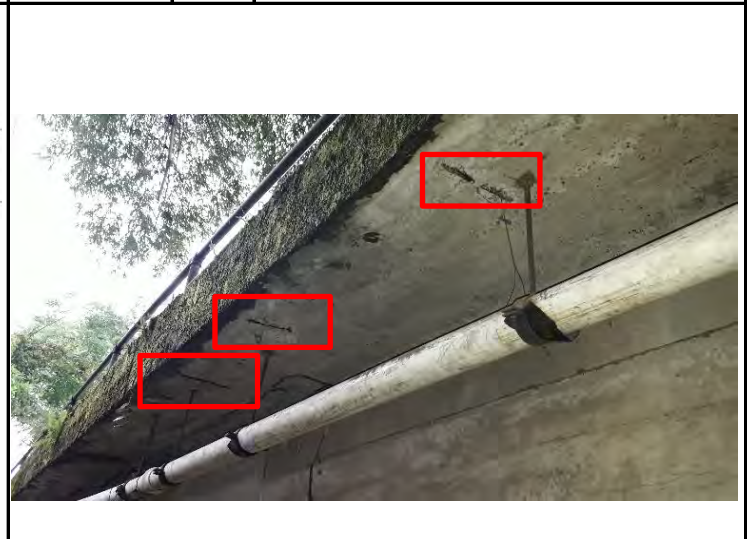
Imagen No. 171853. Acero de refuerzo a la vista bajo placa.
