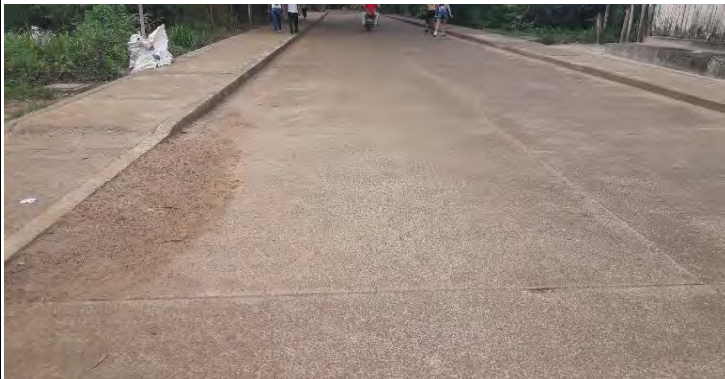
Imagen No. 02IL. Pérdida del macrotexturizado de la supercife, presencia de material granular
