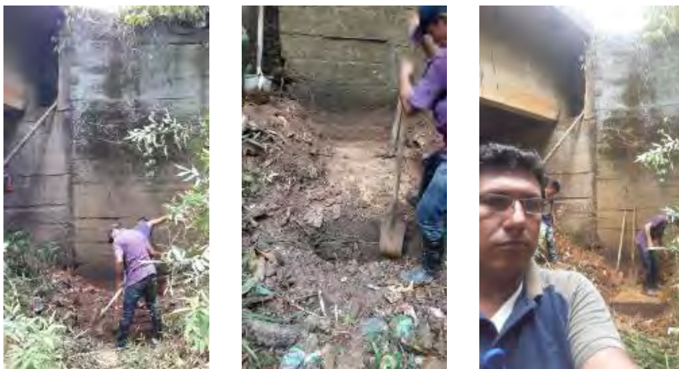
Figura 21. Apique de inspección para la cimentación del puente sobre el caño Danta.
