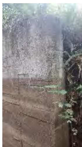
Aleta suroriental. No se evidencia presencia de fisuras. Tiene presencia de lesiones por suciedades y presencia de musgos y hongos.
