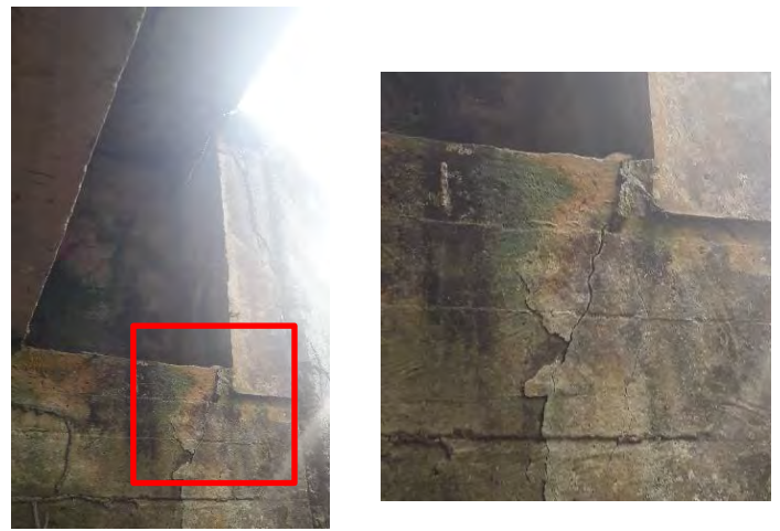
Imagen No. 154734. Fisura por cortante en el estribo.
