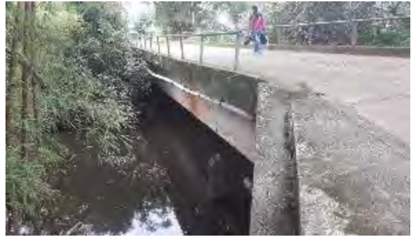
Costado oriental del puente sobre el caño danta. Se aprecia la viga principal, la aleta y barandas.
