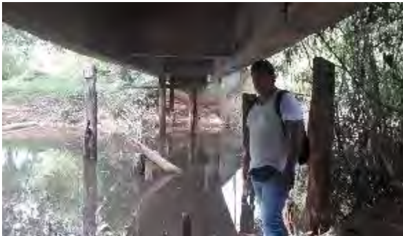
Imagen tomada desde el estribo sur. Se aprecia las vigas principales de 1.65 x .30m, riostras de 1.50m
