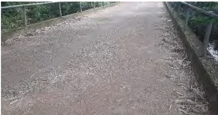
Imagen No. 150809. Aspecto del acabado de la superficie
