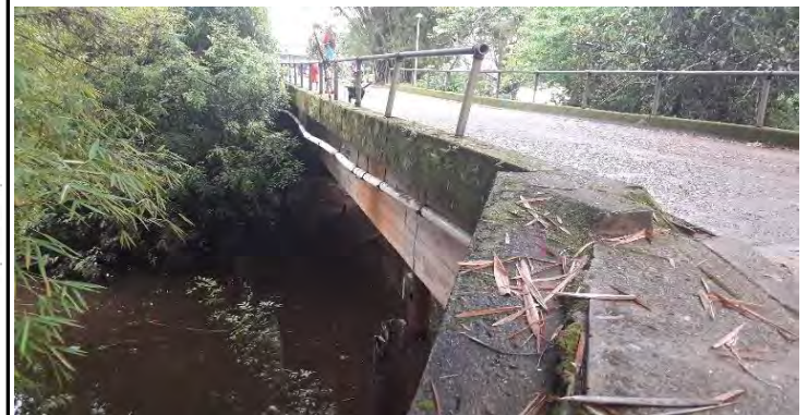
Imagen No. 171646. Ausencia de Elemento - Poste y baranda
