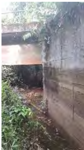
Aleta suroriental. No se evidencia presencia de fisuras. Tiene presencia de lesiones por suciedades y presencia de musgos y hongos.
