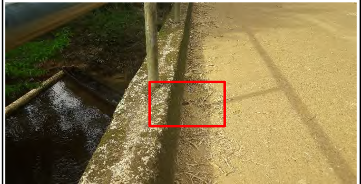
Imagen No. 150955. Salida de drenaje en tubería de PVC de 2 1/2" .
