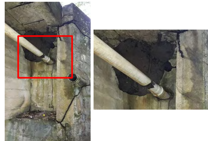
Imagen No. 171824. Perforación para tubería de PVC de 4" abierta sin resanar y presencia de insectos.
