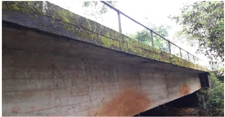
Imagen No. 172445. Presencia de organismos vegetales en las caras verticales de los bordillos.
