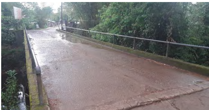
Imagen No. 155740. Taponamiento de salidas de drenaje - Costado derecho.
