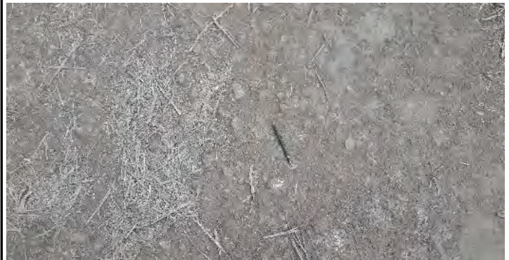
Imagen No. 150923. Aspecto del acabado de la superficie
