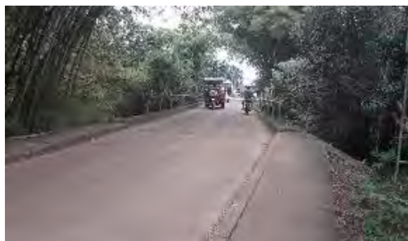
Zona de aproximación costado norte del puente. Construida en placas de concreto simple.
