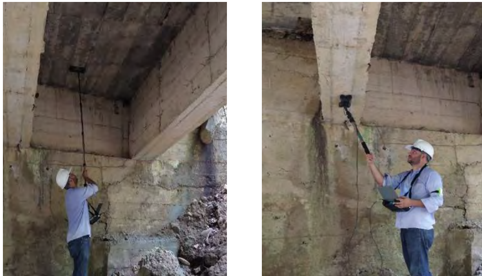
Figura 28. Lecturas con el sistema de detección de barras de refuerzo PROFOMETER 650 AI
