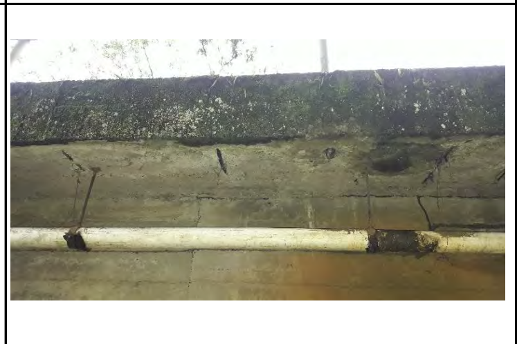
Imagen No. 171911. Suciedades y capa vegetal a lo largo de toda la cara vertical de la losa
