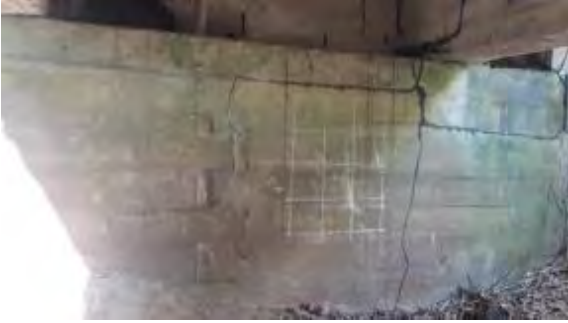
Ensayo de esclerometría en estribos.
