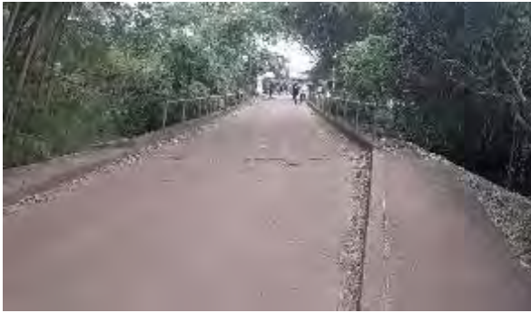
Puente sobre el caño Danta
