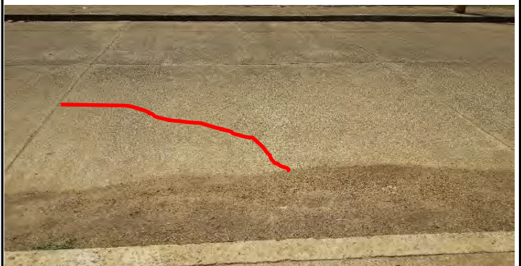
Imagen No. 02IT. Grieta en esquina, en la forma de la línea marcada.
