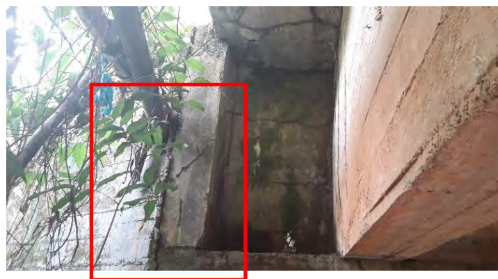
Imagen No. 154641. Junta fria, organismos vegetales, perforación para tubería de PVC de 4" abierta
