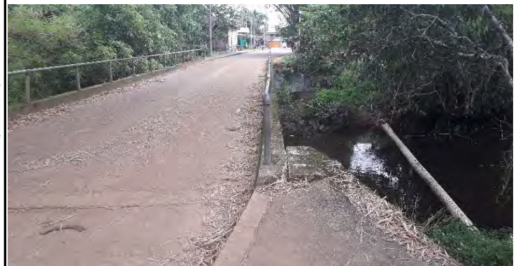
Imagen No. 162830. Baranda en tubería HF de 2 1/2". No tiene pintura.
