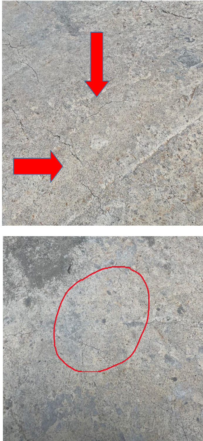
Figura 26. Contracción plástica
