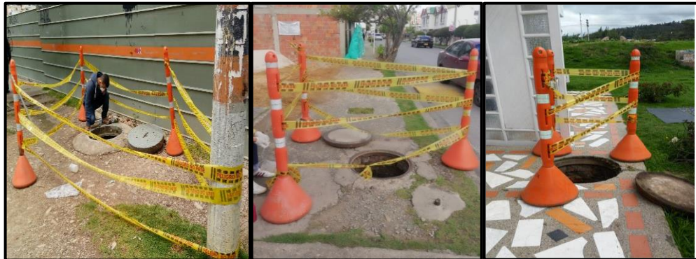
Figura 2 Señalización de pozos de inspección.
