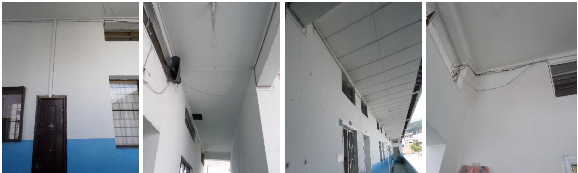
Figura 48. Instalación de canaleta y cableado, sala de profesores
