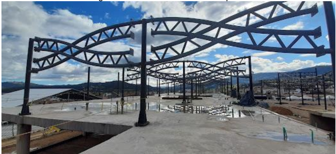
Figura 17.Estructura metálica - Bloque A
