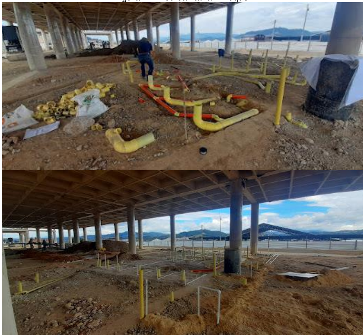
Figura 21. Red sanitaria - Bloque A
