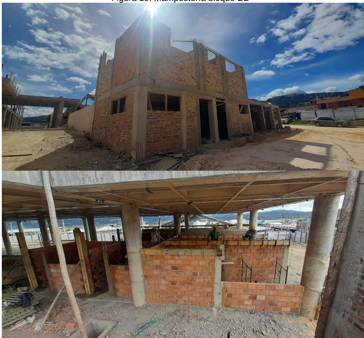
Figura 19. Mampostería bloque BB
