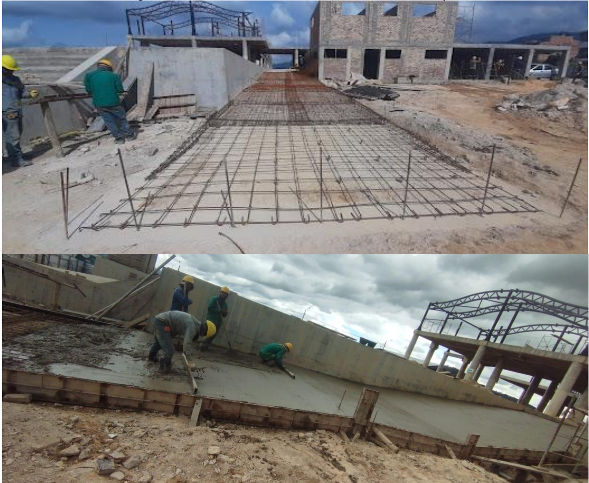
Figura 16. Armadura malla electrosoldada - Rampa 2
