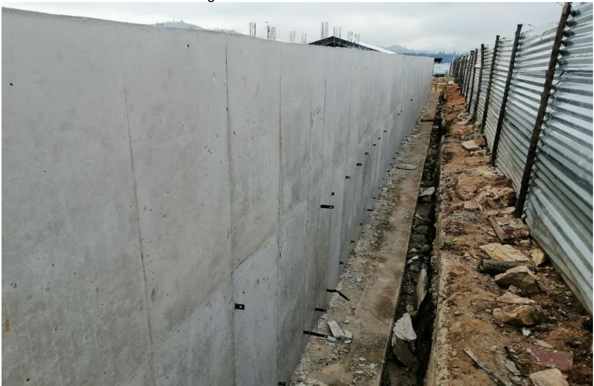
Figura 18. Muro de contención 6
