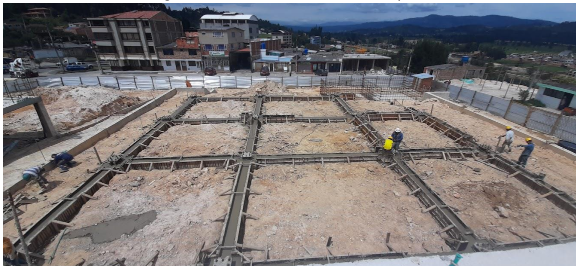
Figura 15. Cimentación fundida – Bloque B
