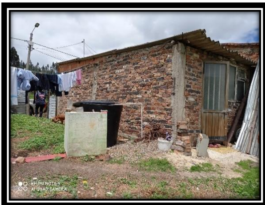
IMAGEN 11. Espacio para la construcción nueva alcoba
