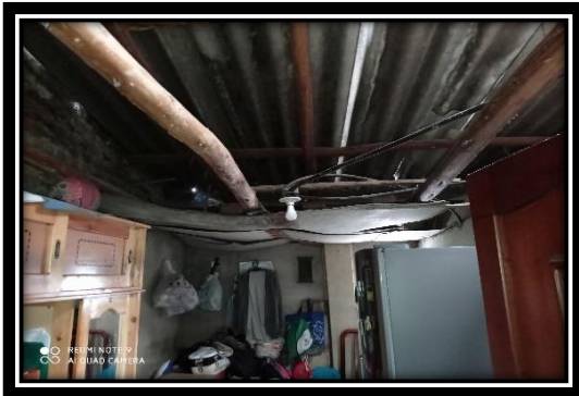
IMAGEN 16. Cubierta interior vivienda María del Carmen
