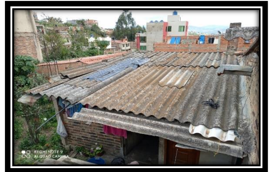
IMAGEN 15. Cubierta exterior vivienda María del Carmen
