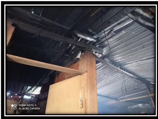
IMAGEN 26. Cubierta vivienda María Oliva Díaz
