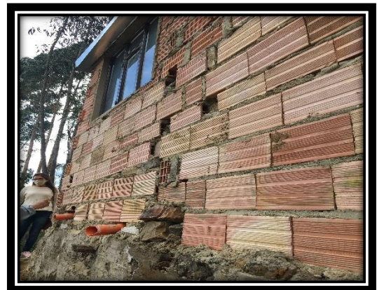
IMAGEN 75. Muros fachada vivienda María Lagos
