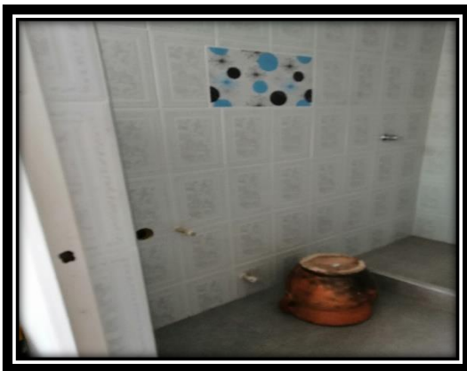
IMAGEN 48. Baño vivienda Gladys Corredor
