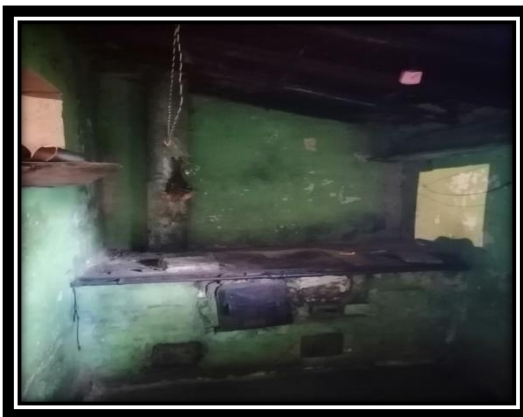
IMAGEN 56. Cocina vivienda Mercedes Torres
