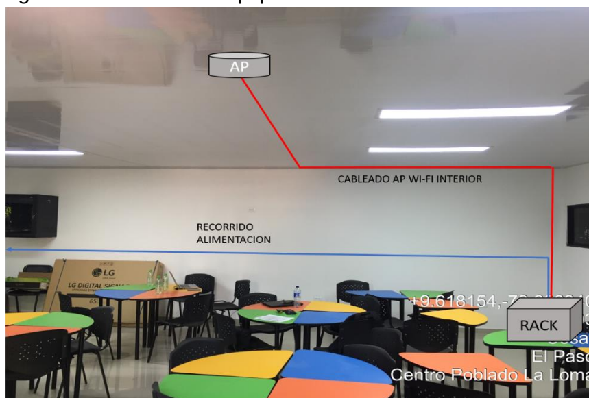
Figura 4. Ubicaciones equipos indoor institución educativa.
