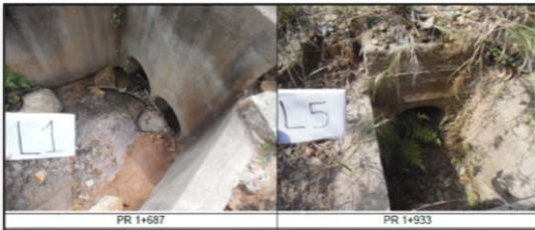
Imagen 13. Alcantarillas presentes en zona de estudio (25CC24-1-0G).
