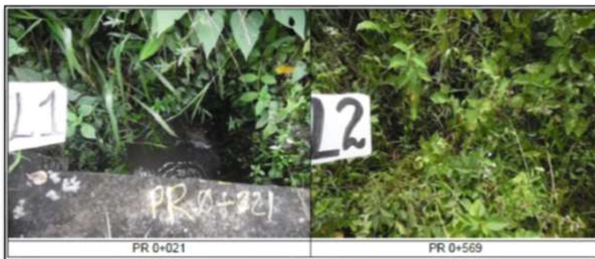
Imagen 16. Alcantarillas presentes en zona de estudio (25CC24-1-0G-1).
