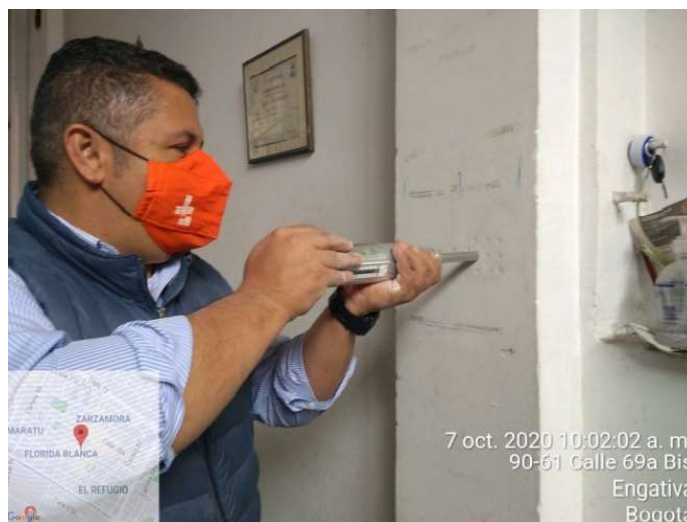
Ilustración 12 - Ensayo de esclerometría
