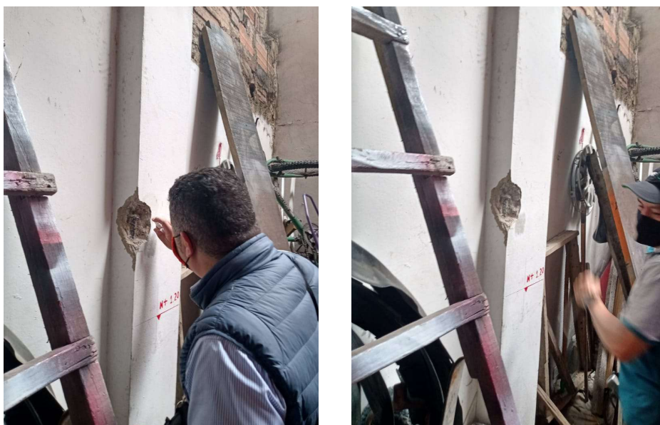
Ilustración 15 - Ensayo de Carbonatación
