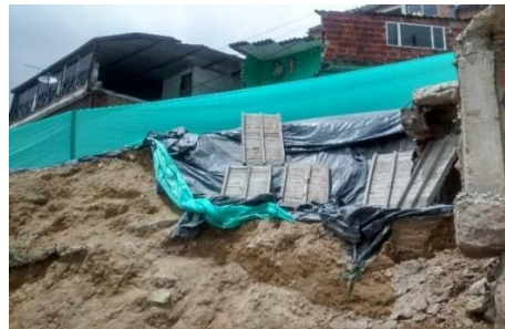
Fotografía 121: Protección con plásticos para evitar filtraciones de agua al talud.
