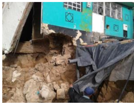
Fotografía 14: Arcillolita en el escarpe del movimiento de remoción y presencia de roca arenisca.
