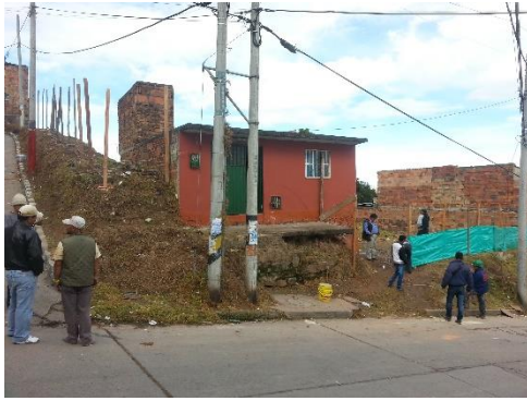
Fotografía 36: Cerramiento de la obra. Fuente: Constructor
