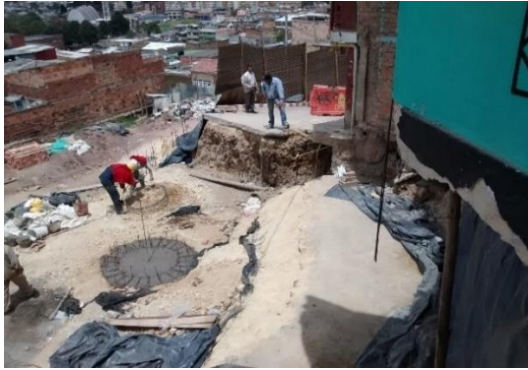
Fotografía 113: Reconstrucción de obras sanitarias.
