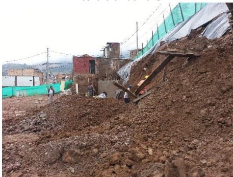
Fotografía 67: Aspecto del material resultante del corte del talud.
