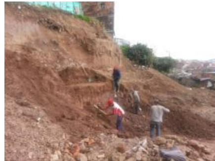
Fotografía 42: Intervención del talud. Fuente: Constructor
