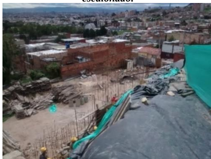
Fotografía 126: Avance de las obras de Construcción del muro de contención vistas desde la vía.
