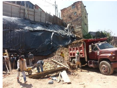
Fotografía 70: Verticalidad del talud resultante.
