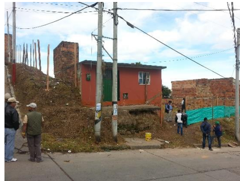
Fotografía 44: Instalación cerramiento. Julio 21 de 2014.
