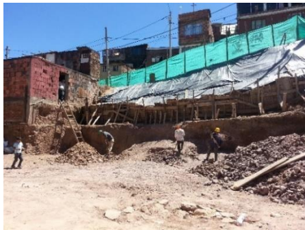
Fotografía 59: Aspecto del entibado y de los trabajos de corte del talud. Enero 3 de 2015.
