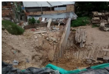
Fotografía 123: Muro de contención del costado sur.
