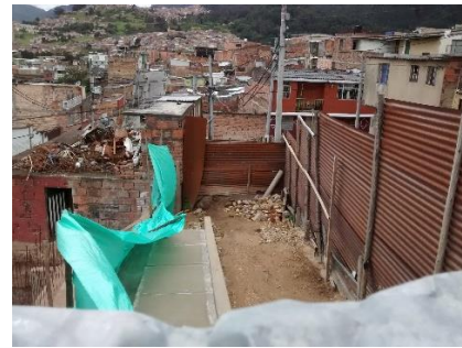
Fotografía 139: Remate superior del muro y construcción de andenes.
