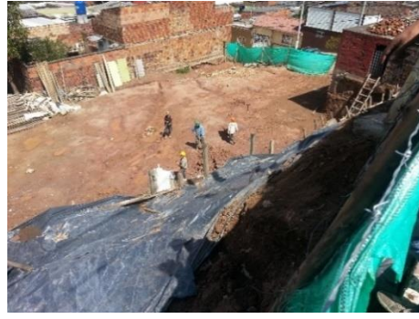
Fotografía 58: Estado del lote y avance de las obras. Diciembre 20 de 2014.
