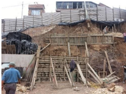
Fotografía 75: Fundición de muro de contención. Marzo 4 de 2015.
