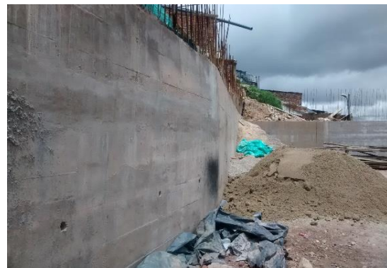
Fotografía 117: Prolongación del muro de contención.
