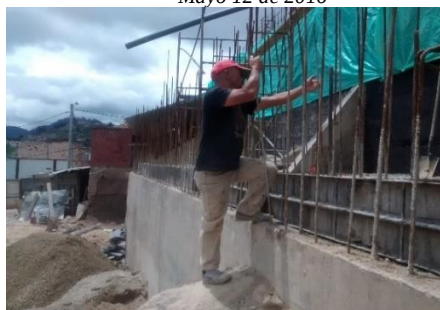
Fotografía 118: Prolongación y construcción del muro de contención escalonado con sistema de contrafuertes.
