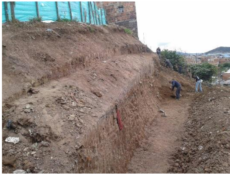
Fotografía 51: Corte del talud.
