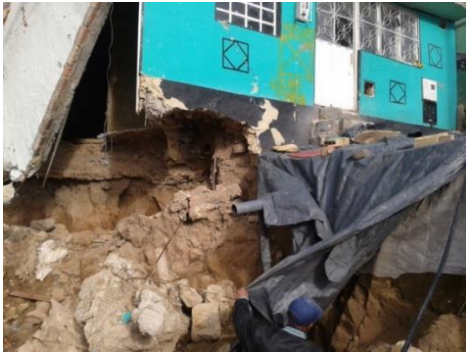
Fotografía 101: Estado de la Cimentación de casa afectada.
