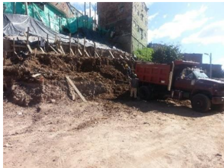
Fotografía 61: Retiro de material de corte del talud. Enero 6 de 2015.
