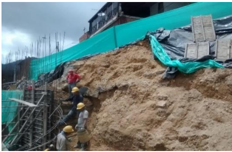
Fotografía 120: Construcción de muro de contención escalonado.
