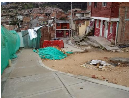
Fotografía 140: Remate superior del muro y construcción de andenes.
