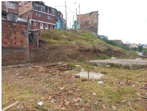
Fotografía 43: Instalación cerramiento. Julio 21 de 2014.
