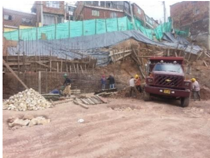
Fotografía 65: Construcción del muro de contención.
