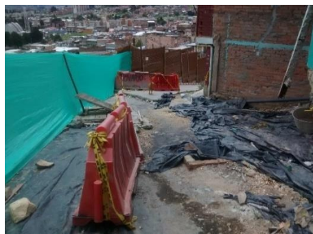
Fotografía 125: Aspecto de la reconstrucción vía en el tramo destruido.
