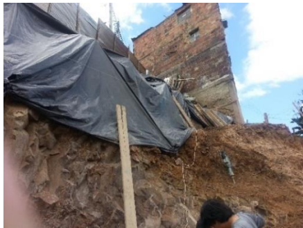
Fotografía 73: Proceso de taladrado de la roca arenisca. Febrero 28 de 2015.
