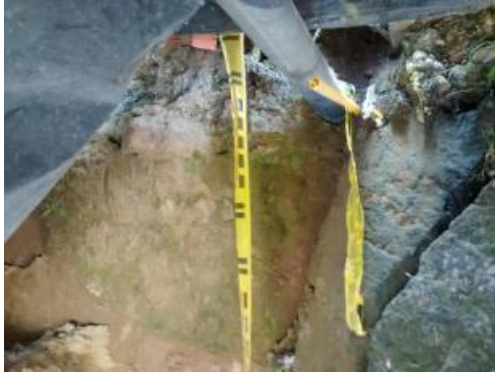
Fotografía 21: Arcillolita y Arenisca fracturada.
