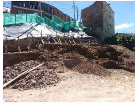
Fotografía 60: Aspecto del entibado y de los trabajos de corte del talud. Enero 3 de 2015.
