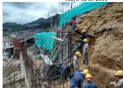
Fotografía 119: Construcción de muro de contención escalonado.
