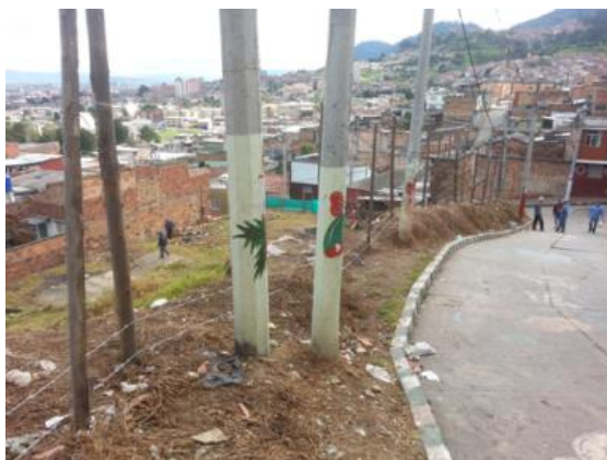
Fotografía 4: Aspecto de la Carrera 10 C ESTE antes del inicio del proyecto de construcción iglesia de San Blas.
