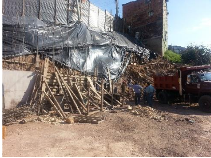
Fotografía 71: Fundición de nuevo tramo del muro de contención. Febrero 26 de 2015.
