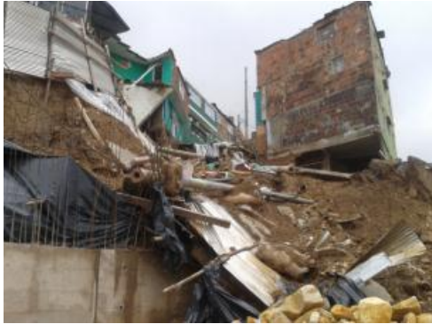
Fotografía 27: Zona del movimiento de remoción. Fuente: Autoría propia.
