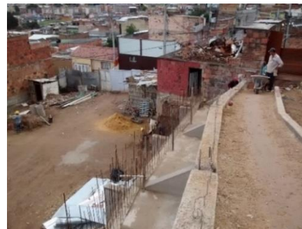
Fotografía 133: Construcción de andenes de la CARRERA 10C ESTE.
