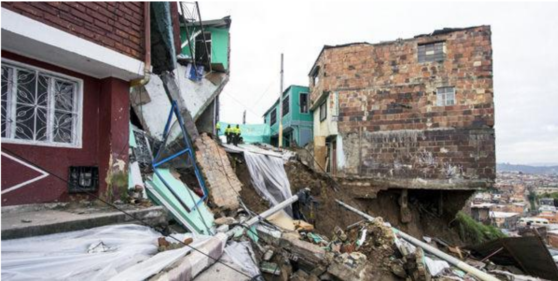
Fotografía 1: Pérdida de la banca de la vía Carrera 10 C ESTE producida por un movimiento de remoción en masa. (Fuente: El Tiempo, 23 de marzo de 2015, http://www.eltiempo.com/bogota/deslizamiento-de-tierra-en-san-cristobal/15446298 )
