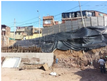
Fotografía 69: Corte para dar continuidad a la construcción del muro de contención.
