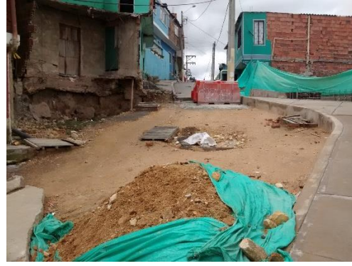
Fotografía 143: Restablecimiento de la base de la vía.
