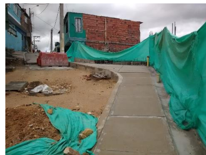
Fotografía 141: Remate superior del muro y construcción de andenes.
