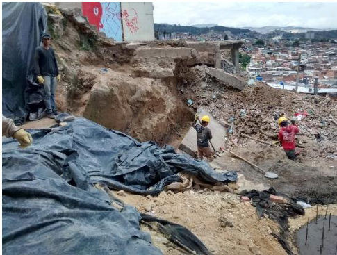
Fotografía 108: Adecuación manual de la parte superior del talud.
