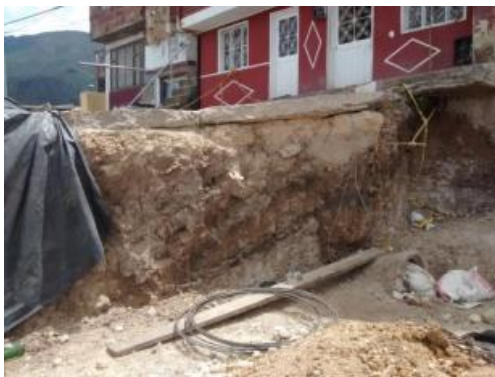
Fotografía 23: Base de la vía.
