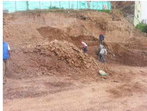
Fotografía 52: Corte del talud.
