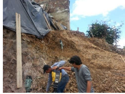
Fotografía 72: Taladrado de roca arenisca. Febrero 28 de 2015.
