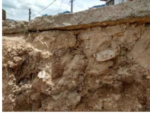
Fotografía 22: Base de la vía.
