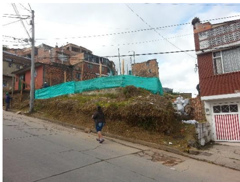
Fotografía 45: Instalación cerramiento. Julio 21 de 2014.
