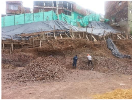
Fotografía 63: Corte manual del talud.
