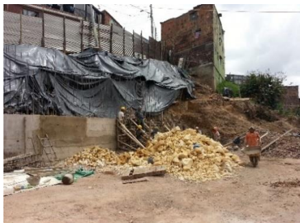
Fotografía 77: Construcción del muro de contención. Marzo 7 de 2015.
