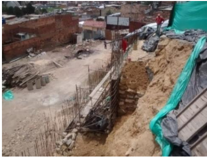
Fotografía 128: Vista de la construcción del muro de contención desde la CARRERA 10C ESTE.
