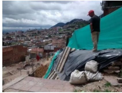
Fotografía 129: Protección de la parte superior del talud.
