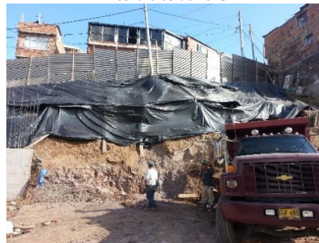
Fotografía 68: Corte para dar continuidad a la construcción del muro de contención.
