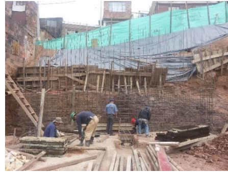
Fotografía 64: Inicio de la construcción del muro de contención.
