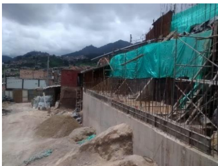
Fotografía 124: Construcción del muro de contención escalonado.
