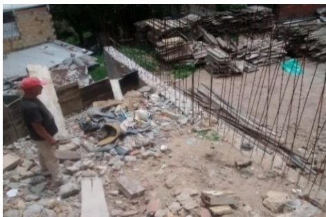
Fotografía 122: Construcción del muro de contención del costado sur.
