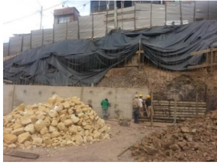
Fotografía 79: Instalación de formaletas para fundición de tramo del muro de contención.
