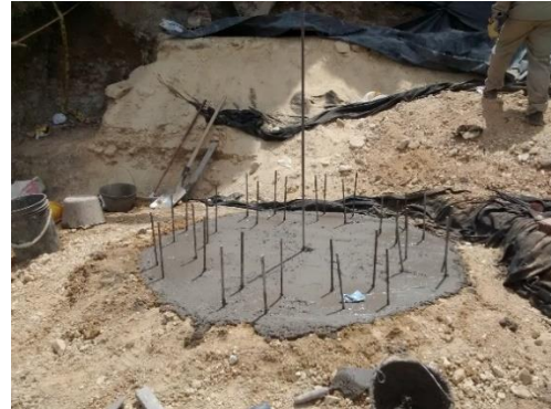
Fotografía 114: Reconstrucción de obras sanitarias.
