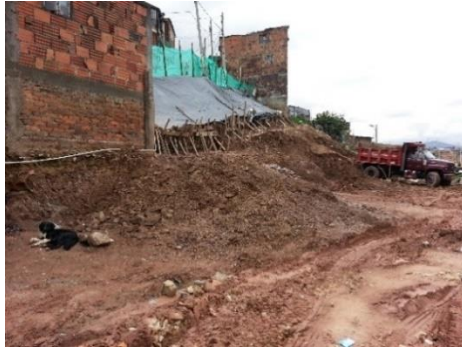
Fotografía 57: Corte y retiro de material del talud. Diciembre 13 de 2014.
