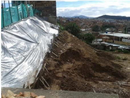
Fotografía 53: Entibado, corte y cubrimiento del talud.
