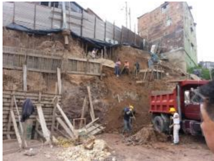
Fotografía 41: Intervención del talud. Fuente: Constructor
