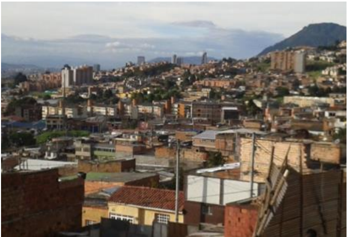
Fotografía 5: Panorámica de las edificaciones vecinas. Fuente: Elaboración propia.
