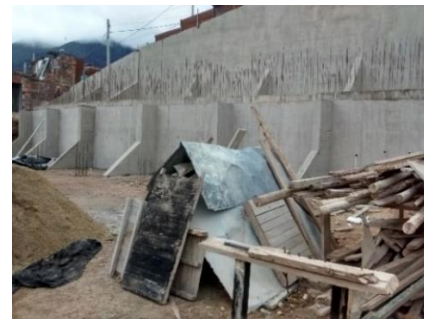
Fotografía 131: Muro de contención casi terminado. Se aprecia el sistema de contrafuertes.
