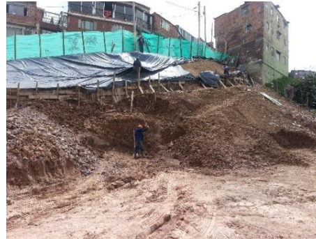
Fotografía 54: Entibado, corte y cubrimiento del talud.
