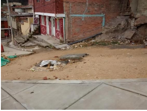
Fotografía 142: Restablecimiento de la base de la vía.
