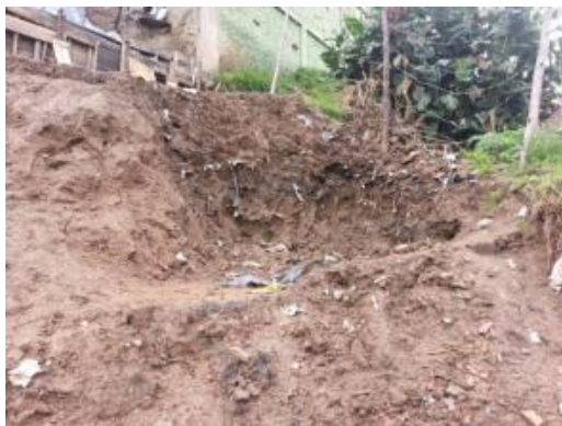
Fotografía 25: Intervención del talud.
