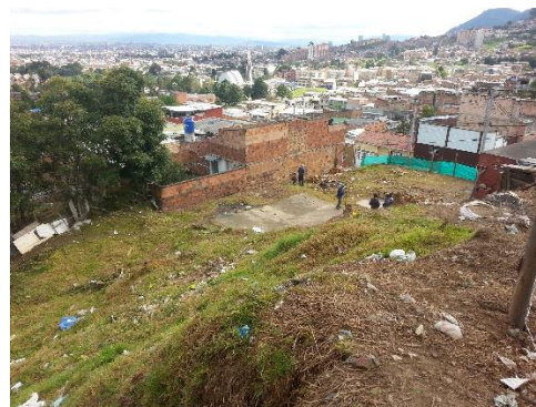
Fotografía 48: Instalación cerramiento. Julio 21 de 2014.
