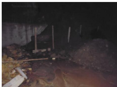
Fotografía 83: Socavación por debajo de las losas de la vía.
