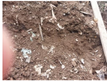
Fotografía 62: Basura presente en el material resultante del corte del talud. Enero 10 de 2015.
