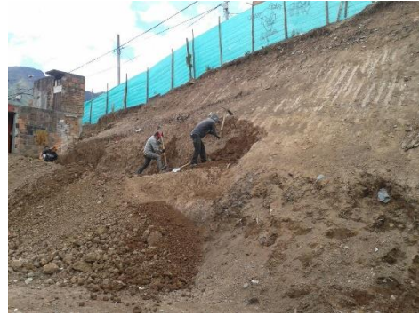
Fotografía 50: Corte del talud.
