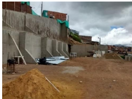
Fotografía 130: Muro de contención casi terminado. Al fondo el muro del costado sur.
