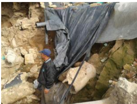
Fotografía 13: Arcillolita en el escarpe del movimiento de remoción y presencia de roca arenisca.
