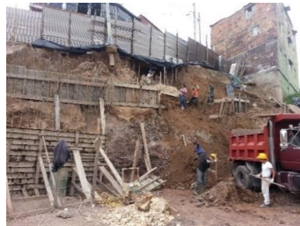
Fotografía 74: Apuntalamiento de las losas de la vía y restablecimiento del entibado. Marzo 4 de 2015.
