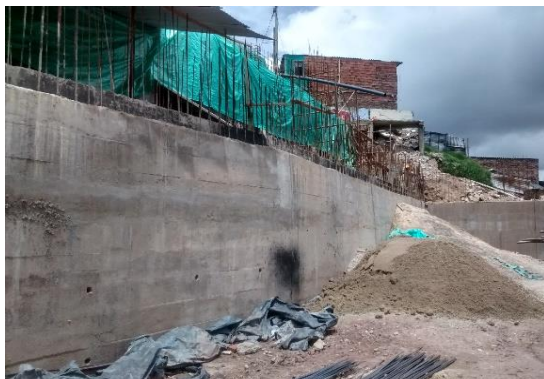
Fotografía 116: Prolongación del muro de contención.
