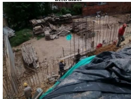
Fotografía 127: Empate perpendicular de los dos muros.
