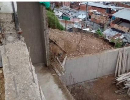
Fotografía 132: Empate de los dos muros.
