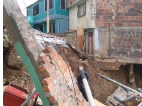
Fotografía 28: Varias viviendas se vieron severamente afectadas. Fuente: Autoría propia.
