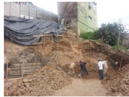
Fotografía 78: Excavación manual del talud. Marzo 12 de 2015.
