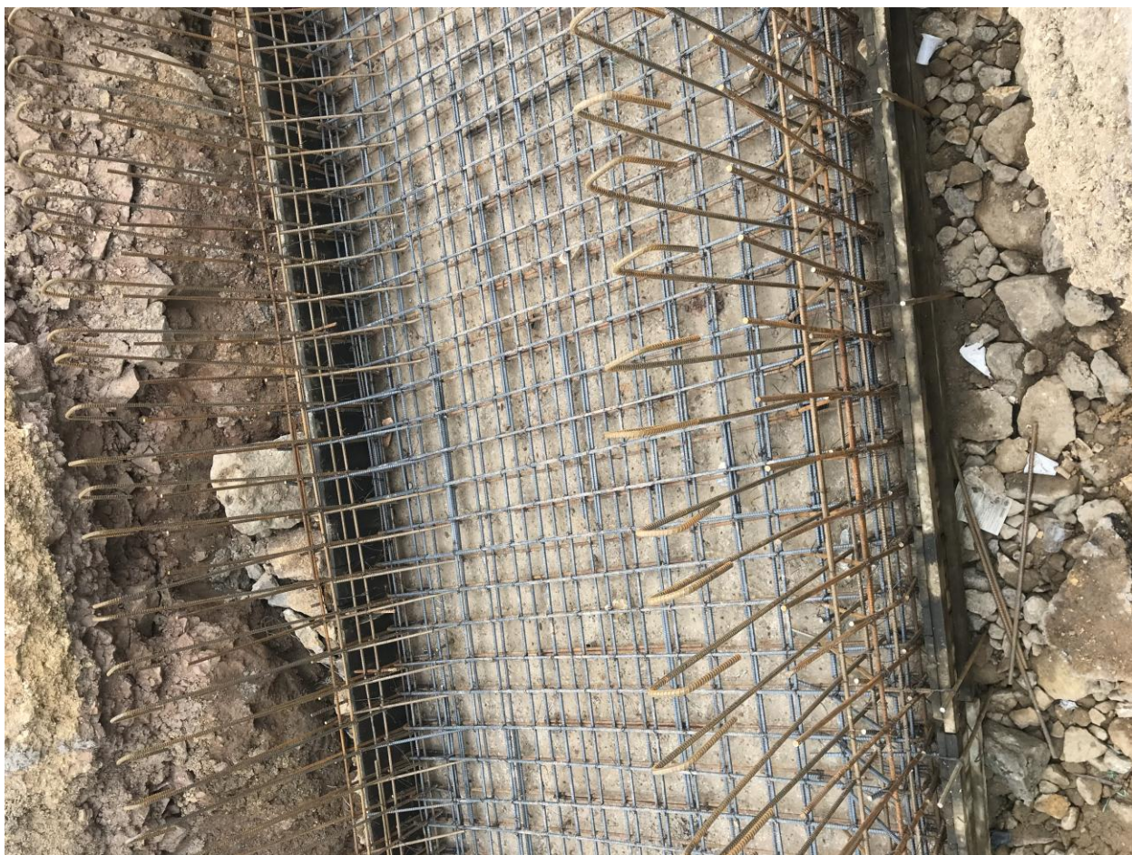
Imagen 10. Revisión de acero Box Culvert
