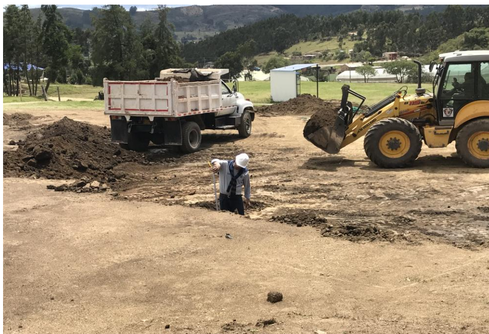
Imagen 3. Excavación cancha múltiple Ucuaca
