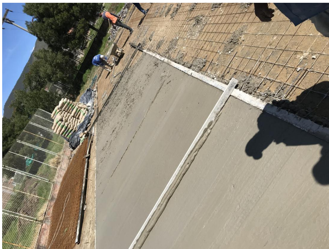
Imagen 6. Revisión de aceros y espesor de la placa.
