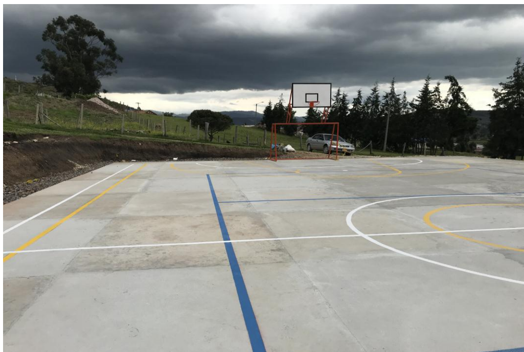
Imagen 4. Construcción cancha múltiple Ucuaca
