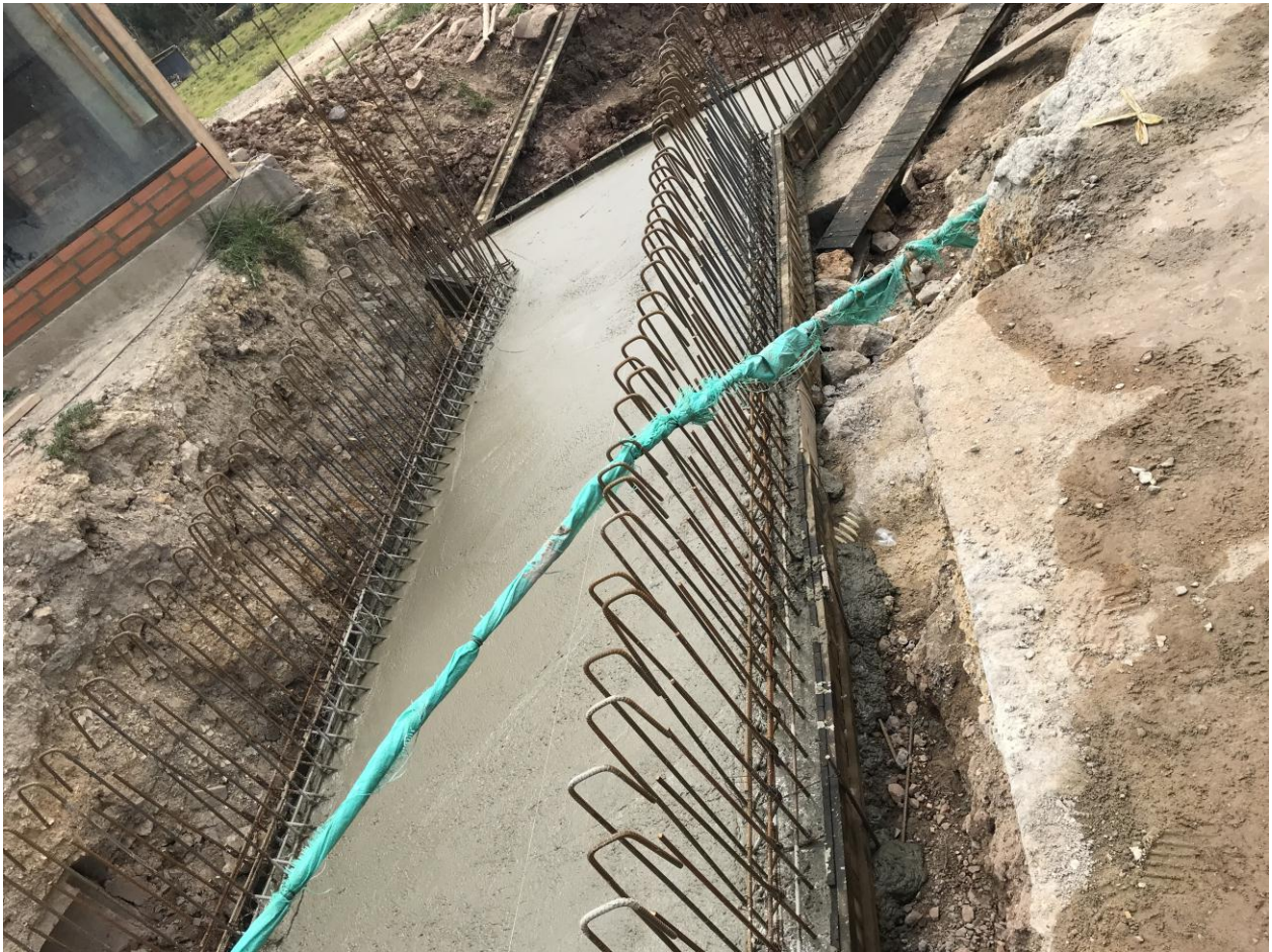
Imagen 11. Fundida placa inferior Box Culvert
