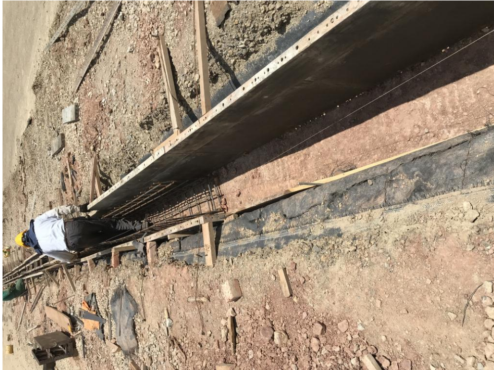
Imagen 9. Construcción cárcamo interno patinodromo
