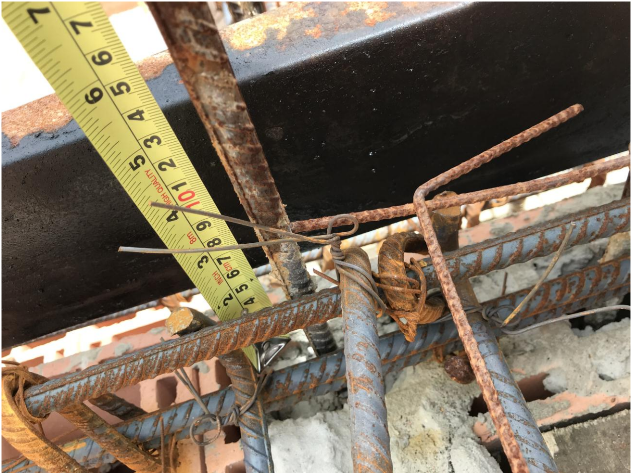
Imagen 15. Revisión longitud gancho
