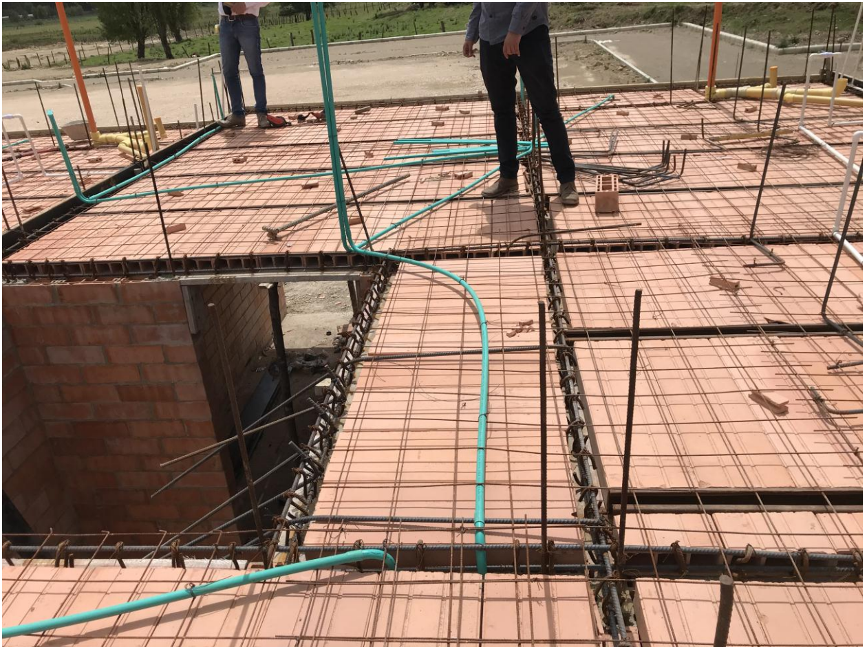
Imagen 14. Verificación de aceros
