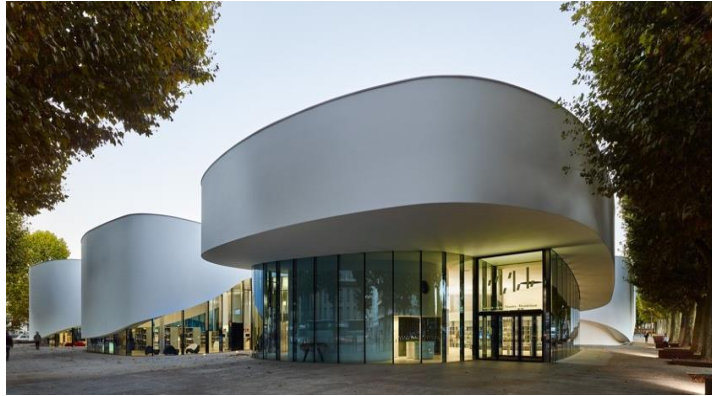
Figura 9. Fachada abierta en la recepción.
