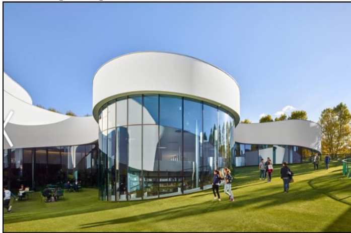
Figura 14. Rampa que sirve de espacio público.
