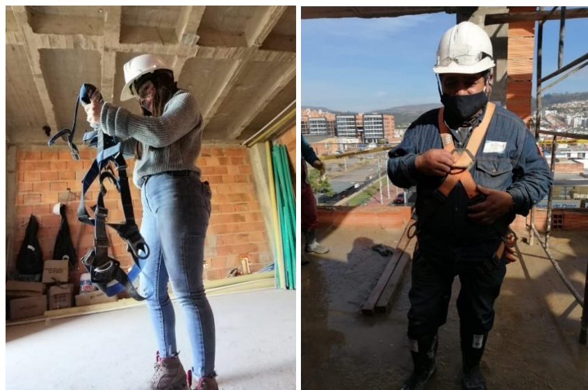
Fotografía 11 Inspección de equipos de seguridad de trabajo en alturas
