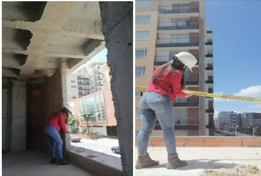
Fotografía 9 Inspección y verificación de señalización
