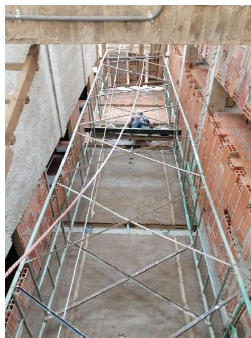
Fotografía 14 Supervisión de actividades eléctricas y pañete andamio tubular
