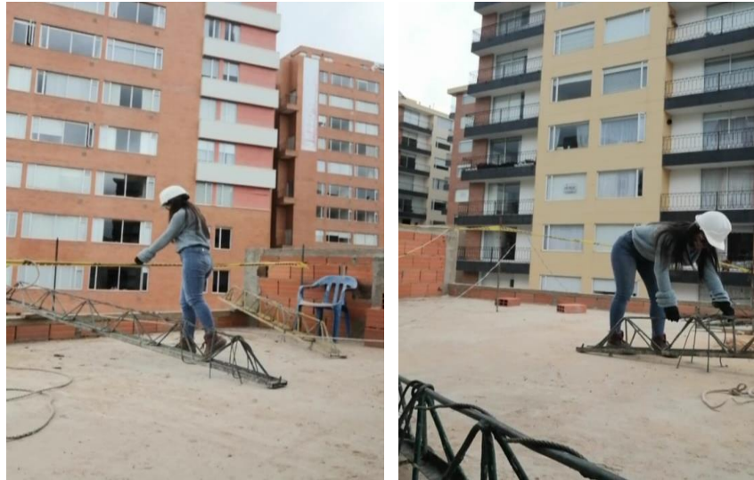
Fotografía 10 Inspección de anclajes
