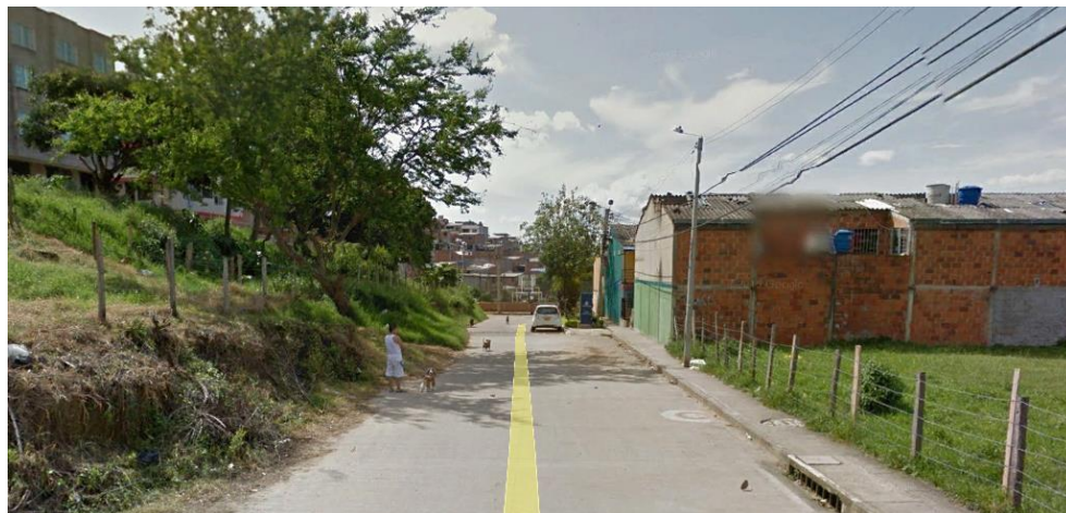
Figura 49. Registro fotográfico perfiles 1.
