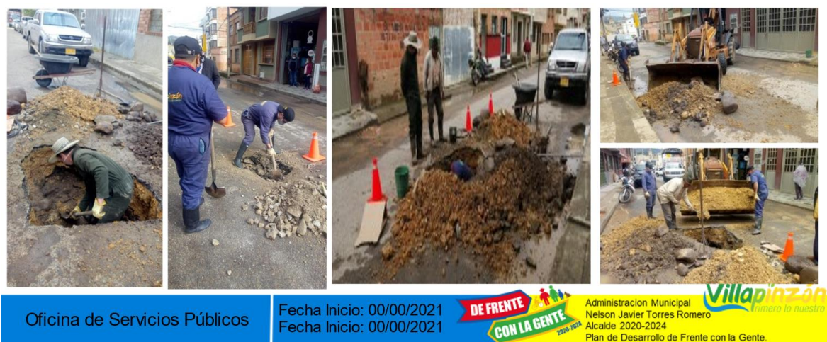
Ilustración 18 Residuos de Obras RCD
